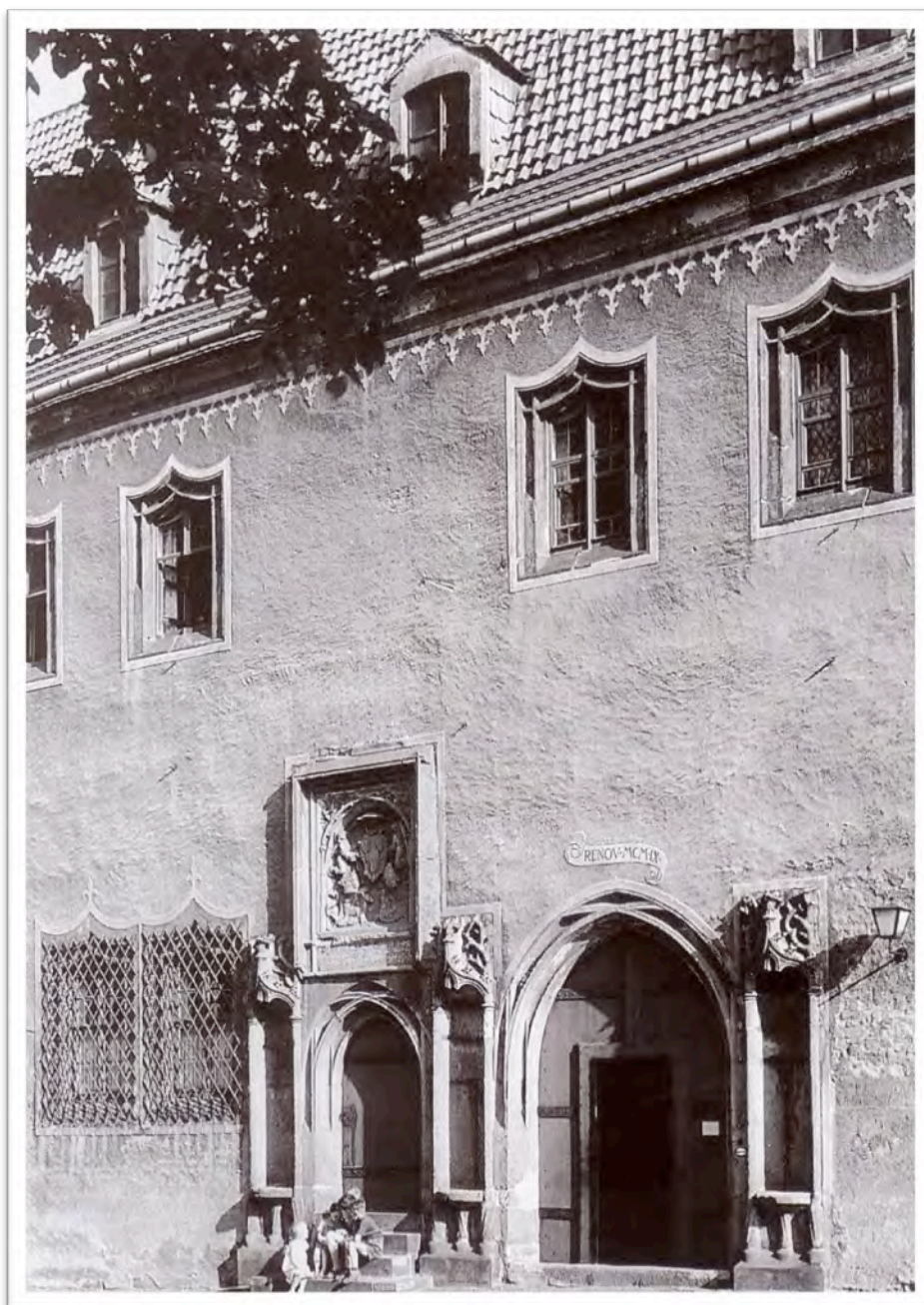
Vstupní průčelí probošství v Míšni (převzato z Radovi 1998). Povšimněte si záclonových oken a sedátkových portálů.
