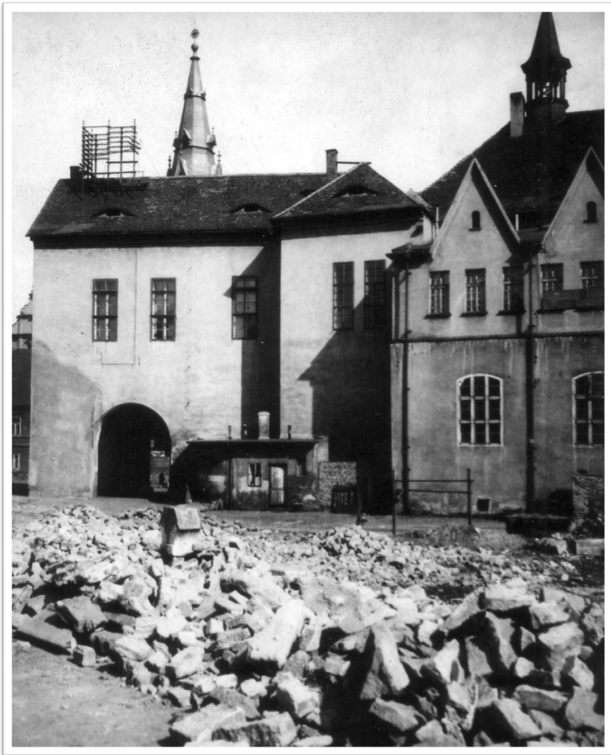
Pohled na radnici z doby po demolici západního křídla v l. 1946 - 47 (OM Chomutov). V popředí žalostné zbytky někdejšího pyšného sídla Veitmílů, pozdějšího zámku.
