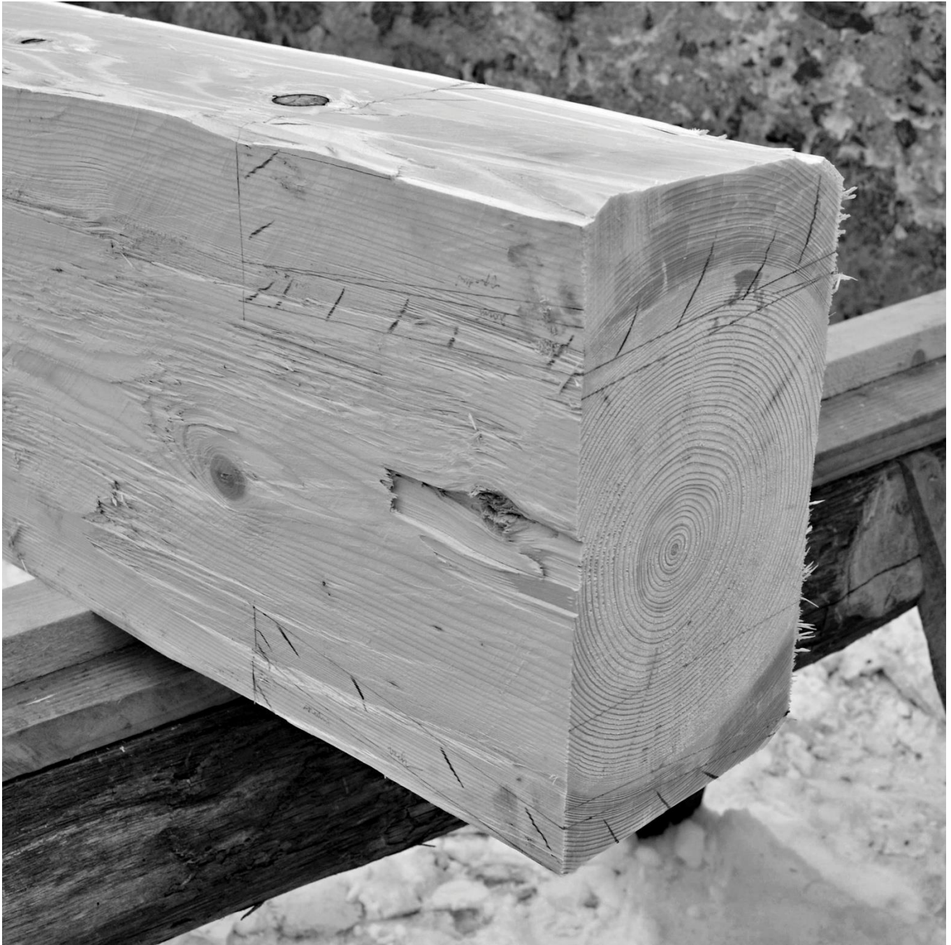
33 Proti předchozím obrázkům zůstaly beze změny jen rysky vertikálních řezů ohraničujících nárožní spoj. Linky na čelech jsou posunuty o 7 mm, na které se rozdělil nadměrek na seschnutí a na dopasování. K nim jsou přerýsovány linky dosedacích ploch nárožního spoje odpovídající měření u horních hran původního trámu.
