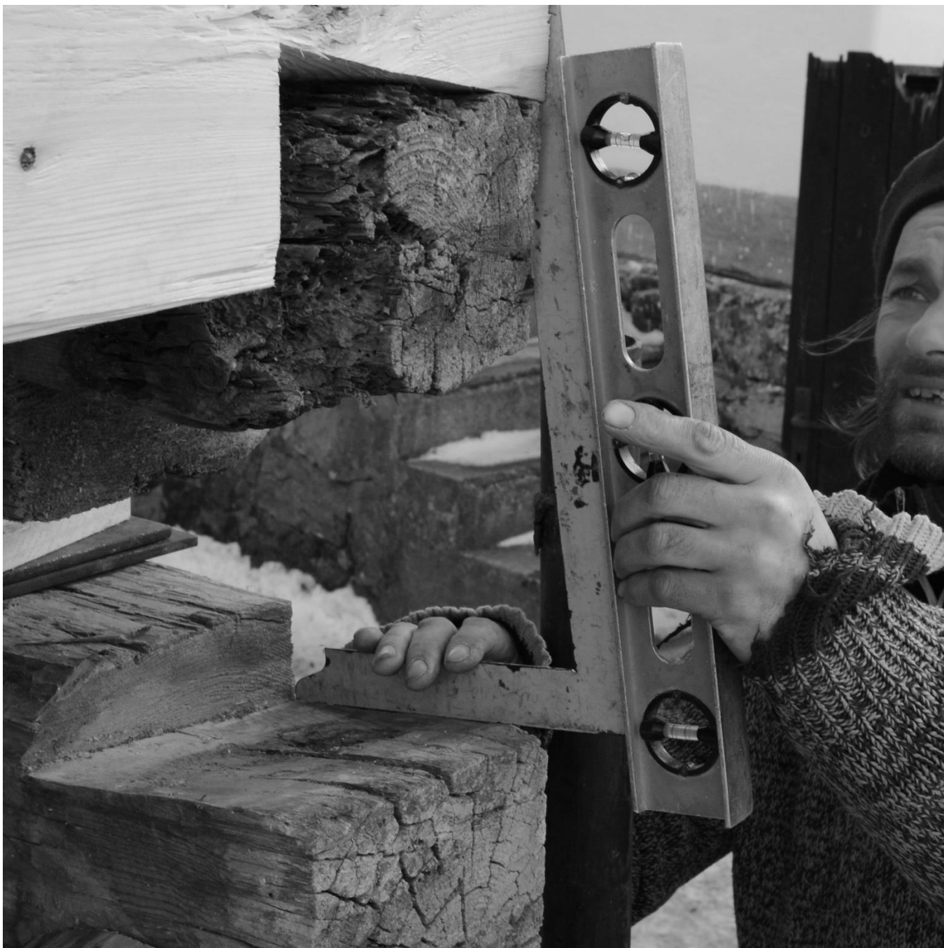
41 V nouzi si lze některé detaily znovu ověřit na trámech zafixovaných ve stavbě. Těžko by však bylo možné uvést tyto jednotlivosti do vzájemného vztahu snadněji a přesněji než okopírováním původní srubnice.
