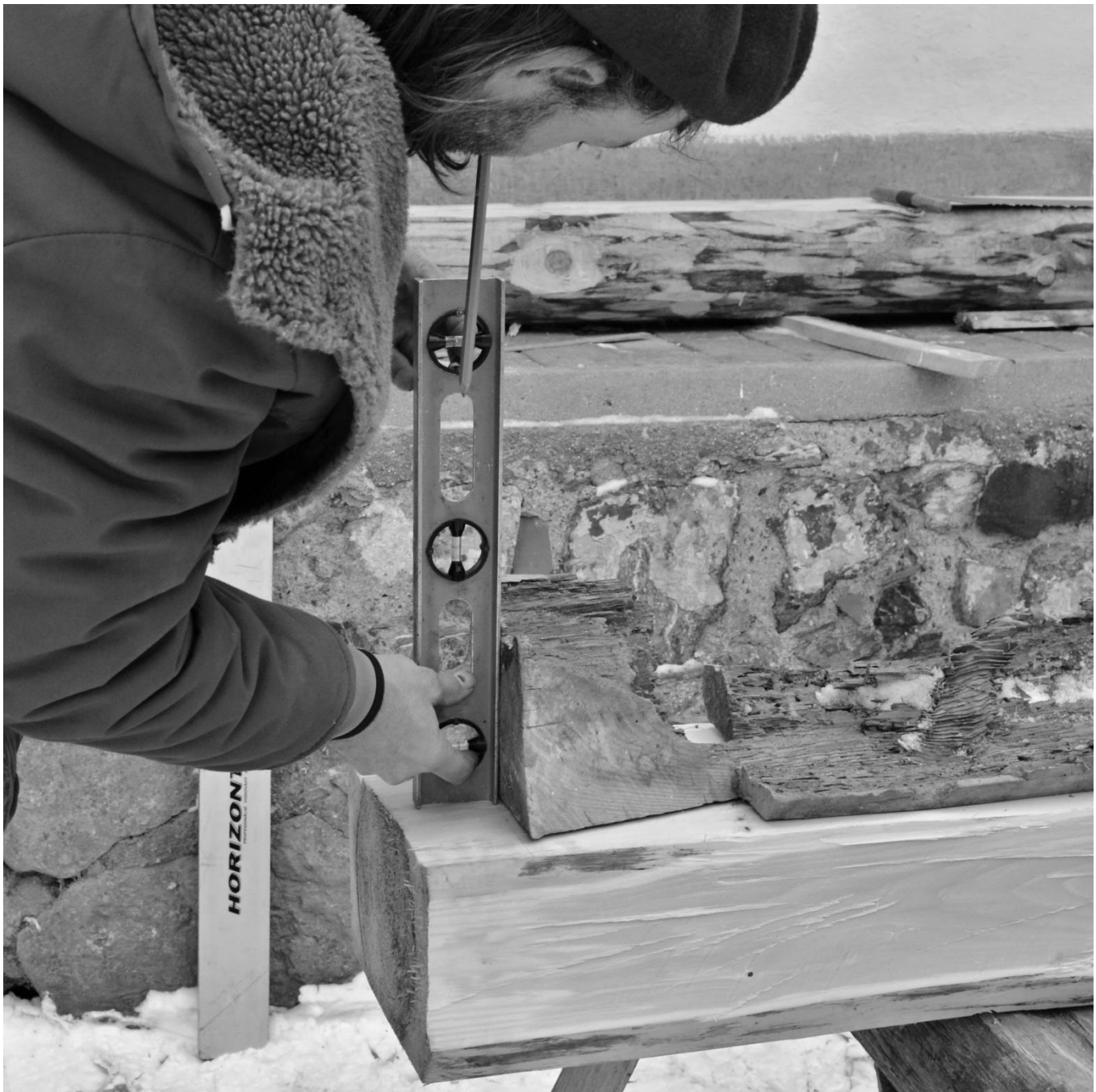
17 Protože svislým překopírováním získáváme i celkovou délku, nelze už druhou stranu polotovaru jen tak zaříznout bez předchozího rýsování.
