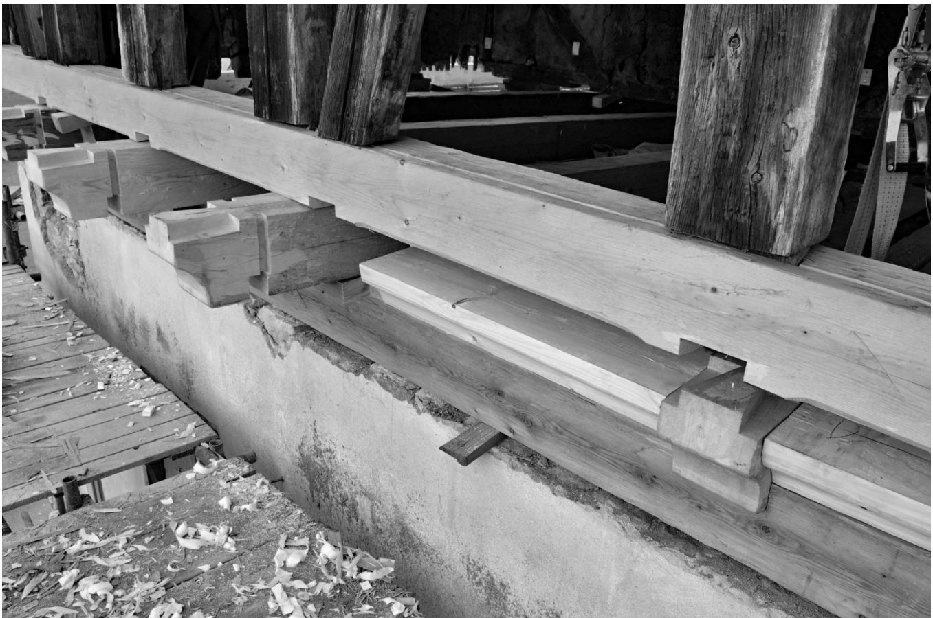
3 Ve chvíli, kdy pozici nových částí prahu a ližiny vůči sobě i zbytku stavby již pevně vymezovala řada spojů, zbývalo pod stěnu stále ještě vložit kolmou konstrukci podlahy. Z důvodu stísněného prostoru se spoje na nových podlahových trámech připravovaly na volném prostranství opodál, kdežto jejich párové části v podélných prazích přímo na ležení. Polohu spojů včetně sklonu rybin bylo tím pádem nutné přenášet jen pomocí měření. V úvahu tentokrát nepřicházelo ani jejich zkušební sesazení a vše tak muselo zapadnout bez větších nadměrků i vůlí. Vícenásobné spouštění vyheverované konstrukce by totiž stěnu na rozhraní zachované vyzdívky neúměrně namáhalo.
