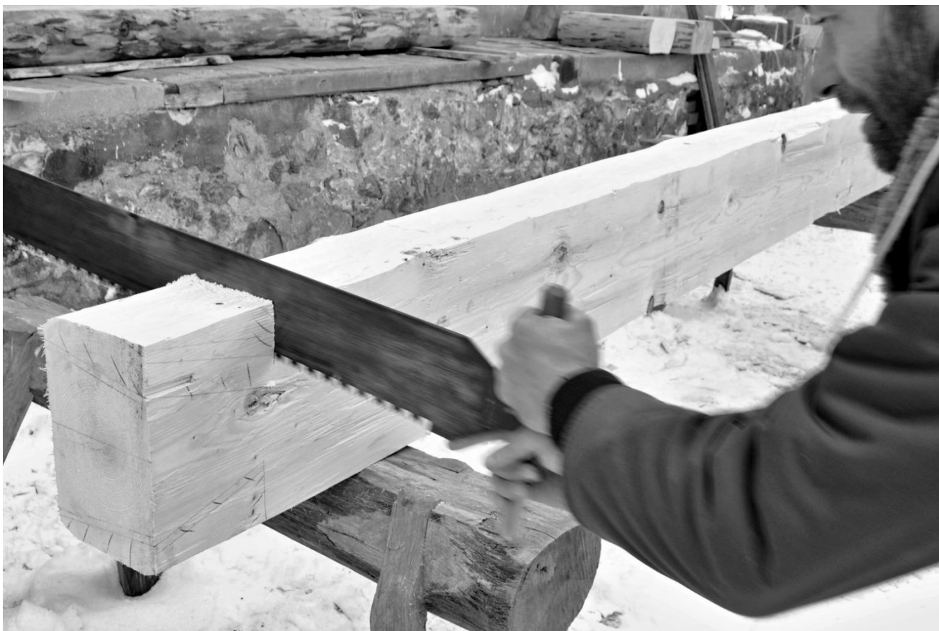
36 Poté, co jsme stejně vyrýsovali nárožní spoj na druhém konci srubnice, se můžeme pustit do výroby.
