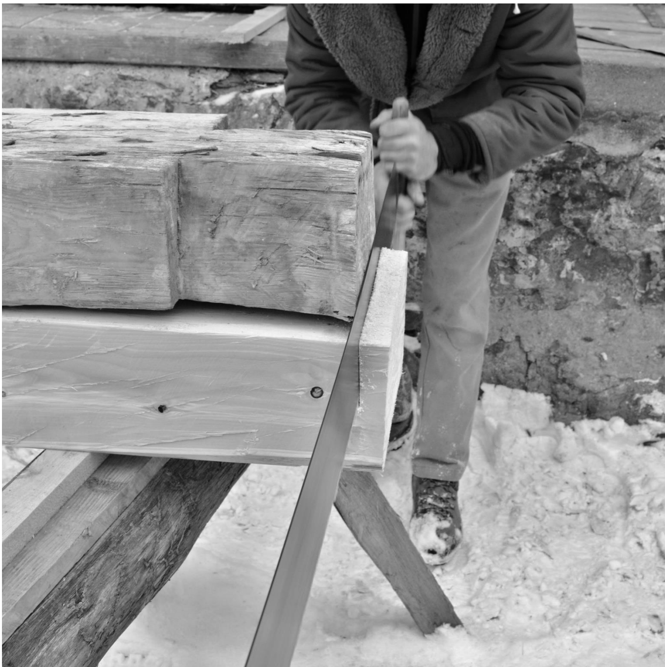
15 Pro první zaříznutí stačí pilu vést přímo po čele původní srubnice. Identicky skloněný řez pak mimo jiné svou trochou přispěje k uchování osobitého rázu stavby.
