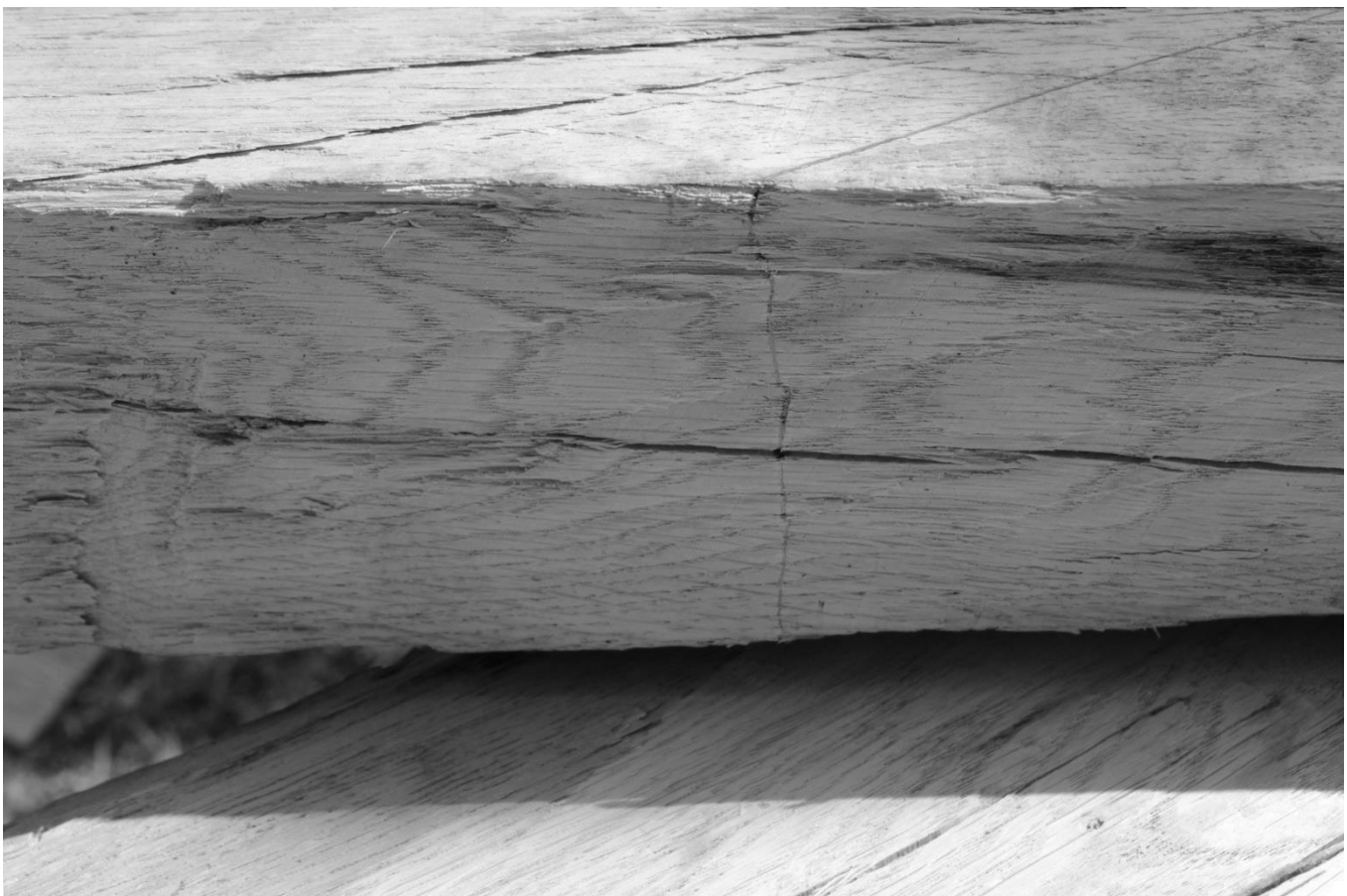
6 Z kolmého směru je však již patrná její deformace zapříčiněná nerovností povrchu. Pokud by boční plocha byla navíc u spodní hrany podsekaná, vyrýsovaná linka by se v těch místech stáčela směrem doprava. Kdyby spodní hrana z pravouhlého profilu trámu naopak vystupovala ven, uhýbala by tato linka ve spodní části nalevo. Při pohledu v rovině řezu by ovšem stále vytvářela iluzi dokonalé přímky.
