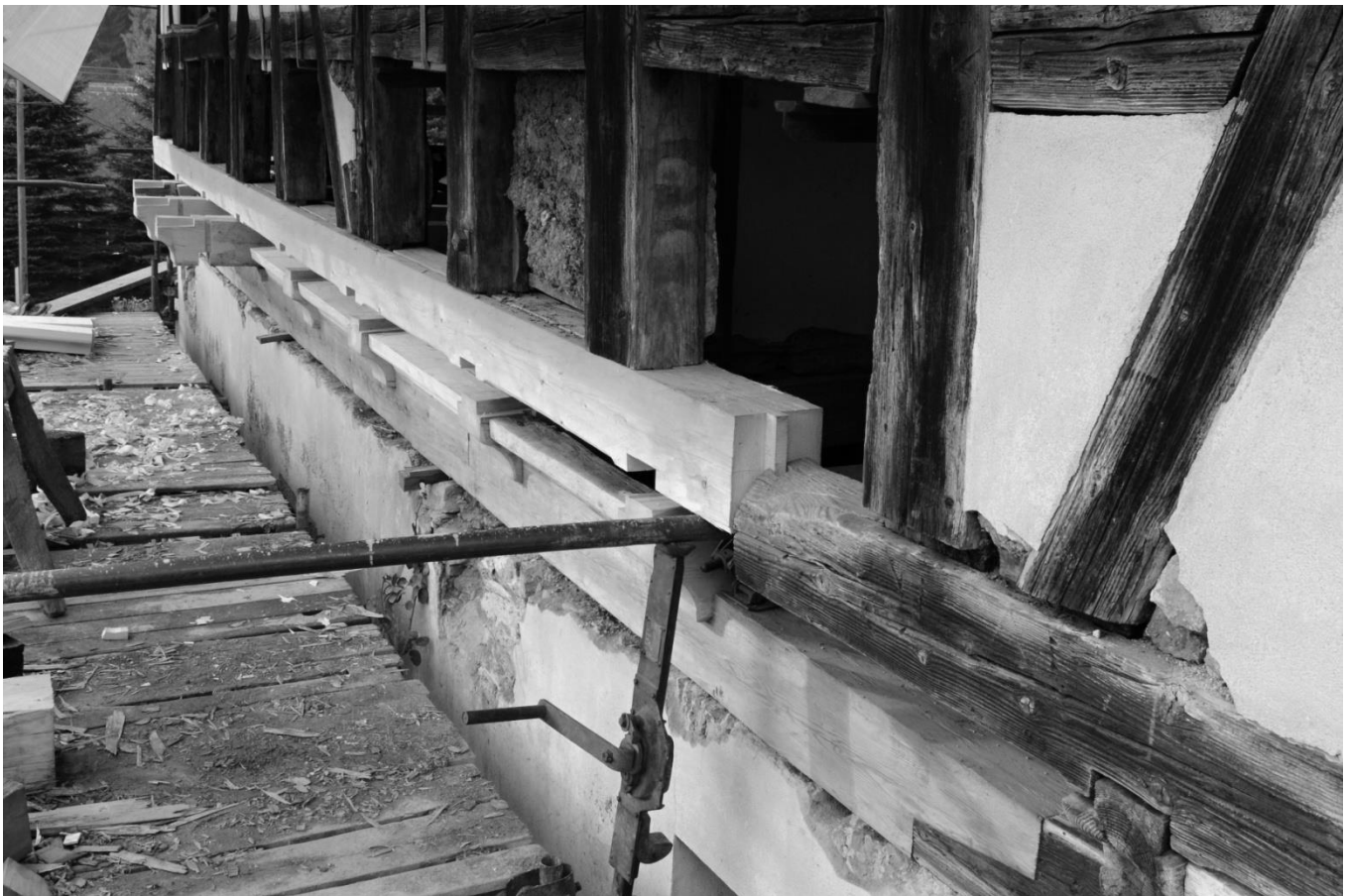
2 Ukázkově složité měření vyžadovala i tato oprava hrázděných stěn.
