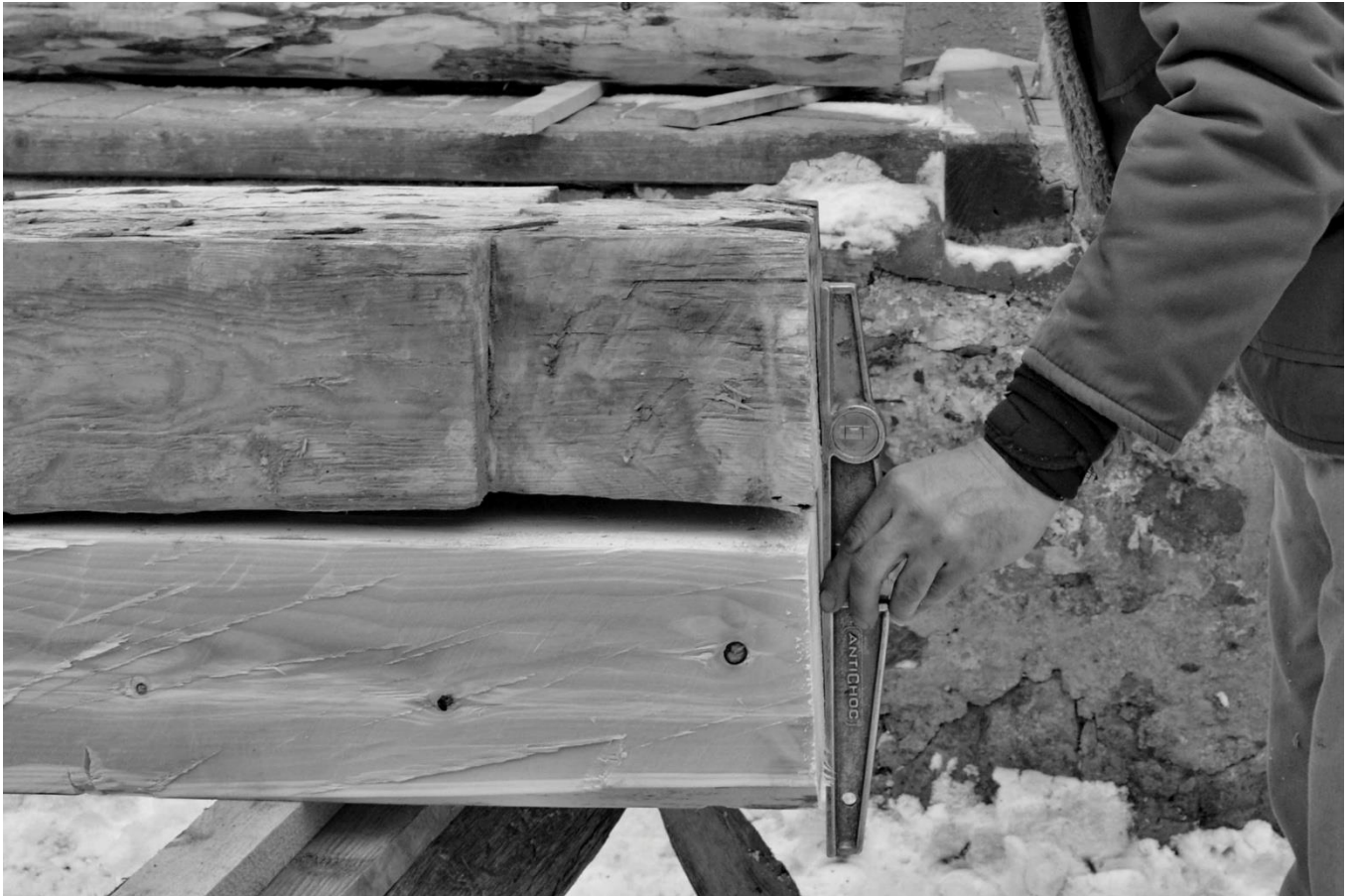
16 Poté hrany obou čel zarovnáme svisle pod sebe.
