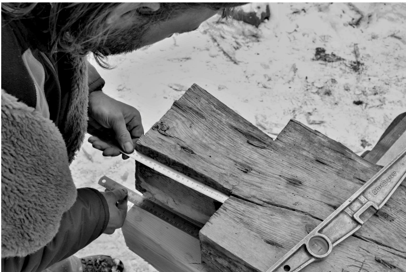
31 Plochy nárožních spojů vyrobených sekerou se více či méně stáčí. Proto na nový trám vyneseme ještě linku, představující rovnoběžku s dosedací plochou u horní hrany původní srubnice.
