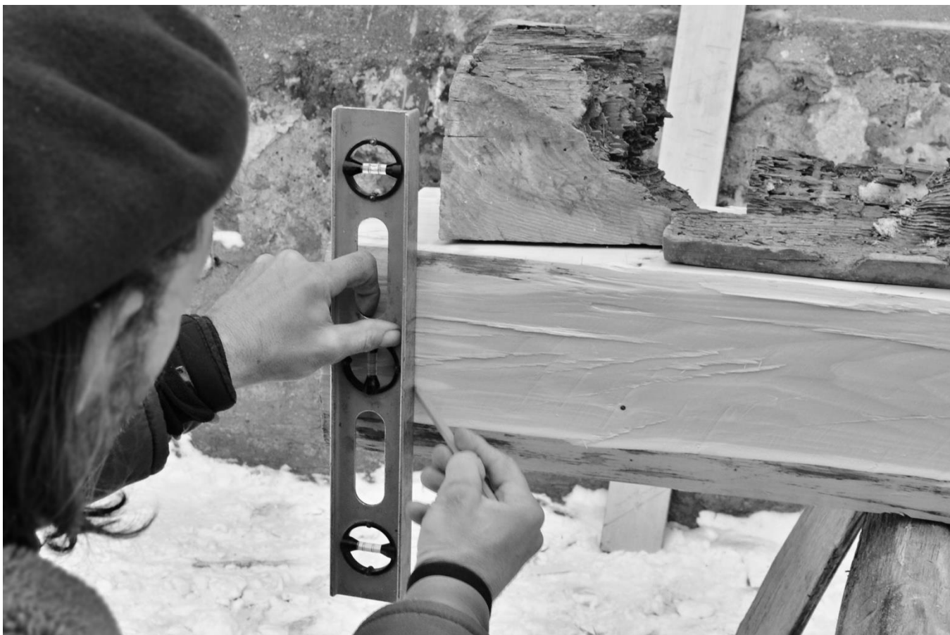
18 Na polotovar proto nejprve vyznačíme svisle přenesenou linii horní hrany vyřazené srubnice a k ní prostřednictvím vodováhy se stavitelnou libelou i původní sklon čela.
