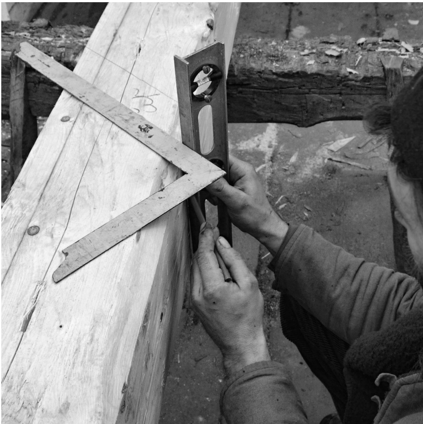
8 Plocha nárožního trámu se ale v místě spoje od svislice odchyľuje, takže k vyrýsování řezu využijeme i vodováhu s otočnou libelou.
