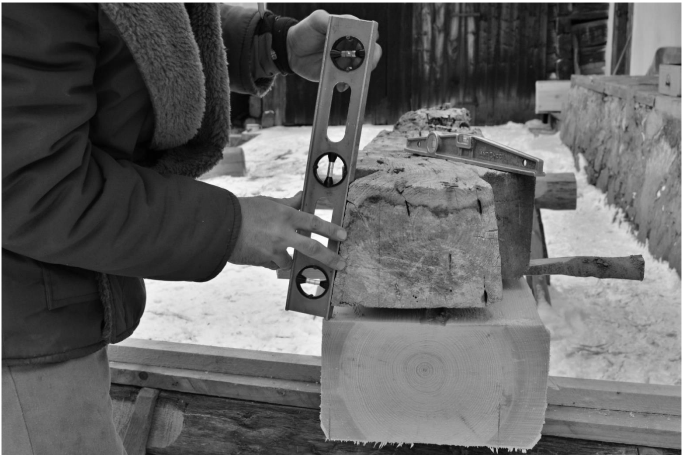
23 Následně podle sklonu původní rybiny nastavíme vodováhu s otočnou libelou.
