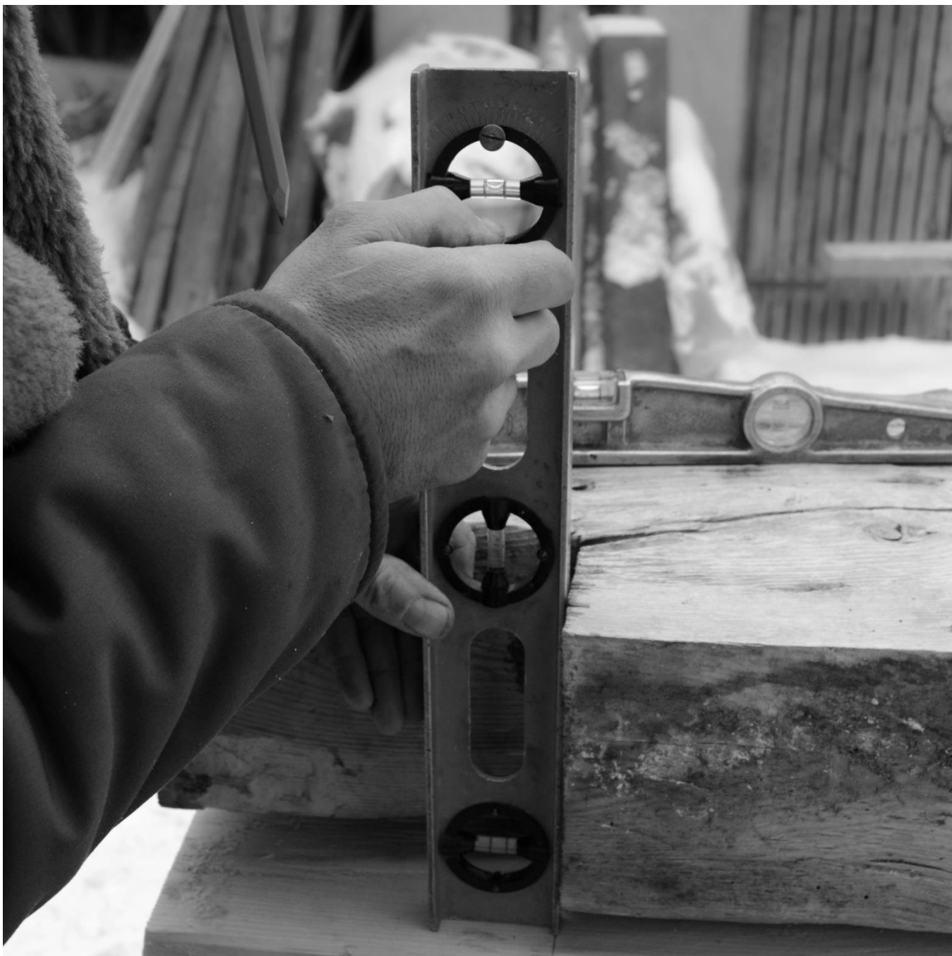
27 Otočnou libelu nastavíme podle původního řezu...
