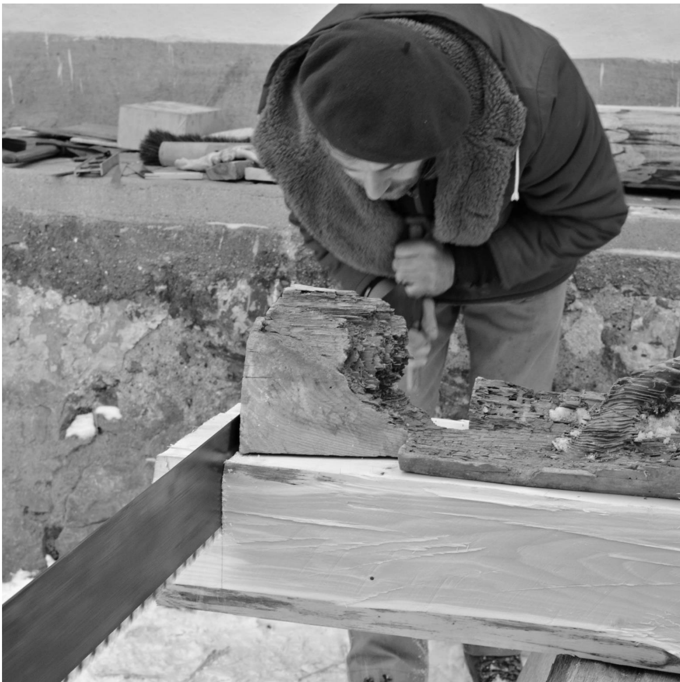
19 Přestože se zdá nepodstatné, jestli čelo zakrátíme stejně nebo o kousek vedle, musíme si uvědomit, že na něj budeme záhy přenášet šířku rybiny, která se vztahuje pouze ke konkrétní délce.
