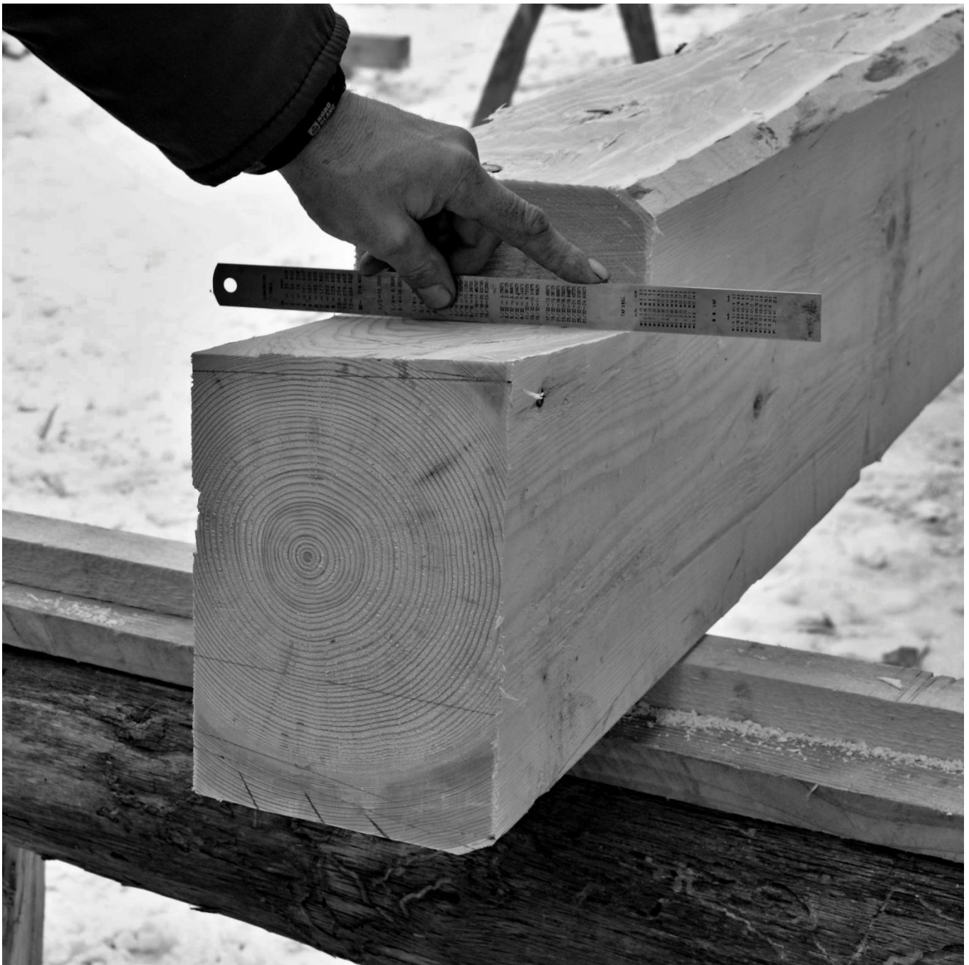
39 Kontrola roviny dosedací plochy nárožního spoje nové srubnice
