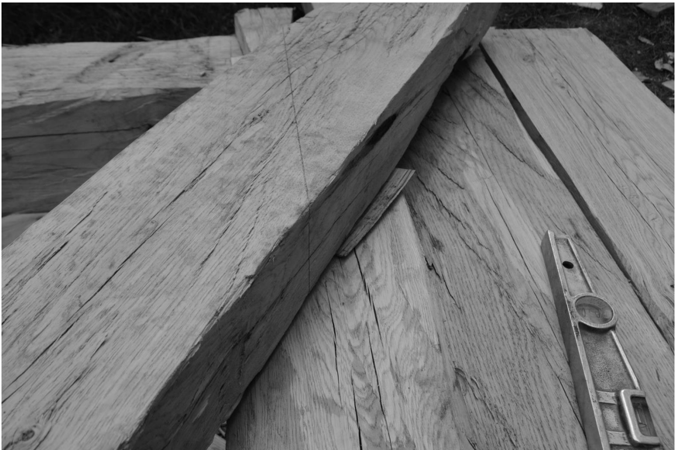
5 Linka na boku hrubě natesaného trámu se při pohledu v rovině řezu jeví jako dokonalá přímka.
