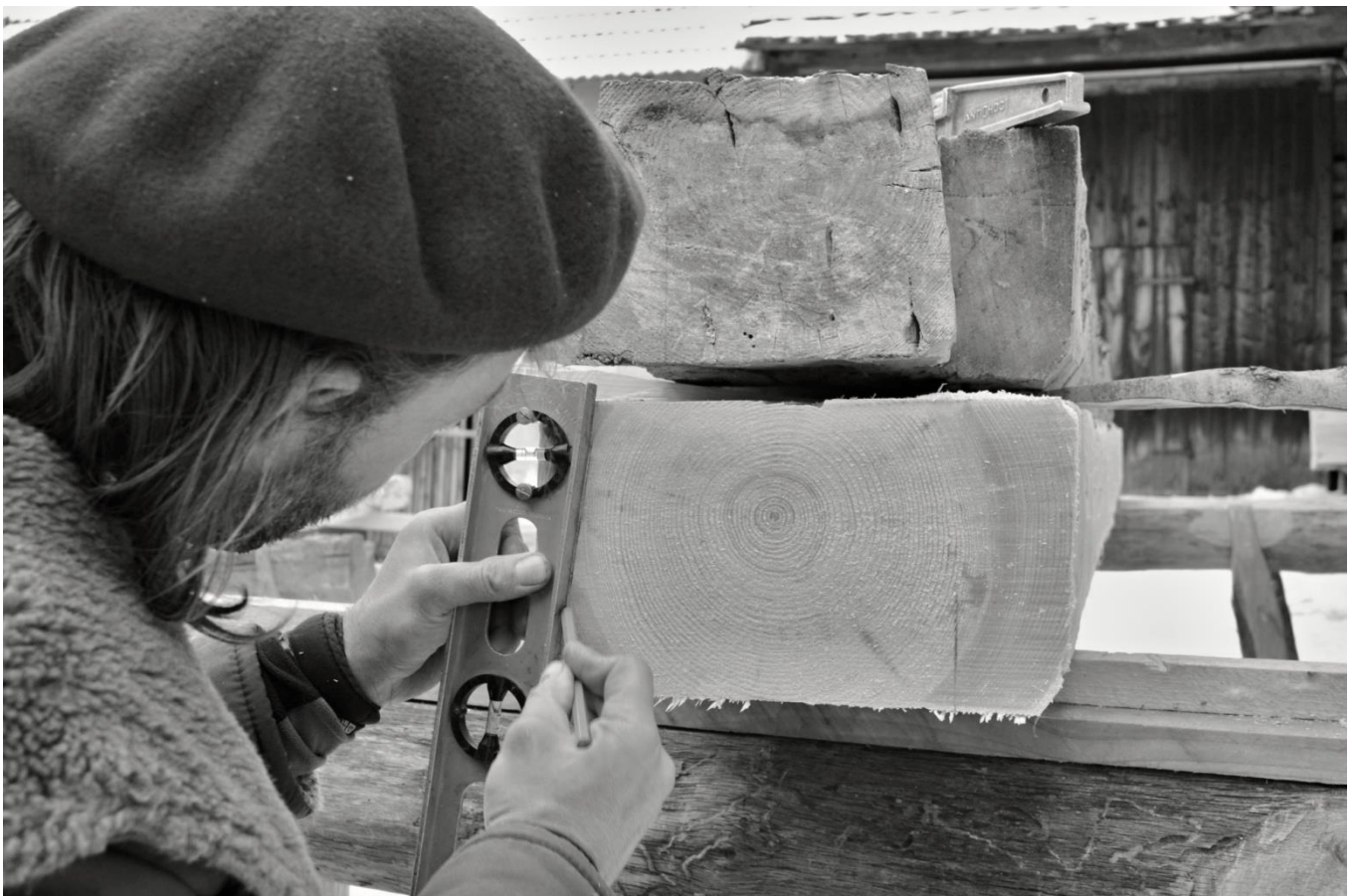
24 Na polotovar poté sklon přeneseme do výchozího bodu u spodní hrany a stejným způsobem dále překopírujeme i zbývající šikminu.
