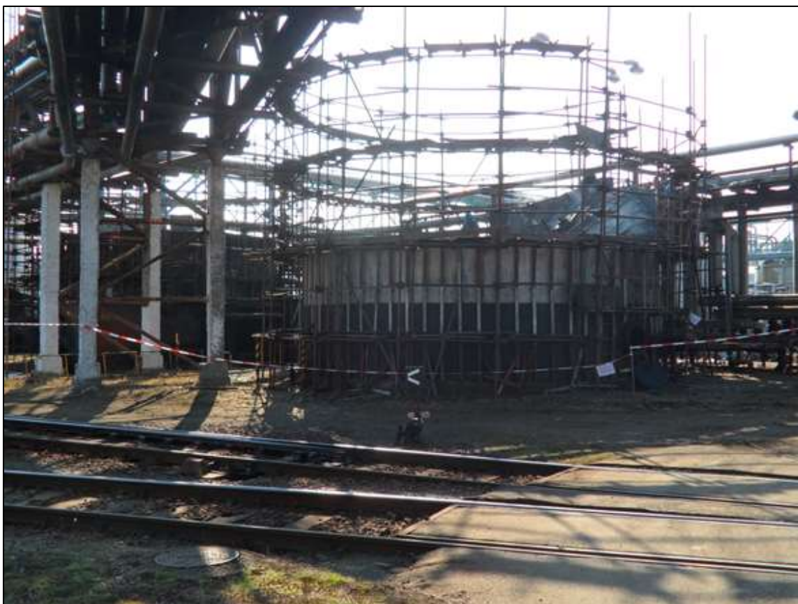
Obr. 2: Odstranění nadzemních zásobníků
