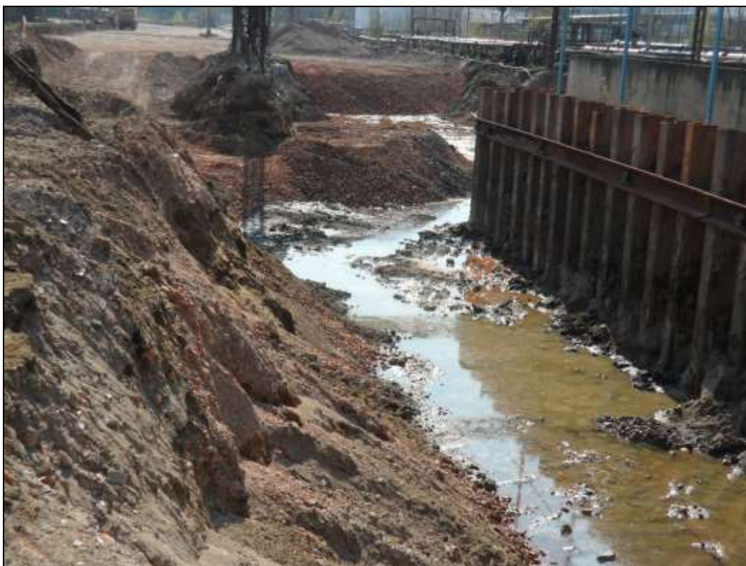
Obr. 4: Provedení výkopových prací
