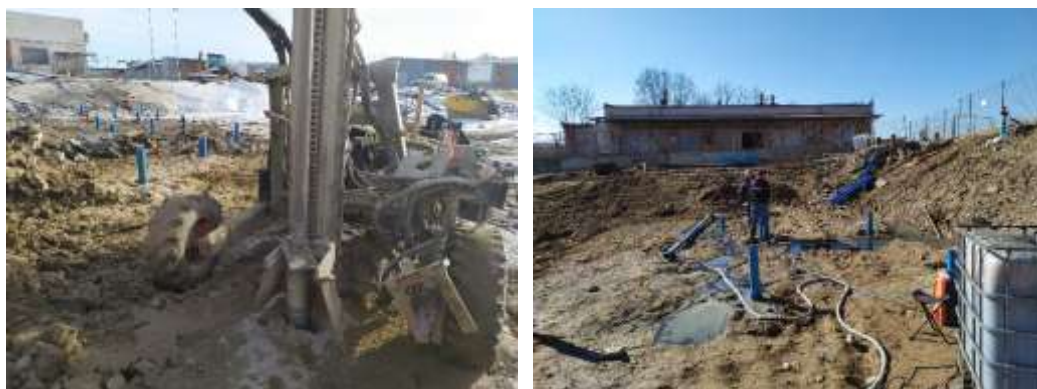
Obr.1.: a) realizace návrtů, b) tlaková aplikace suspenze nanoželeza.
