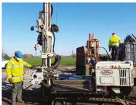
Foto 2: Injektáž nZVI soupravou Geoprobe.
