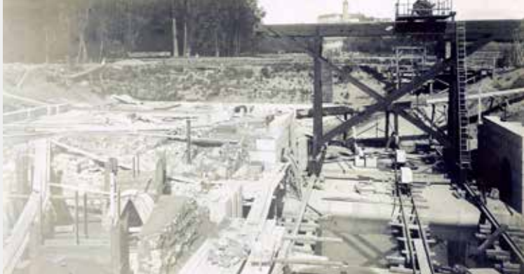
▲ Pohled do rozestavěného dolního ohlaví, stav 1903 (zdroj: archiv Povodí Vltavy, s.p.)
