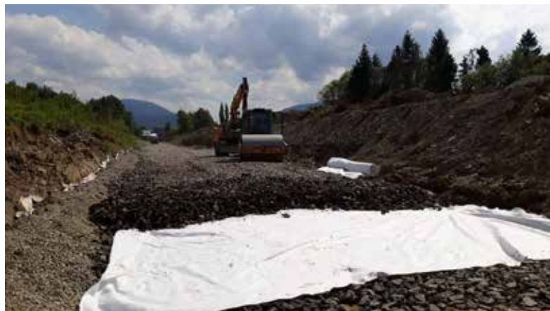
▲ Přivaděč km 1,513–1,881 – místně provedena výměna vrstev podloží včetně stabilizace geotextilií PP
