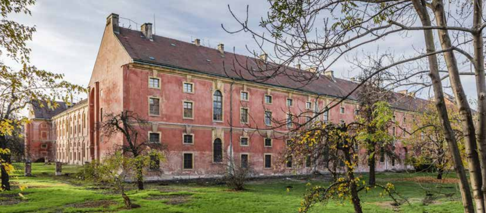
▲ Obr. 15 Východní pohled na budovu, současný stav
