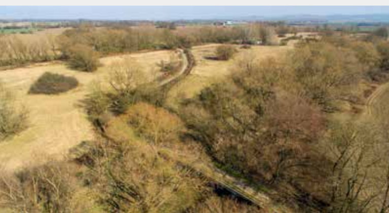
▼ Horní most – stávající stav
