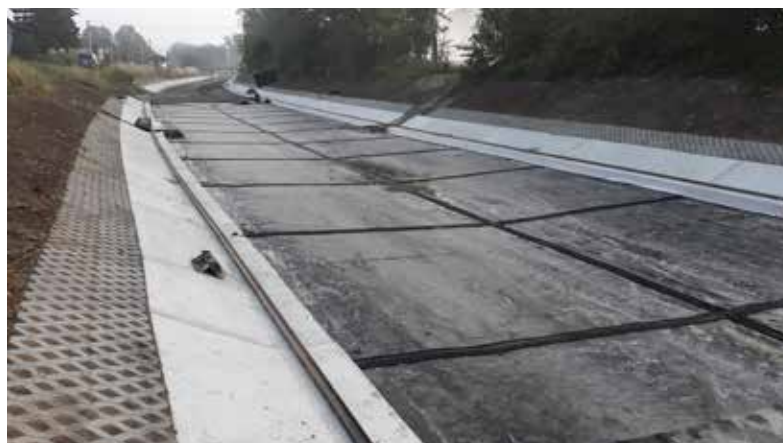
▲ Přivaděč km 0,337–1,513 – pokládka separační geomembrány HDPE 1,00 s členěním těsnících pásů dilatačních bloků
