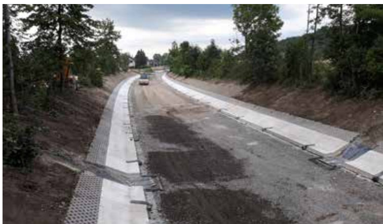
▲ Přivaděč km 0,337–1,513 – příprava hutněných vrstev podloží ze štěrkodrti na betonovém recyklátu
