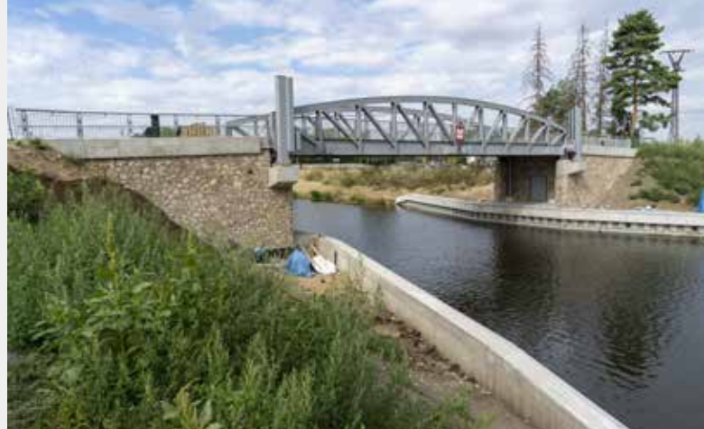
▲ Silniční most 003.A – pohled na kamenný obklad opěr (zdroj: STRABAG Rail a.s.)
