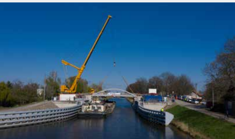
▼ Silniční most 003.C – pohled na montáž NOK (zdroj: STRABAG Rail a.s.)
