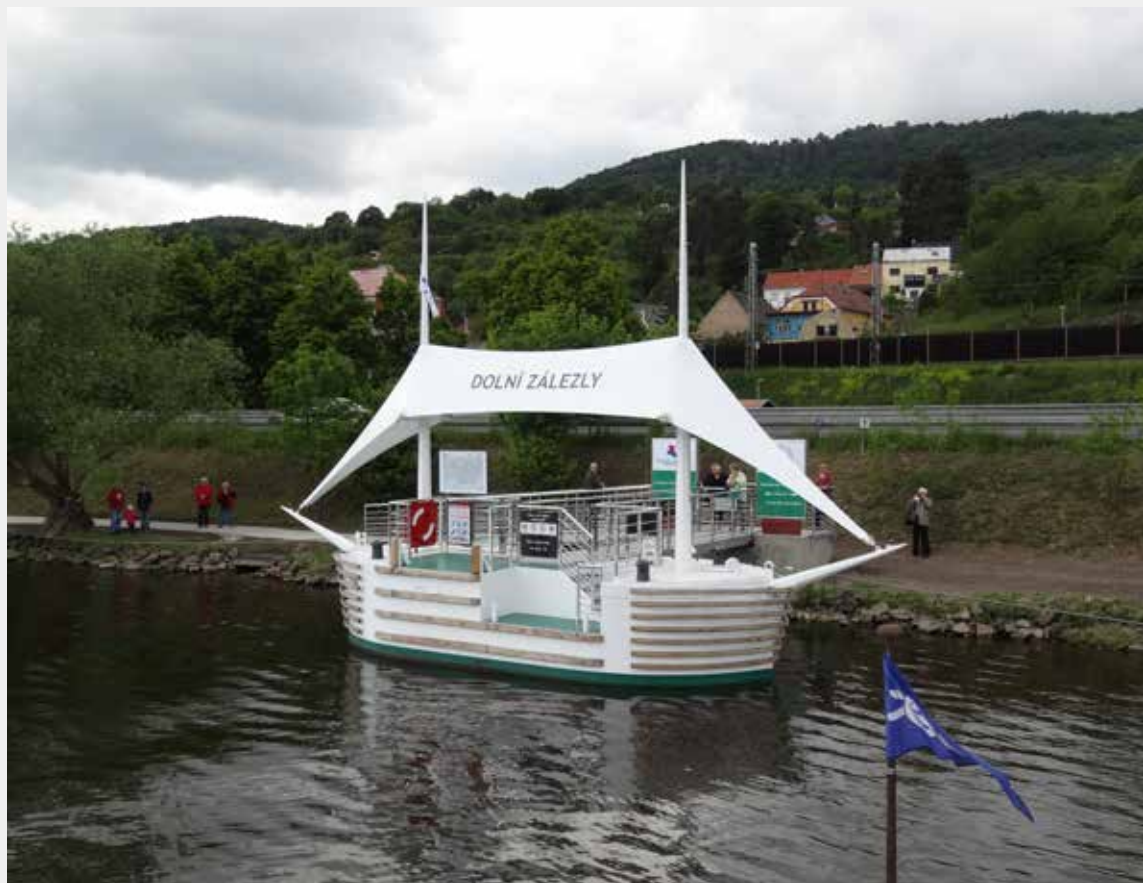
▲ Obr. 2 Dolní Zálezly – realizované přístaviště pro osobní lodní dopravu ve formě plovoucího mola
