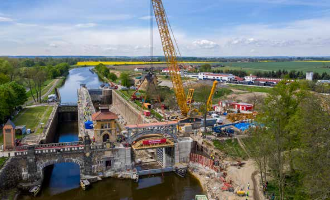
▲ Usazování ocelové konstrukce mostu
