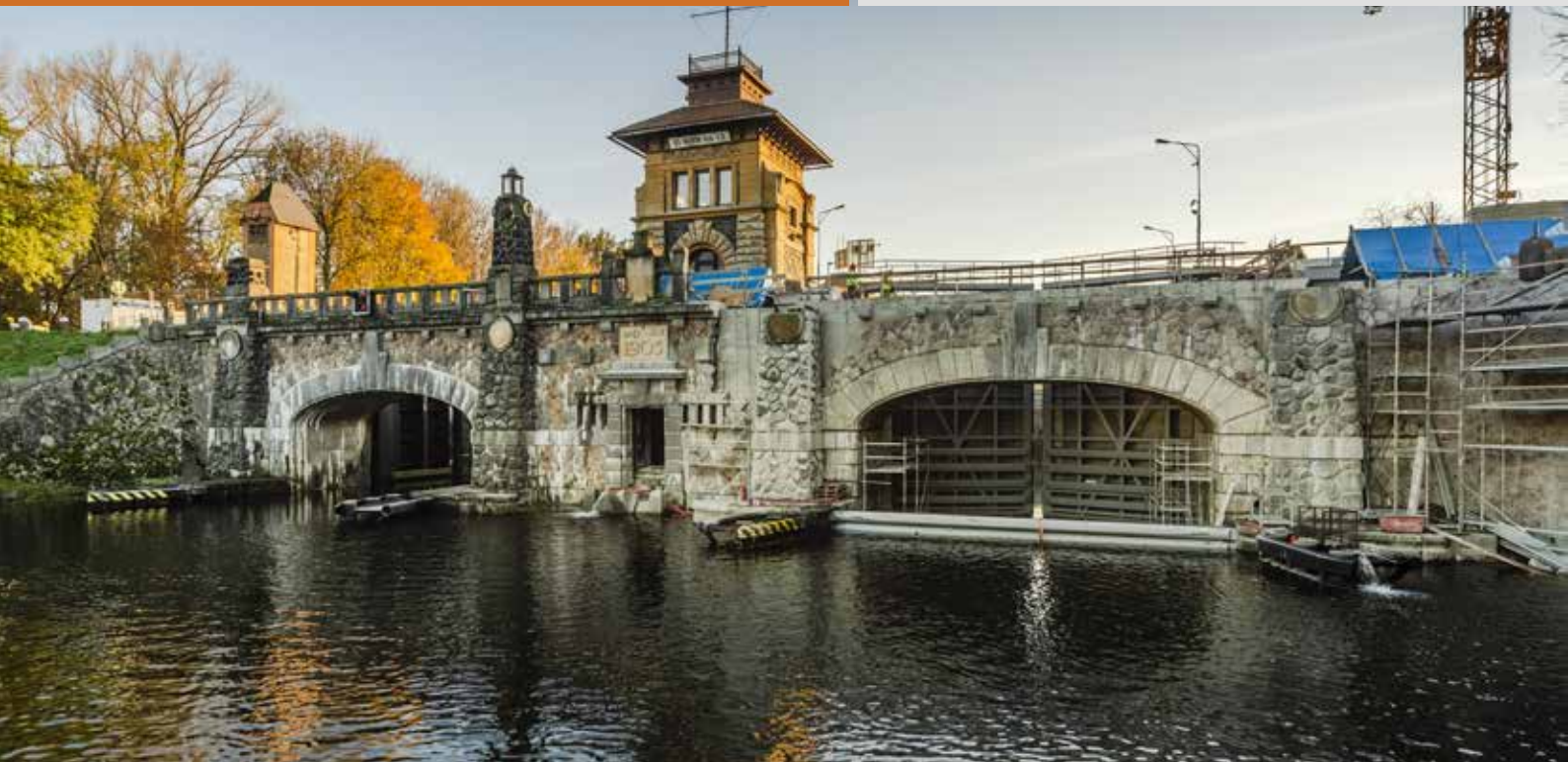
▲ Dolní ohlaví plavební komory Hořín, stav listopad 2020 (foto: Tomáš Malý)
