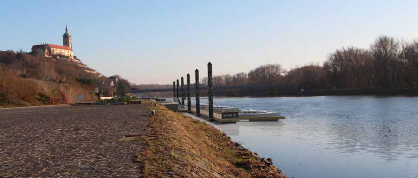
▲ Obr. 8 Mělník – vizualizace plovoucího mola pro malá plavidla ukotveného k ocelovým vertikálním konstrukcím – tzv. vysokovodní dalby
