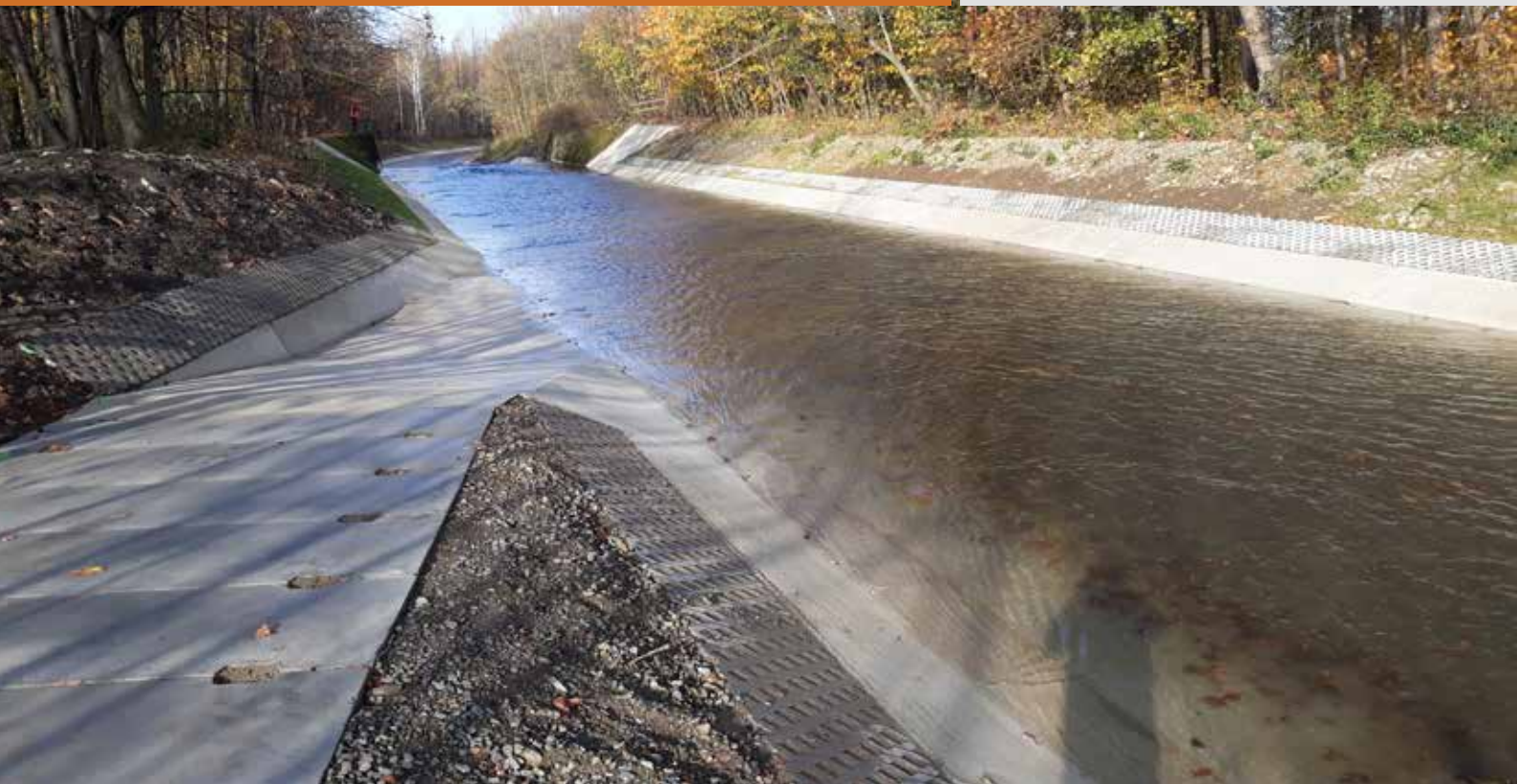
▲ Přivaděč km 0,000–0,337 – dokončené koryto přivaděče u sjezdu č. 2
