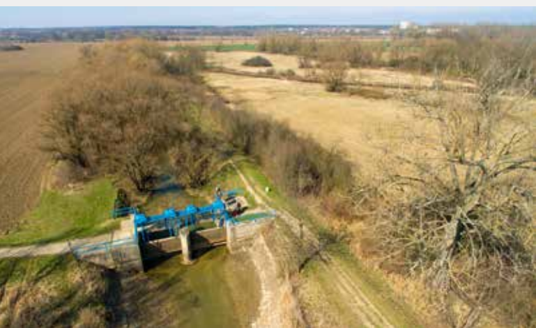
▲ Stávající tabulový jez, prostor budoucí plavební komory
