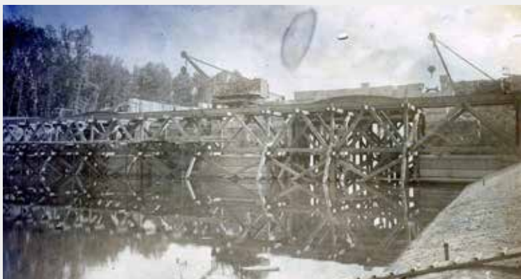
▲ Pohled na skruž mostu, stav 1904 (zdroj: archiv Povodí Vltavy, s.p.)
