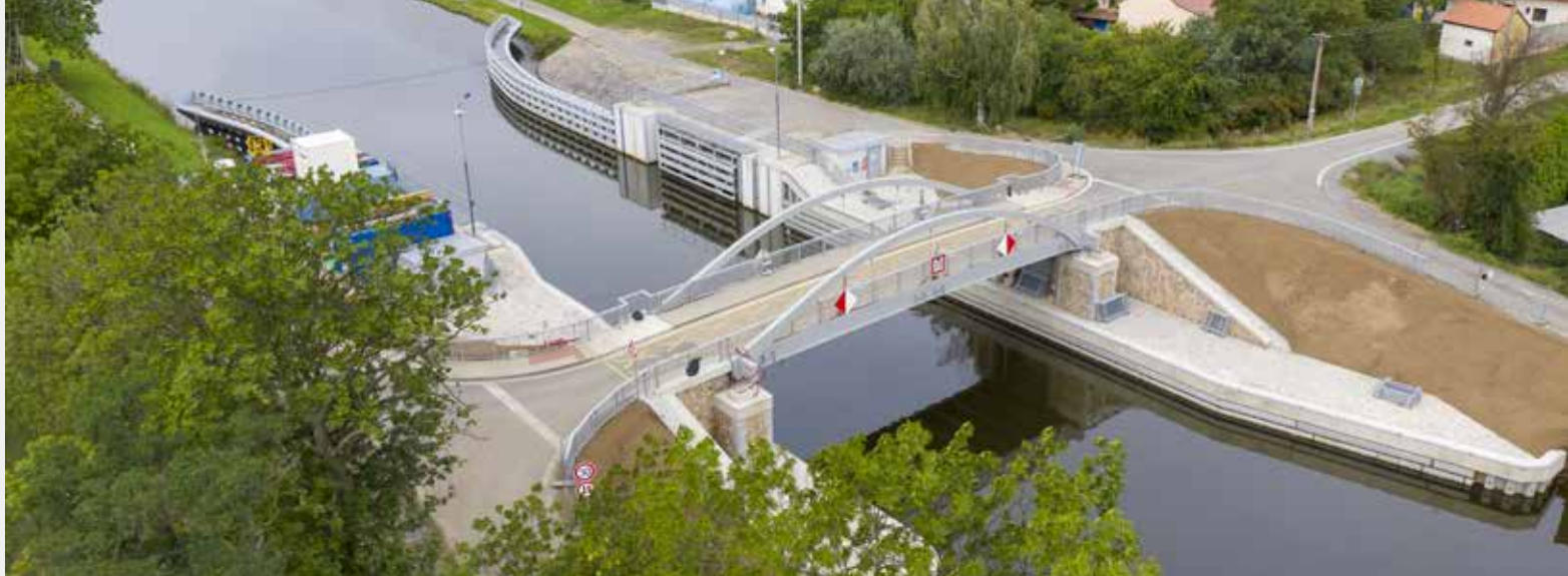
▲ Silniční most 003.C – pohled na téměř dokončené dílo (zdroj: STRABAG Rail a.s.)
