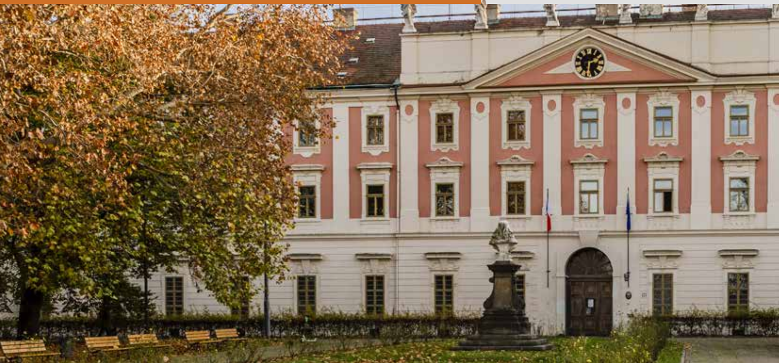
▲ Obr. 1 Invalidovna v Praze, severní křídlo budovy
