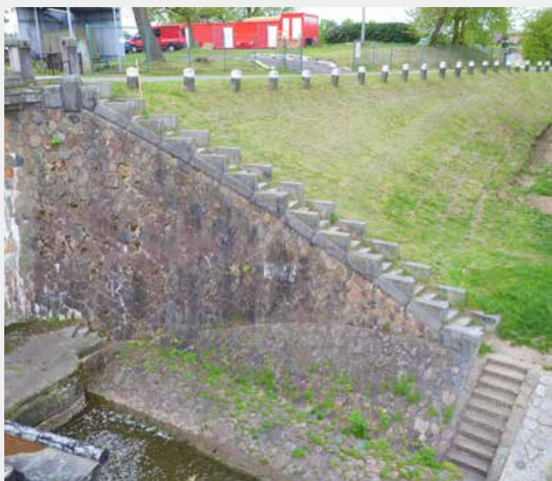
▼ Pohled na původní stav levobřežní opěrné stěny se schodištěm
