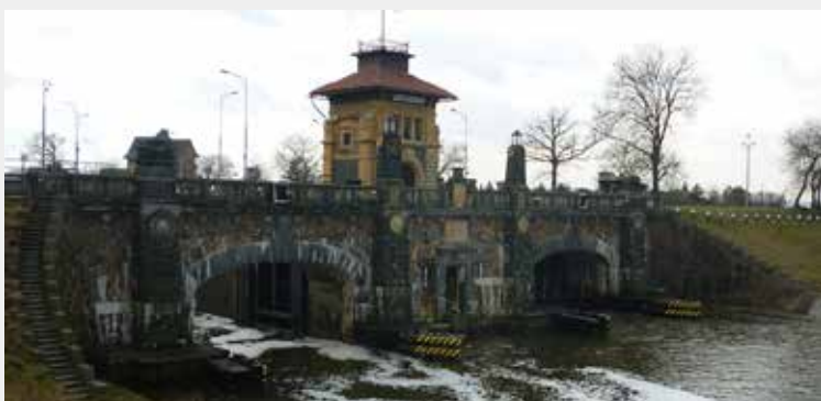
▲ Stav před rekonstrukcí v roce 2019 (zdroj: archiv Povodí Vltavy, s.p.)
