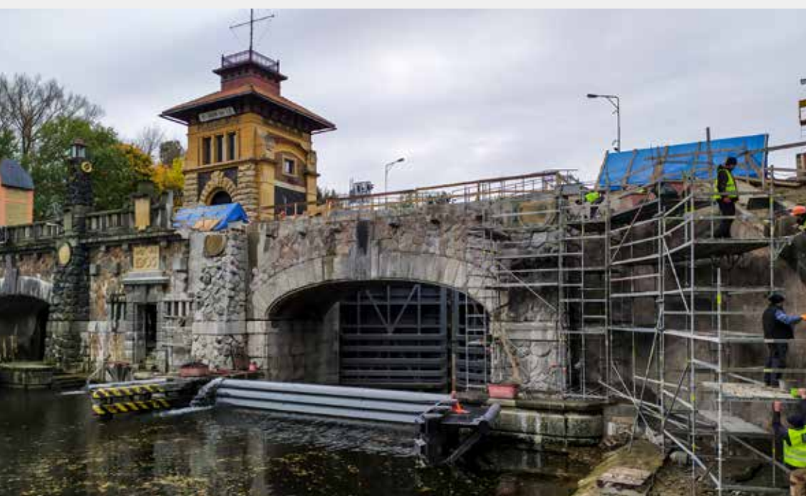
▲ Částečně vystrojený most ve spuštěné poloze
