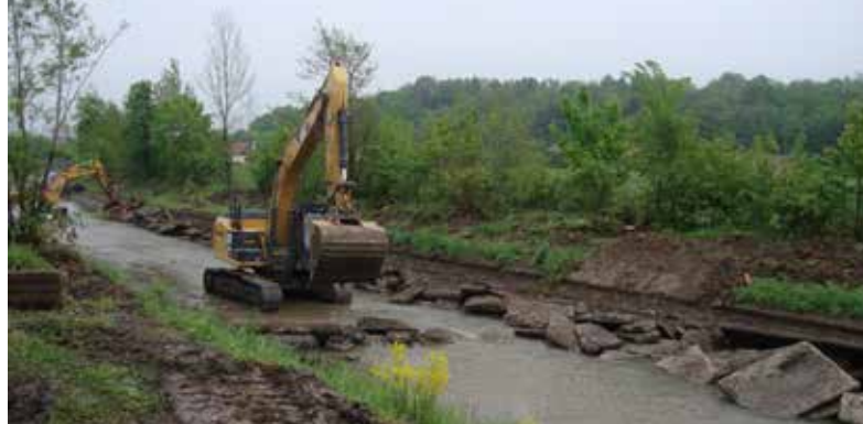
▲ Přivaděč km 0,337–1,513 – bourání stávajícího betonového opevnění dna i svahů koryta
