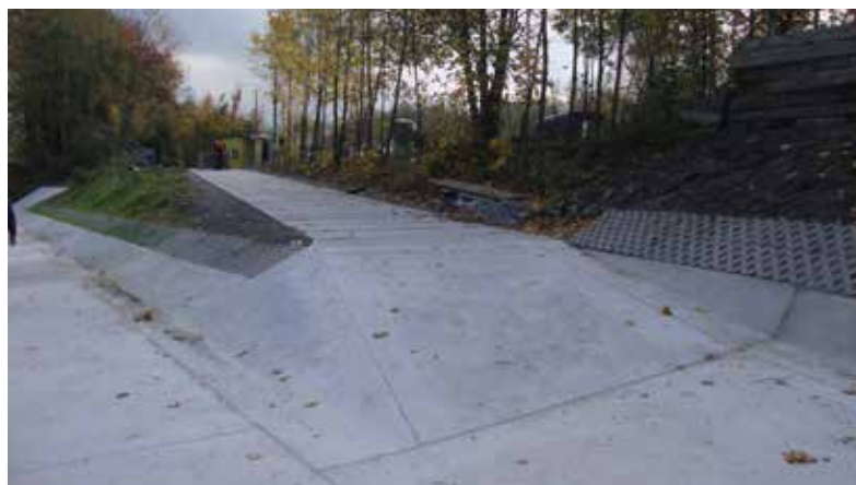
▲ Přivaděč km 0,000–0,337 – dotěsnění tmelem jednotlivých dilatačních a pracovních spár po dokončení betonáže
