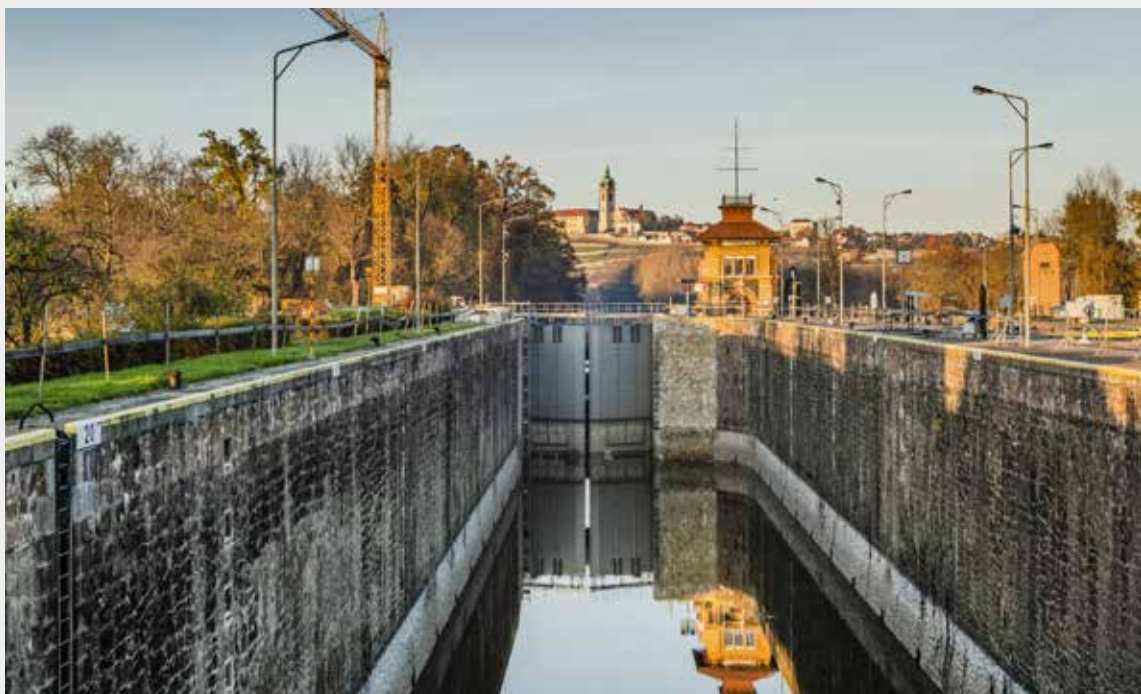
▲ Pohled do komory a na dokončené kamenné obložení nových konstrukcí dolního ohlaví (foto: Tomáš Malý)
