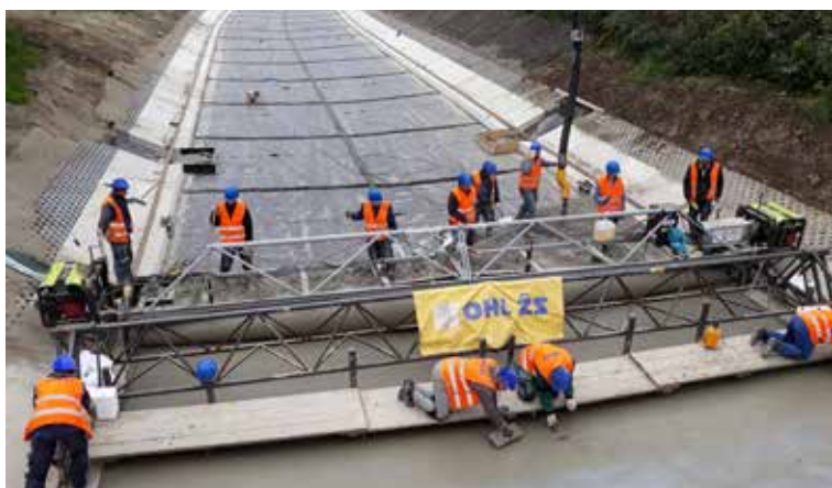
▲ Přivaděč km 0,337–1,513 – betonáž desky dna pomocí kolejové plošiny s rotačním válcem
