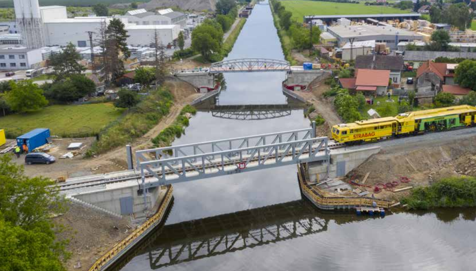
▲ Železniční most 003.B – pohled na realizaci železničního svršku (zdroj: STRABAG Rail a.s.)
