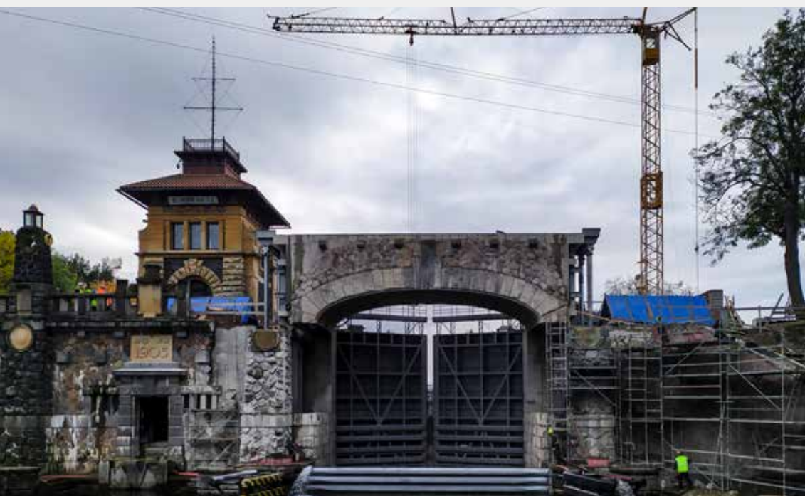
▼ Částečně vystrojený most ve zdvižené poloze
