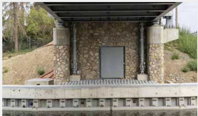
▼ Silniční most 003.A – pohled na kamenný obklad se vstupem do technologické místnosti (zdroj: STRABAG Rail a.s.)
