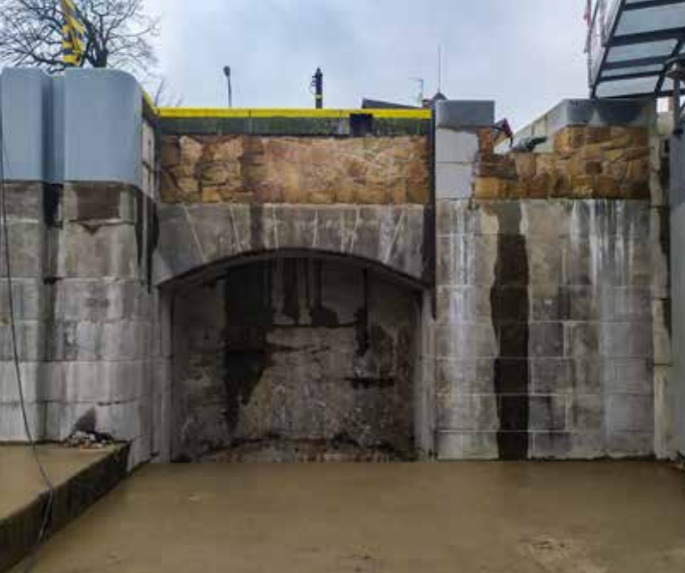
▲ Nová konstrukce levé strany horního ohlaví včetně nátok do obtoků
