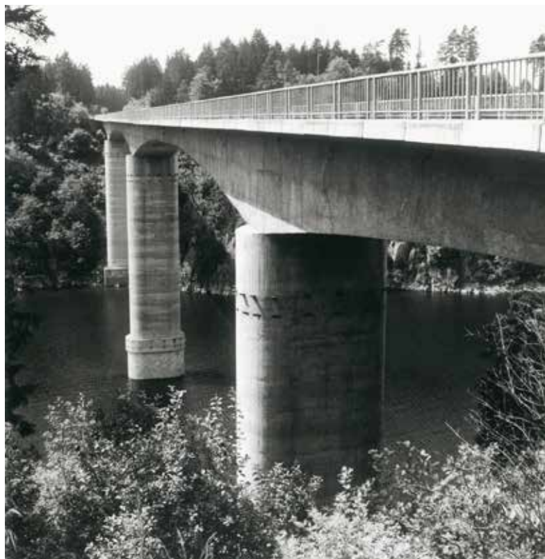
▲ Přemostění u Zvíkova v šedesátých letech – betonování letmo bylo tehdy novou technologií
