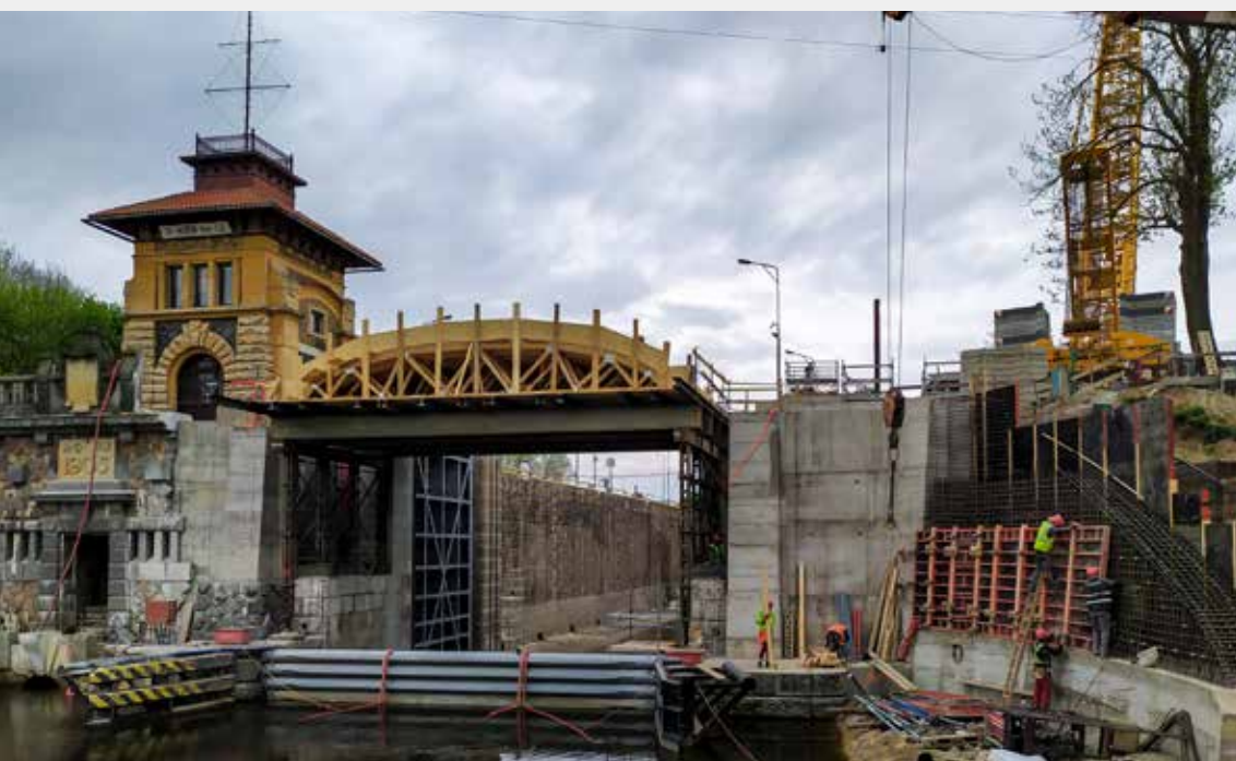
▼ Skruž s bedněním pro betonáž skořepiny a montáž klenbových kamenů
