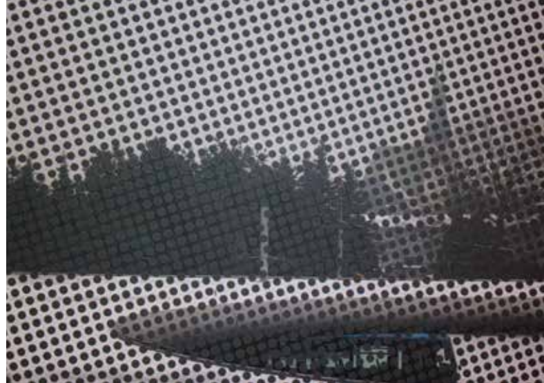
▲ Při použití efektu nahuštěných mikrobodů je možné účinně zabezpečit i rozsáhlé plochy při zachování dostatečné prostupnosti světla a průhledu z budovy; budova hlavního nádraží v Ostravě (foto: Evžen Tošenovský).
