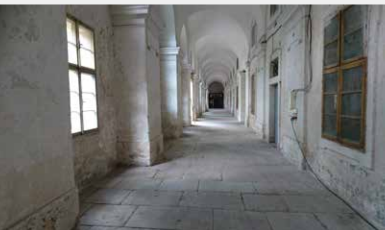
▲ Obr. 9 Podélná chodba ve východním křídle, současný stav
