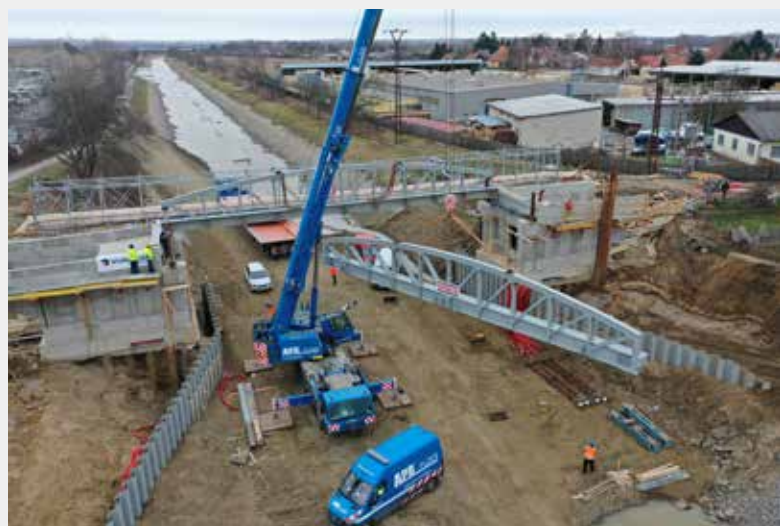
▲ Silniční most 003.A – pohled na montáž hlavních nosníků nové ocelové konstrukce (zdroj: STRABAG Rail a.s.)
