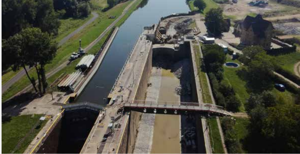
▲ Pohled na horní ohlavi po bouracích pracích
