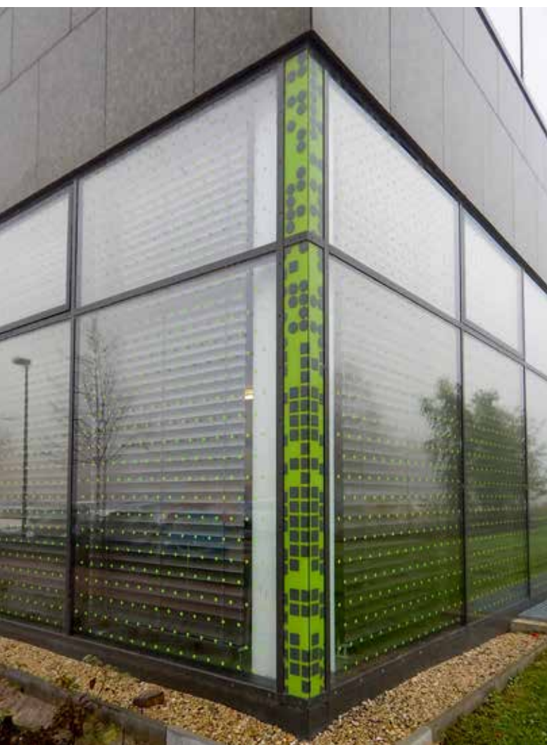
▲ Dodatečné zabezpečení ploch proti nárazům ptáků se většinou provádí dekorativním polepem z vnější strany skel. Polep musí být dostatečně hustý, maximální vzdálenost jednotlivých prvků by měla být 10 cm při zachování minimální velikosti bodu nebo linie 2 cm; budova PíF UP v Olomouci (foto: Evžen Tošenovský).
