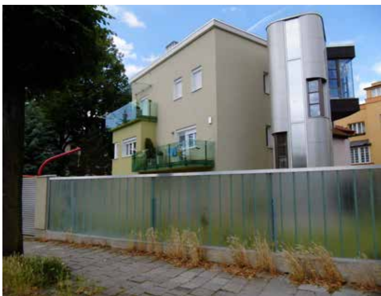
▲ Prosklená zábradlí teras a balkonů jsou vysocí riziková, zejména v rohových partiích. Kombinuje se jak zrcadlový, tak průhledový efekt. Naopak plot kolem stavby je díky využití neprůhledného, nezrcadlícího se materiálu copilít pro ptáky bezpečný; Olomouc (foto: Evžen Tošenovský).
