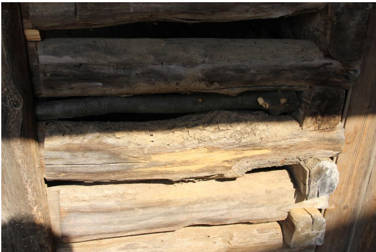
Obr. 42 Komora z Biskupic, vstupní okapová stěna, detail před vytmelením spár mezi roubením kaseinovým tmelem
