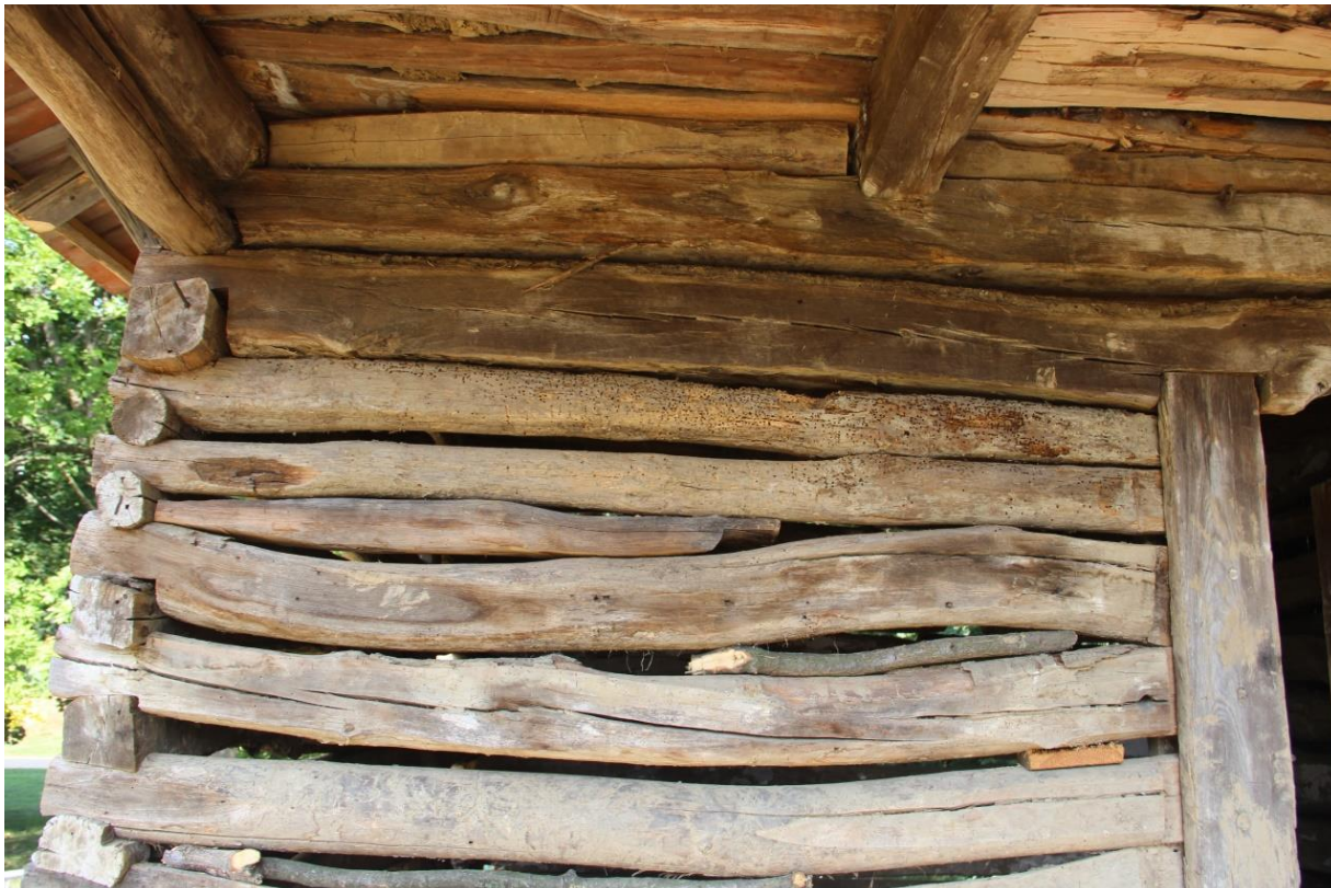
Obr. 38 Komora z Biskupic, vstupní okapová stěna s dvěma horními srubnicemi poškozenými dřevokaznými škůdci
