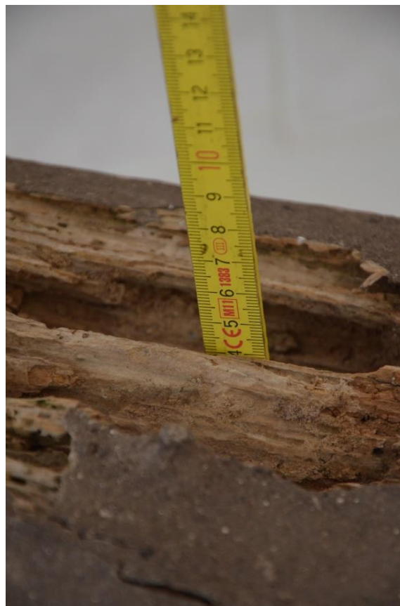
Obr. 13a Vzorek č. 1 degradace poškozeného trámu Obr. 13b Hloubka degradace trámu cca 5cm
