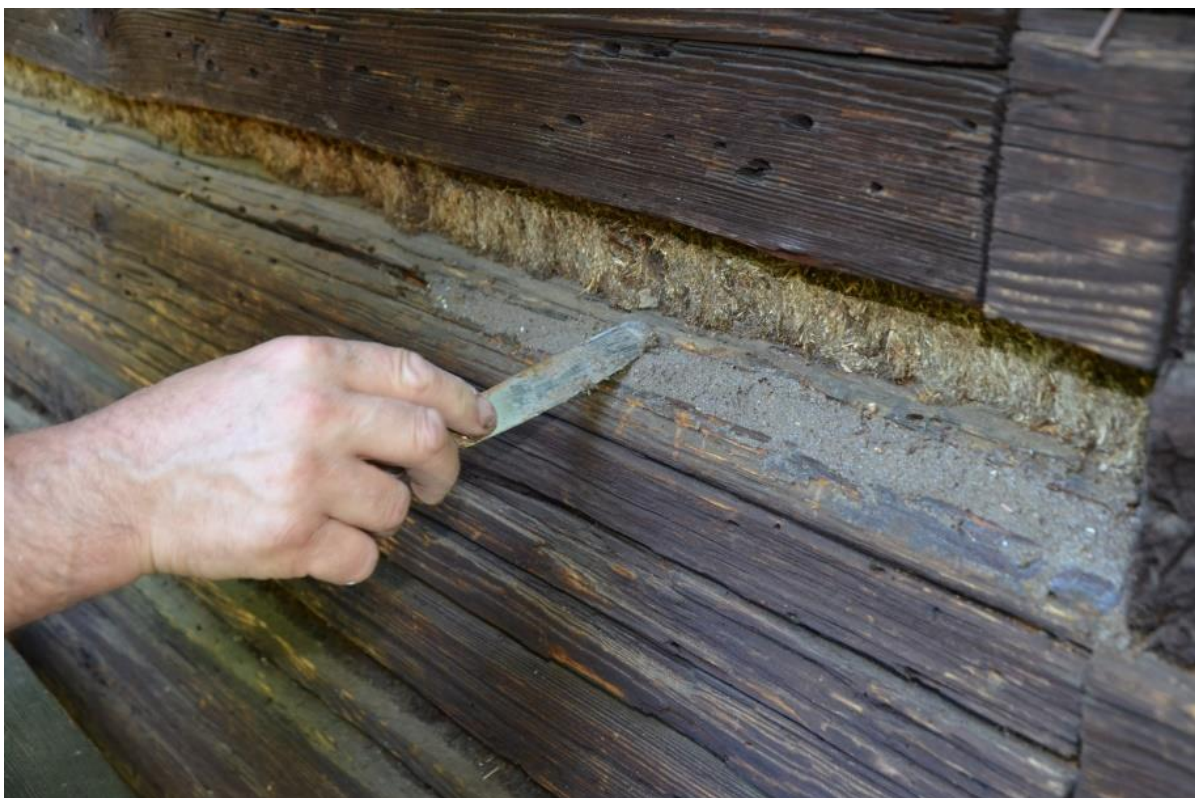
Obr. 24 Chalupa z Velkých Karlovic – Miloňova, detail tmelení poškozené výsušné trhliny kaseinovým tmelem
