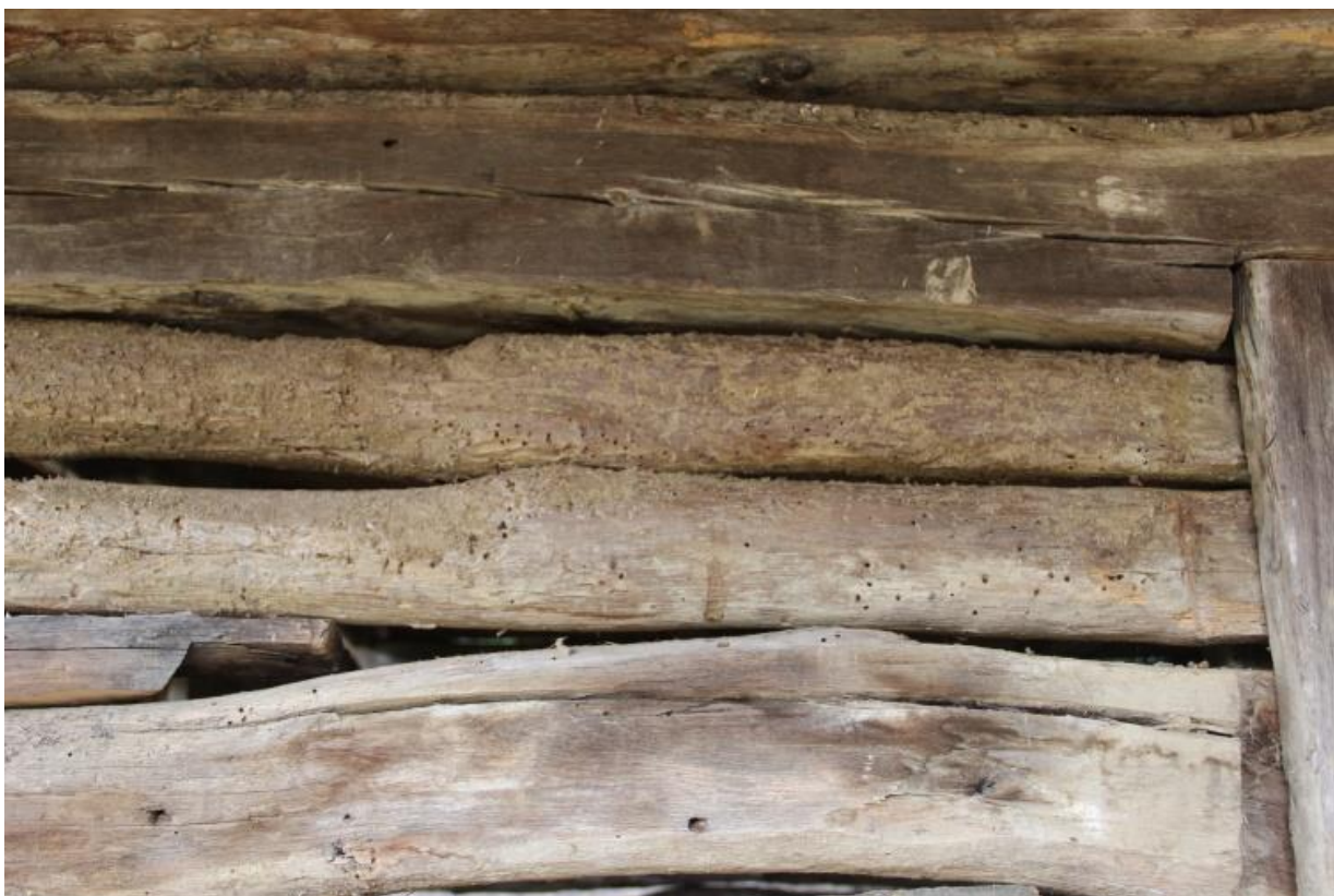
Obr. 39 Komora z Biskupic, vstupní okapová stěna s dvěma horními srubnicemi poškozenými dřevokaznými škůdci, detail konsolidace kaseinovým mazem
