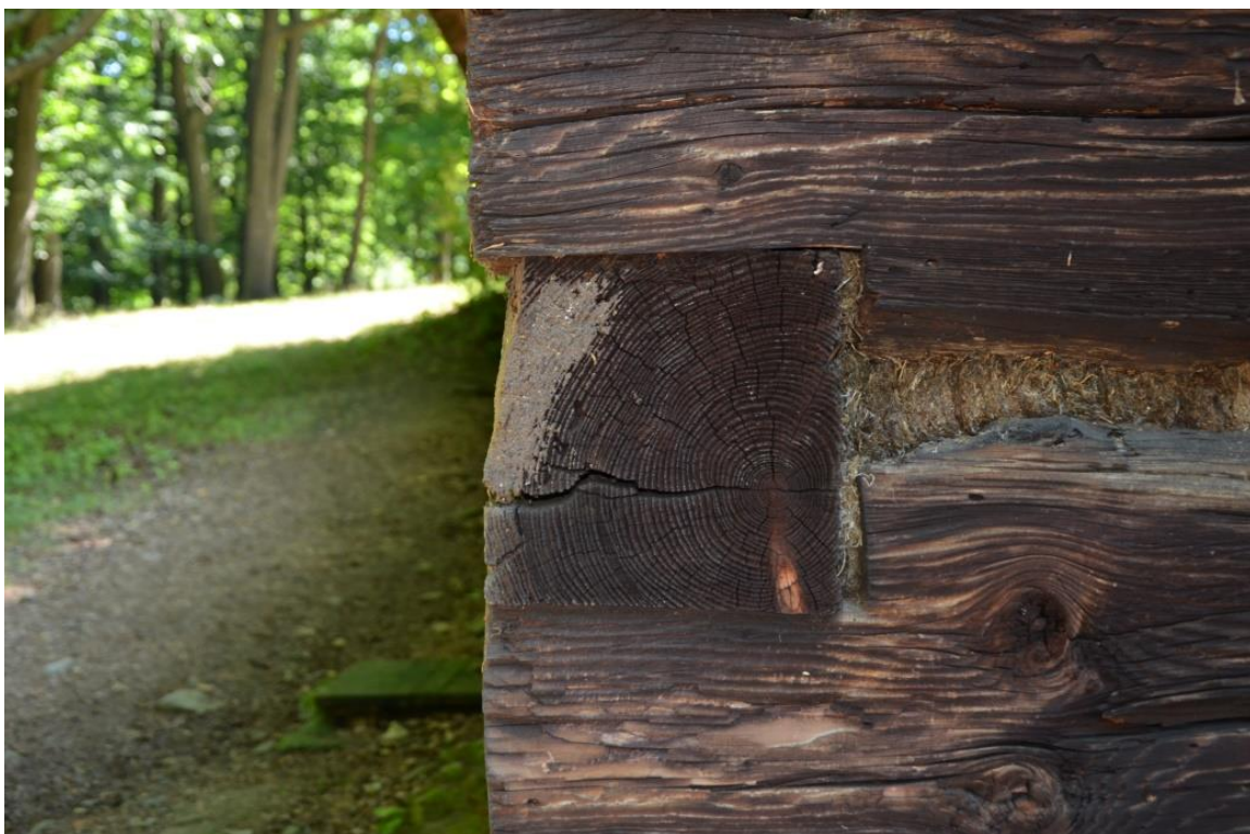
Obr. 28 Chalupa z Velkých Karlovic – Miloňova, detail vytmelení poškozeného místa štítové stěny
