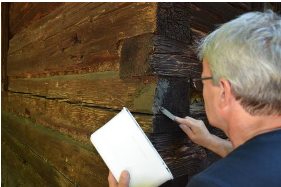
Obr. 27 Chalupa z Velkých Karlovic – Miloňova, průběh tmelení příčného řezu trámu štítové stěny
