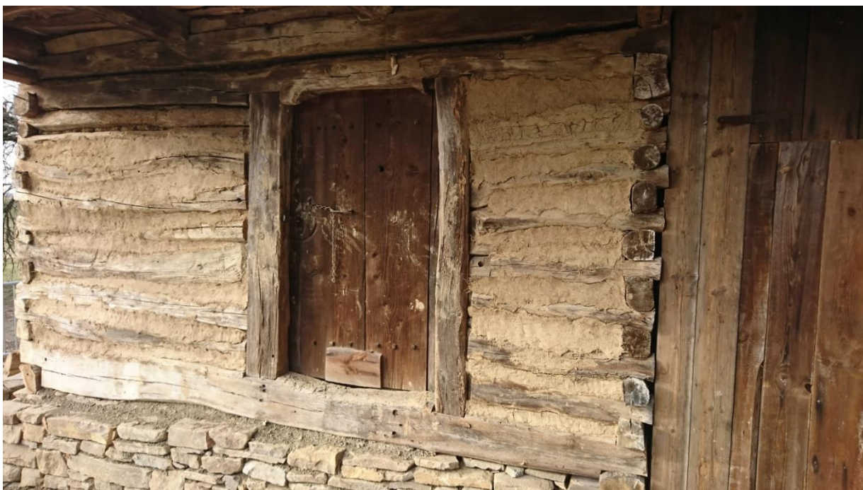
Obr. 26 Komora z Biskupic, vstupní okapová stěna po dokončení hliněné omítky
