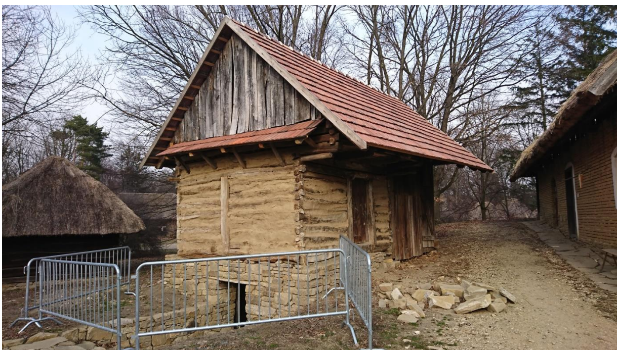
Obr. 27 Komora z Biskupic, celkový pohled na objekt po dokončení hliněné omítky
