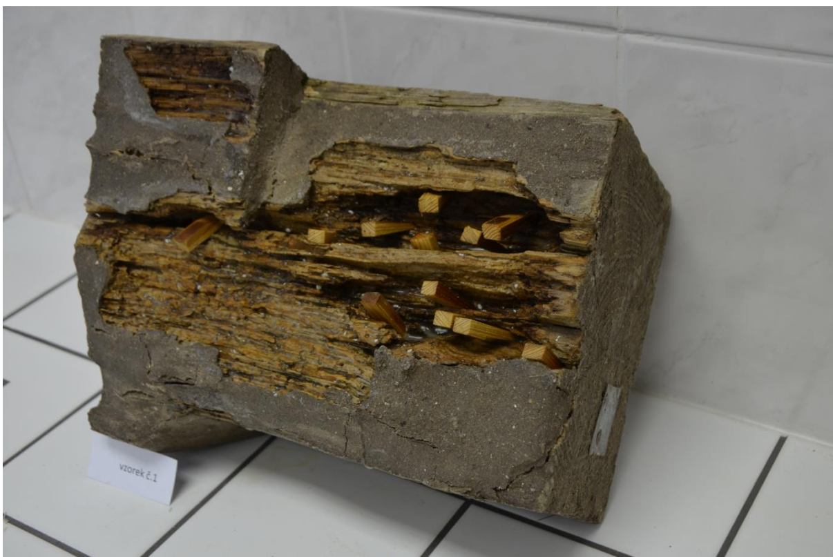
Obr. 14 Vzorek č. 1 po konsolidaci kaseinem – zpevnění hlubokých poškozených míst dřevěnými klínky
