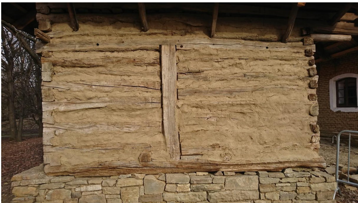
Obr. 37 Komora z Biskupic, štítová stěna po dokončení hliněné omítky
