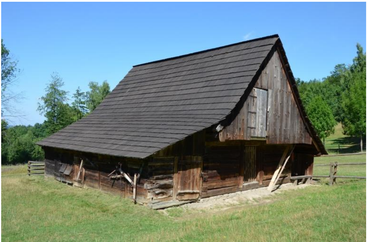
Obr. 29 Hospodářská usedlost z Velkých Karlovic – Podětáteho, chlév
