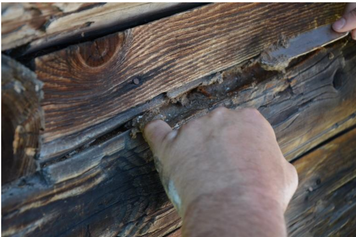
Obr. 32 Hospodářská usedlost z Velkých Karlovic – Podřatého, chlév, detail v průběhu tmelení kaseinovým tmelem
