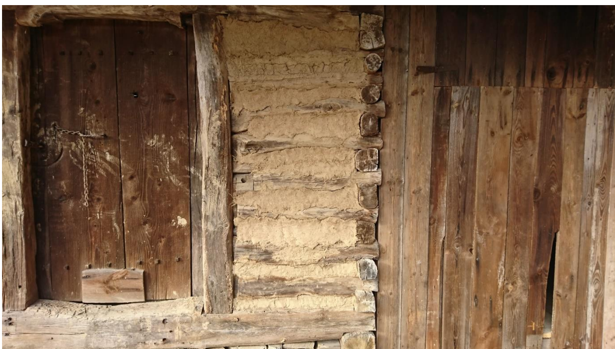
Obr. 44 Komora z Biskupic, vstupní okapová stěna, detail po dokončení omítky
