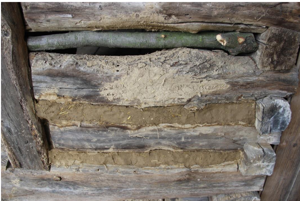
Obr. 43 Komora z Biskupic, vstupní okapová stěna, detail po vytmelení spár mezi roubením kaseinovým tmelem před omítnutím
