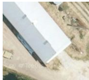
Plechové střešní krytiny
