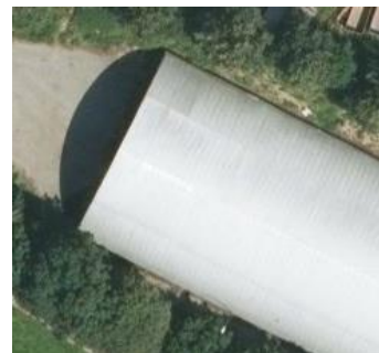
Plechové střešní krytiny
