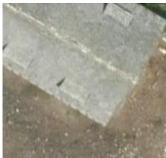
Azbesto-cementové střešní krytiny
