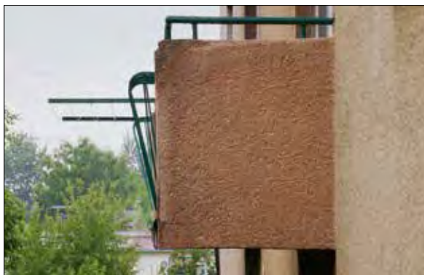
70. Originálně tvarované zábradlí je pohledově poškozeno navařenými tyčemi na sušení prádla. Uherské Hradiště. Družstevní výstavba, kombinace pískového a tmavě červeného břizolitu. 60. léta 20. století. Foto: Hana Řepková, 2021
