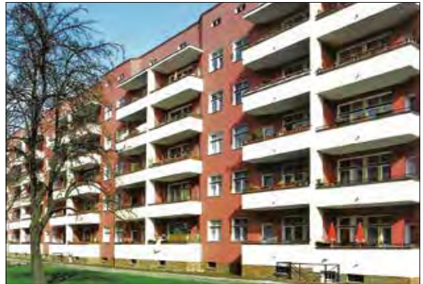
257. Sídlíště Carl-Legien je jedním z šesti německých meziválečných souborů zapsaných na seznamu UNESCO. Před žádostí o zápis byl soubor obnoven do původní podoby. Barevnost průčelí, členění oken a barevnost ráků a křídel odpovídají podobě z 30. let. Barevné zadní stěny lodžii zdůrazňují tektoniku budovy, připomínají, že lodžie jsou k domu přisazené. Avantgardní členění okenních křídel bylo v černobílém provedení zdražile varioováno v 60. letech 20. století. Dnes je považováno za atypické a drahé. Berlín-Pankow, Wohnstadt Carl-Legien. Bruno Taut, F. Hillinger, 1932, obnova Winfried Brenne Architekten, 1993. Přeuzato z: Hunger/Weidemüller/Protz 2017.
