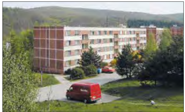
189. Červené síťové panely, meziokenní vložky a betonové zábradlí lodžii měly od počátku čtyřpodlažní domy sídliště Bystrc, dnes známého osobitými nástaobami ateliéru Maura. Brno-Bystrc. Černého 52–56. 70. léta 20. století. Foto: Markéta Veselá, 2005.
