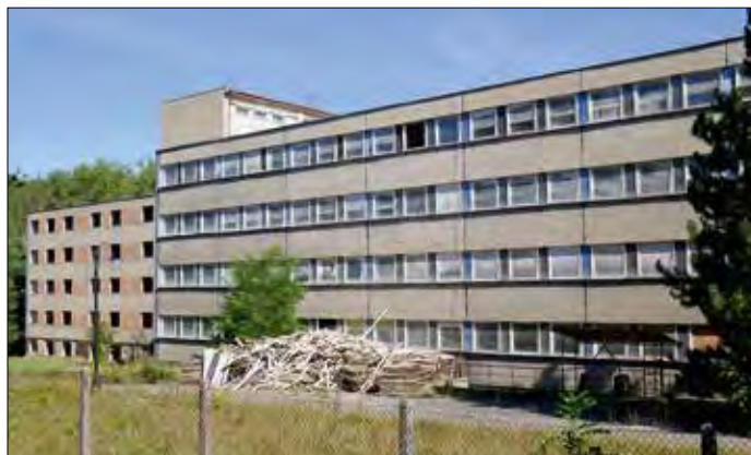
118. Typická pásová okna s meziokenními panely zapuštěnými na úroveň oken a častý přístup, který je znehodnocuje. Vpravo původní stav, vlevo zrušení pásových oken. Neomítnuté cihelné vyzdívky ještě zčásti zachovávají efekt pásových oken, po zateplení a sjednocení s fasádou jej ztratí úplně.
