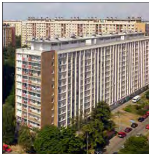
224. Typický „čtverec“ sídliště Dáblice s víceméně původní barevností. Praha 8 – Kobylisy, sídliště Dáblice, Střekovská, Tanvaldská, Chabařovická. Vilém Hess, J. Schneider, 1969. Foto: Hana Řepková, 2017.
