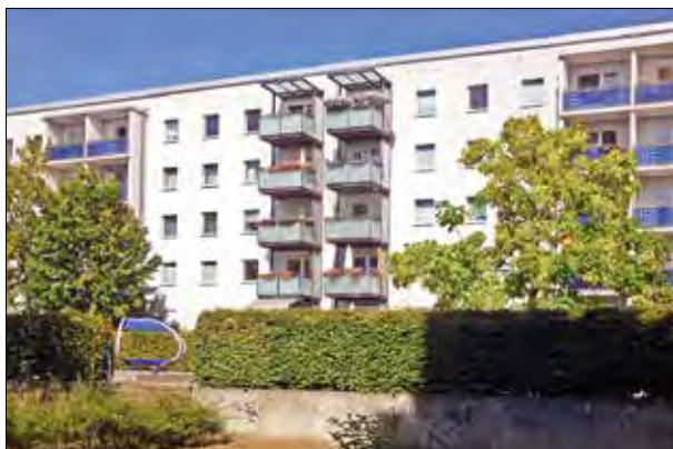
311. Přistavěné lehké ale rozměrné balkony čtvercového půdorysu, zábradlí lodžii z modrých luxferů s dřevěným madlem. Německo, Berlín, sídliště Hellersdorf, Grabenviertel. Foto: Hana Řepková 2018.
