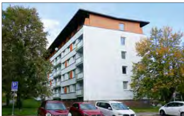
114. Kultivoovanou ukázkou, jaké střechy panelákům sluší, je Haailickův Brod. Kromě plochých střech a ustupujících podlaží výborně pasují střechy opačného sklonu, užívané u nás v 60. letech – snímek štítu (a) a hlaoního průčelí (b). Haailickův Brod. 80. léta 20. století. Foto: Hana Řepková, 2021.
