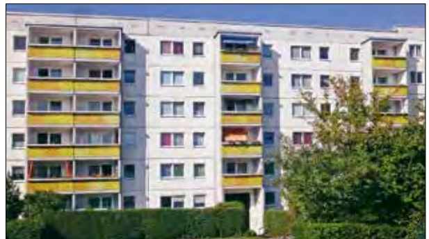
332. Na nezatepleném panelovém domě se za vysokou atikou s větracími otvory skrývá dvouplášťová střecha. Německo, Berlín, sídliště Hellersdorf, část Gelbeviertel. Foto: Hana Řepková 2018.
