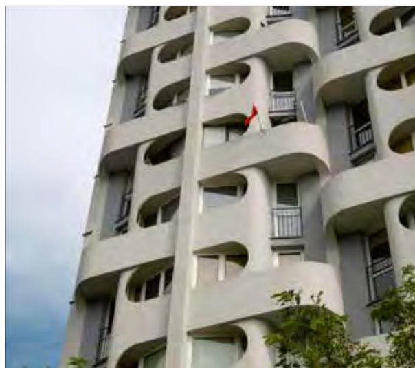
268. Šest domů s obchodním parterem, parkovacím polosuterémem a pavilony služeb a restaurací v organických formách tvoří soubor Plac Grunwaldski, zvaný též wrocławski Manhattan. Detail zateplené fasády – šedý nátěr fasády nahradil se souhlasem autorky původní keramický obklad. Polsko, Vratislav-Plac Grunwaldski, Jadwiga Grabowska-Hawrylak, 1968–1978. Foto: Hana Řepková 2019.
