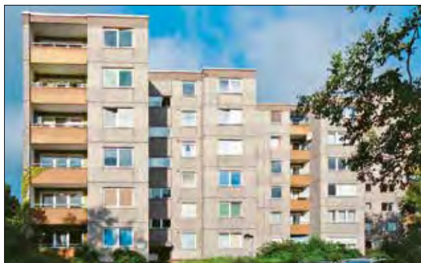
112. V Německu mají nástaovy panelových domů modernistických sídlišť nejčastěji ploché střechy. Neviditelná nástaoba půdorysně čle- nitého panelového bloku ze 70. let. Principem je opět návrat ke kořenům, k bílému funkcionalismu. Šestipodlažní blok získal další, téměř identické patro s výrazně vyloženou střechou. Nová okna mají tmaově šedou barvu, lodžie se opticky prohloubí, okna nesplyvají s fasádou, ale zdobí ji. Snímek (a) zobrazuje stav před regenerací, (b) s nástaobou a do boku otevřenou lodžii v posledním patře. Německo, Berlín, Wohnpark Mariendorf. Převzato z: Hunger/Weidemüller/Protz 2018.
