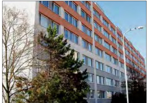
153. Bytové družstvo žádalo Oddělení architekta Odboru úřada MČ Praha 8 o souhlas se zateplením štítů, ale odmítlo předložit návrh řešení fasád celého bloku. Zateplení proto bylo povoleno s podmínkou, že zateplení štítů bude opatřeno omítkou v bílé barvě. O několik let později k ní byly navrženy podélné fasády. Praha 8 – Bohnice, sídliště Bohnice, čp. 563–567, Řešovská 20–28. Mílan Jarolím, 70. a 80. léta 20. století. Návrh nové barevnosti Hana Řepková, 2000. Foto: Hana Řepková, 2012.
