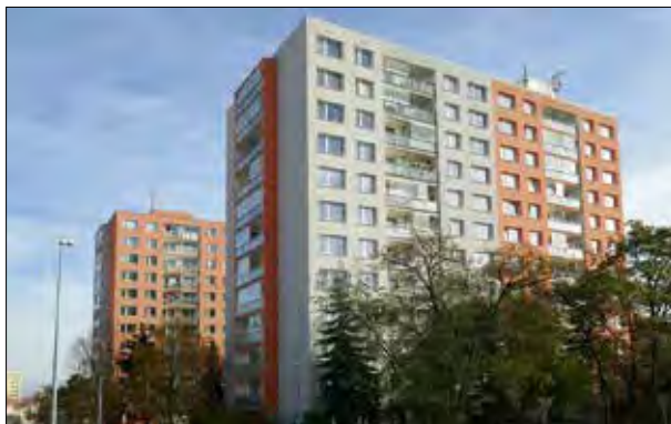
231. Ukázka realizace dle Generelu barevnosti vybraných obytných souborů na území městské části Praha 6: Optické zmenšení dvojice výškových deskových domů hmotově a měřítkově rušivých. Snížení výšky většinou nefunguje, zeshitlení ano. Obě velké deskové hmoty byly opticky rozděleny na čtyři vysoké štíhlé, dvojbarevnost jediného bloku je uvážena zopakováním téhož řešení v pozitivu a negativu. Kontrastní průčelí obou částí dvojdomů může působit, jako by byla půdorysně mírně posunuta. Praha 6 – Břevnov, bloky čp. 136–138, Radimova 27 a 29. Foto: Hana Řepková, 2020.
