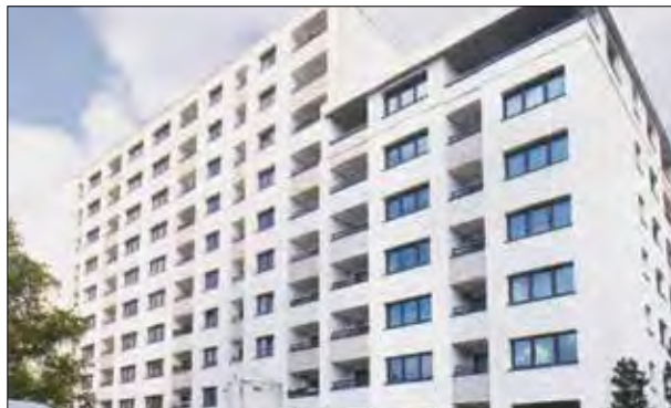
113. Nástaoba deskového bloku ze 70. let je provedena pouze nad nižší částí. Pásová okna jsou zůrazněna tmaovými rámy, nástaoba má velkou krytou terasu. Snímek (a) zachycuje původní podoba bloku, (b) blok s nástaobou. Německo, Berlín, Wohnpark Mariendorf. Převzato z: Hunger/Weidemüller/Protz 2018.
