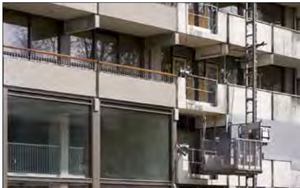
322. Detail regenerace, vpravo původní stav, vlevo po obnově. Nizozemí, Amsterdam-Zuidoost, sídliště Bijlmermeer. NL Architects a XVW architectuur, 2017. Přeuzato z: Wilkinson 2017
