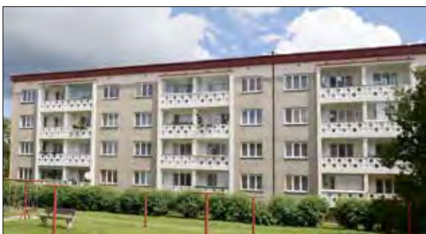
92. Sklobetonové tvárnice známější jako luxfery, zde v elegantní kruhové formě osazené v zábradlí lodžii bytového domu vybudovaného družstvem. Týnec nad Sázavou, Družstevní 409–412. Foto: Hana Řepková, 2021.
