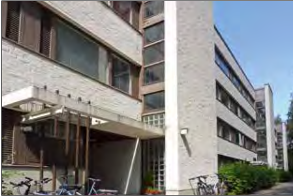
325. V severských zemích se téměř nezatepluje, izolační vrstva mezi panely, používaná i u nás, je tamními odborníky vyhodnocena jako dostatečná. Dodnes se jako finální vrstva používají režné panely s vtačeným vzorem. Na snímku fasáda z režného cihelného zdiva opatřená bílým nátěrem. Finsko, Helsinky, soubor Tapiola, 60.–70. léta 20. století. Foto: Hana Řepková, 2020.
