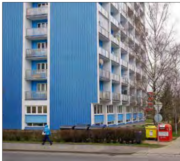
192. Tři chodbové věžové domy z konce 60. let byly v 90. letech zatepleny obkladem Feal. Na rozdíl od stěrky, jejíž poorchová úprava se špiní a bledne (oymýová), je barevnost lamel Fealu je i po desetiletích velmi uspokojivá. Rakovník, sídlišťe V Lukách, Dukelských hrdinů čp. 1773, 1782, 1804. Foto: Hana Řepková, 2019.
