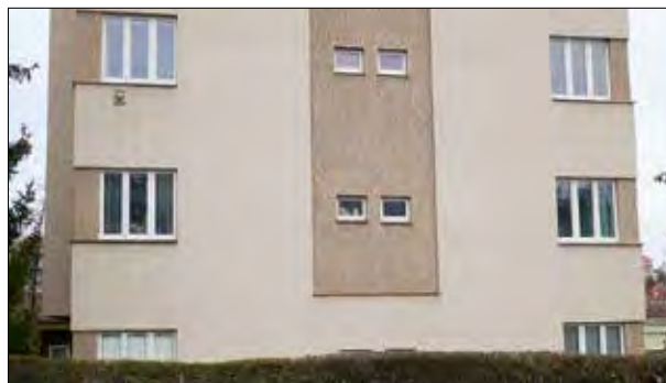
91. Omítky v přírodních odstínech měly různou strukturu, hrubou na větších plochách, hladkou na římsách, okenních šambránách, vstupních portálech, ale i sloupcích zábradlí. Odolena Voda, sorela. 50. léta 20. století. U modernistických staveb byly rozdíly struktur využívány pro architektonicky kontrastní působení ploch (a). Praha-Břevnov. 30. léta 20. století. Nátěr fasády umocňuje kontrastní působení odlišných struktur. Jedná se o nepřesné čtení původního vzhledu, kdy hrubá struktura působila jako tmaoší (b). Foto: Hana Řepková, 2021 a 2020.
