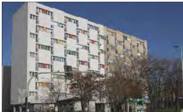
273. Příklady architektury polských sídlišť i aktuální řešení zateplení fasád. Paolačov ý dům při Grabiszynské ulici. Fasáda není obnovena se všemi detaily (vystupující a vpadlé plochy rytmizující průčelí), ale barevné oživení meziokenních sloupků nezakrylo její charakter. Polsko, Vratislav-Grabyszyn, 60. léta 20. století, doplňky Stefan Müller, 1967. Foto: Hana Řepková, 2019.
