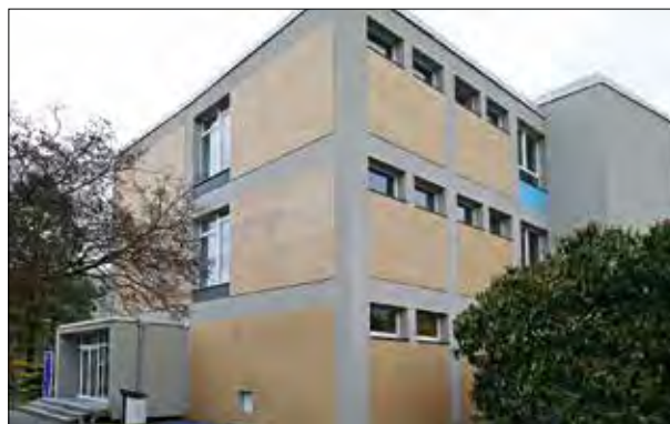
200. Budovy kampusu pražské Zemědělské univerzity jsou zateplené, na zateplení je zopakován keramický obklad i skleněná mozaika: jedna z fakult (a), rektorát (b), laboratoře (c). Praha-Suchbát, Kamýcká 129, Česká zemědělská univerzita. Foto: Hana Řepková, 2020.
