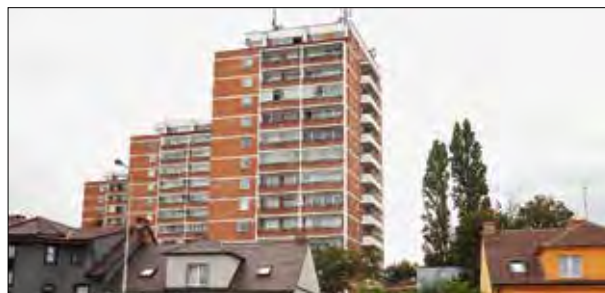
255. Na snímku trojice dvanáctipatrových věžových domů v Praze-Záběhlích z 2. poloviny 70. let s jednodušším, ale přesto efektním řešením fasád. Režné cihlové fasády s patry oddělenými bílými věnci má i trojice devítipatrových věžových domů pro zaměstnance ČVUT v Praze 6 – Dejvicích kolem náměstí Na Santince, která vznikla podle projektu Jaroslava Paroubka z roku 1967. Praha-Záběhlice, čp. 1155–1157, V Dolině 2–6. Foto: Hana Řepková, 2022.
