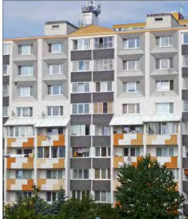
294. Iluzivní malby na fasádách domů s postmoderními prvky. Rozšíření spodní poloviny domu je inspirováno francouzskými příklady.
