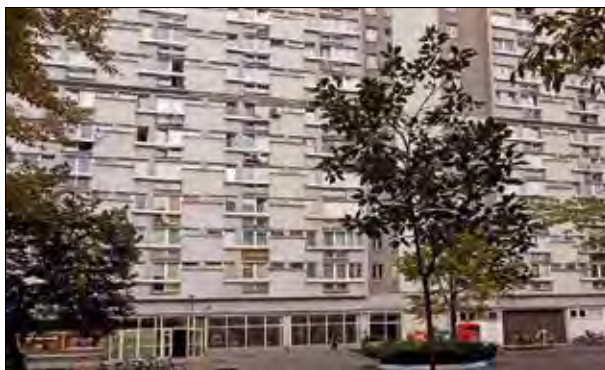
272. Vysoce ceněný soubor Za Żelazną Bramą . Šestnáctipatrové domy s malými byty mají v parteru obchody a služby, každý dům je prostupný širokým průchodem, z něž je přístupná velkorysá oboustranně prosvětlená vstupní hala. Pásová okna se podle účelu místnosti rytmicky zmenšují a zvětšují. Domy mají původní torzé omítky v pískové barvě. Polsko, Varšava, sídliště Za Żelazną Bramą . 60. léta 20. století. Foto: Hana Řepková 2018.
