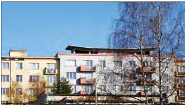
331. Zaatikový žlab na objektu v bruselském stylu je patrný na levé straně snímku. Uprostřed ustupující poslední podlaží se střešní terasou. Ostrava-Poruba, Pohotovostní hornické sídliště. 50. léta 20. století. Foto: Hana Řepková 2020.
