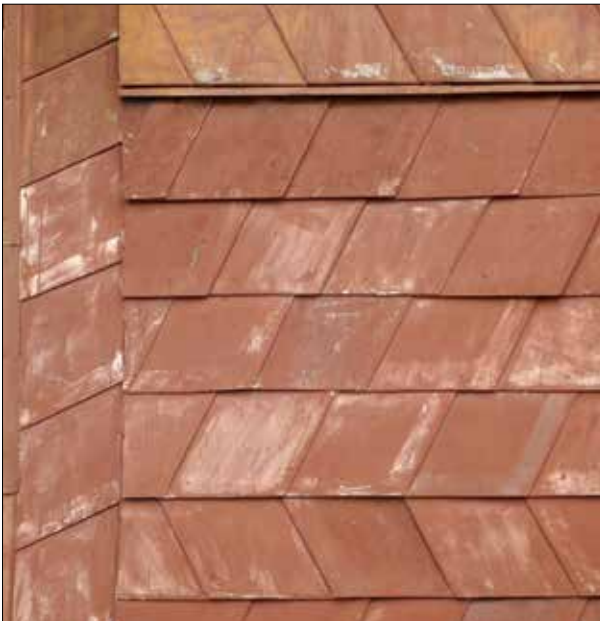
326. Starší typ zateplení, obklad štítu eternitovými šablonami. Šablony několika tvarů a formátů lze skládat různými způsoby. Kombinovat lze šablony několika barev. Pro moderní architekturu je vhodnější jednobarevná fasáda, zdálky jednotná, zblízka strukturovaná. Výhodou je trvanlivost a stálobarevnost. Na snímku cca 100 let starý obklad štítu, šedý eternit byl přetřen načerveno. Lipová-Lázně. Foto: Hana Řepková 2021.
