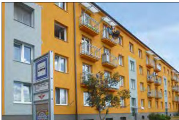
72. Čtyřpatrový dům ve stylu sořely má netektonické a nepříjemně ostré barevné řešení fasády. Osobitě kovové zábradlí bylo nahrazeno pozinkovaným normovým. Jednotné sušáky jsou orientovány do frekventované ulice Svobody k zastávce městské hromadné dopravy.
