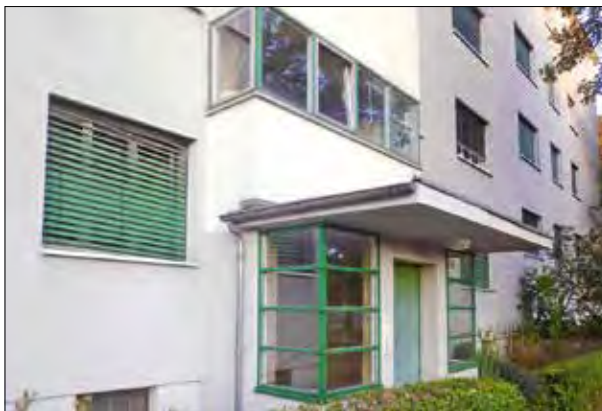
258. Příkladem obnovy památkově chráněného souboru je Krochsiedlung v Gohlis-Nord zvané též Neu-Gohlis. Soubor 21 třípatrových plochostřešných bloků složených do čtyř řad je od frekventované Landsberger Strasse oddělen čtyřpatrovou kompaktní zástavbou. Součástí vnitřního zateplení jsou okna v původním vzhledu se současnými tepelnými parametry. Na snímcích vstup z Landsberger Strasse (a), vstup z klidové části souboru (b); rozměr hlavního vstupu do souboru odkazuje na jeho uzavřenost do sebe (c). Lipsko, část Gohlis-Nord, sídlíště Krochsiedlung. Paul Mebes, Paul Emmerich, 1929–1930. Foto: Hana Řepková 2018.
