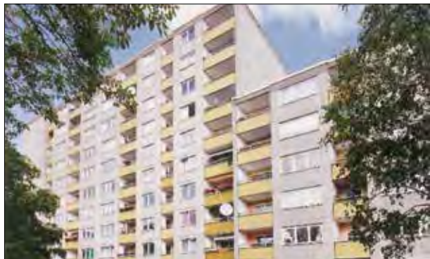
113. Nástaoba deskového bloku ze 70. let je provedena pouze nad nižší částí. Pásová okna jsou zůrazněna tmaovými rámy, nástaoba má velkou krytou terasu. Snímek (a) zachycuje původní podoba bloku, (b) blok s nástaobou. Německo, Berlín, Wohnpark Mariendorf. Převzato z: Hunger/Weidemüller/Protz 2018.
