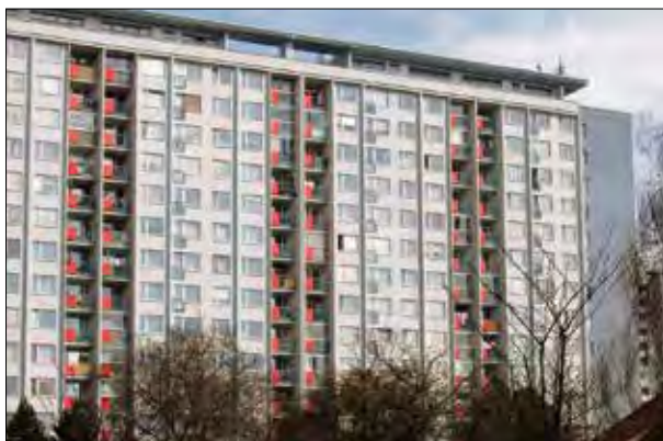
225. Jeden z bloků, jehož zateplení bylo realizováno podle barevného generelu v šedomodré barvě. Řešení podtrhuje působení červených mozaikových zábudlí. Praha 8 – Kobylisy, sídliště Dáblice, Vilém Hess, J. Schneider, 1969. Blok čp. 1296–1307, Frýdlantská 2–24. Návrh barevnosti Viktor Tuček ml., Hana Řepková. Foto: Hana Řepková, 2012.
