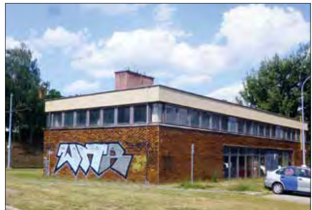
43. Atypická původní okna jsou významnou součástí hodnoty domu. Pokud není možné zachovat původní okna, je žádoucí zopakovat jejich členění bez změny, zjednodušení či dokonce zrušení. Bytový dům Kladno-Rozdělov, Kordačova 361 a 362, 50. léta (a); základní škola Polsko, Katovice, sídliště Tisíciletí, 60. léta (b); Frýdek-Místek, Dr. Antonína Vaculíka 1893–1899, 60. léta – pásová okna v suterénu vyvolávají dojem subtilnosti bytového domu (c); Brno-Bohunice – pásová okna pod střechou kotelny evokují dojem její lehkosti, 60. léta (d). Foto: Hana Řepková, 2020.
