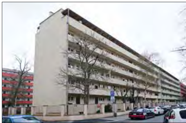
241. Pauláčové domy postavila Obecně prospěšná akciová společnost pro stavbu domů s malými byty OPAS, založená pro tento účel Ústřední sociální pojišťovnou. Praha-Pankrác, sídliště Zelená Liška, Humpolecká 22–26 a Obětí 6. května 2–6. Antonín Černý, 1932–1938. Foto: Hana Řepková, 2020.
