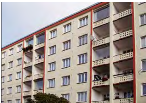
192. Tři chodbové věžové domy z konce 60. let byly v 90. letech zatepleny obkladem Feal. Na rozdíl od stěrky, jejíž poorchová úprava se špiní a bledne (oymýová), je barevnost lamel Fealu je i po desetiletích velmi uspokojivá. Rakovník, sídlišťe V Lukách, Dukelských hrdinů čp. 1773, 1782, 1804. Foto: Hana Řepková, 2019.
