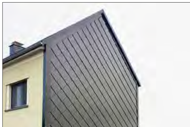
328. Solární fasády mohou být vyskládané z menších šablon s podobným šupinovým efektem jako eternit. Jedná se o inspirační příklady možných způsobů realizace technického řešení, nikoli o doporučení nebo dokonce závazné řešení. Převzato z: https://t-power.cz/solarni-fasady/ , vyhledáno 12. 12. 2022.
