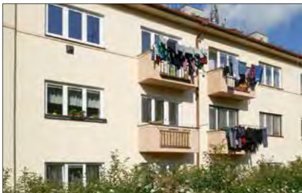
69. Přestože lze prádlo sušit uvnitř balkonu, jsou na zábradlí osazovány rozličné konstrukce a prádlo „zdobí“ ulici. Litomyšl. 50. léta 20. století. Foto: Hana Řepková, 2020.
