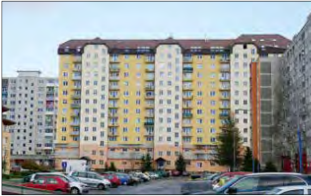
293. I na Slovensku se objevují nástavby a šikmé střechy na panelových domech. Přestože jsou slovenské realizace méně hřmotné než české, platí, že mansardové střechy na panelové domy nepatří – stylově ani proporčně. Barevnost průčelí je naopak zdařilá. Slovensko, Poprad, sídliště Juh 3, Novomestského 19–23. Josef Hóbrla. Přelom 80. a 90. let. Foto: Hana Řepková 2019.
