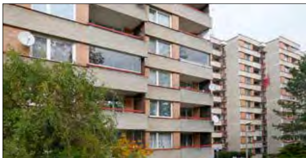
254. I nadále vznikala dobrá bytová architektura, ale především sčerpáním, družstevní formou. Na snímku dva ze šesti věžových domů v Liberci – Králově Hájí z poloviny 70. let 20. století. Dvanáctipatrové domy s členitým půdorysem kombinující panely s cihelným páskem mají několik typů lodžii a balkonů. Liberec-Kristiánov, sídliště Králův Háj, Franklinova čp. 575 a 579, Foto: Hana Řepková, 2020.
