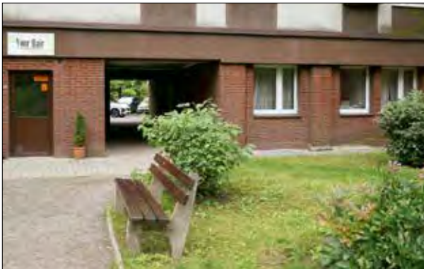
177. Parter věžových domů protkaný průchody je obložen cihelným páskem. Solidnost umocňují i kvalitní materiály parteru. Polsko, Katowice Sídliště I. J. Paderevského. 70. léta. Foto: Hana Řepková, 2021.
