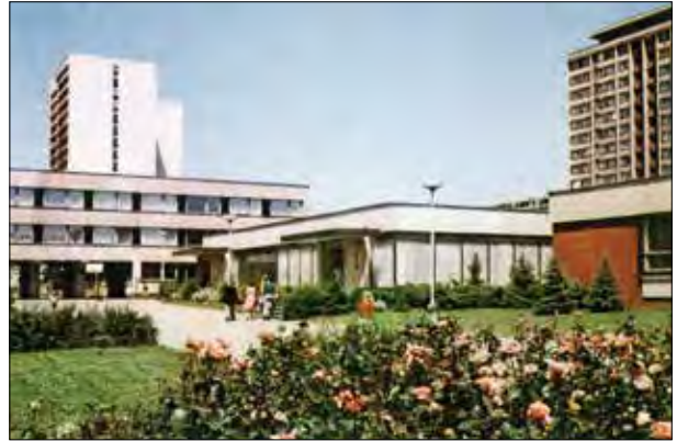
188. Převažující bílá barva, s černými doplňky a červenými akcenty. Černé okení rámy a meziokenní oložky, cihelný obklad fasád (pošta) a červené mozaikové čtverce lodžii. Praha 8 – Kobylisy, sídliště Ďáblice, Viktor Tuček, Antonín Vranka, Jiří Kulišťák 1968–1975. Průhled Burešovou ulicí k severu. Přežato z Tuček 1984.
