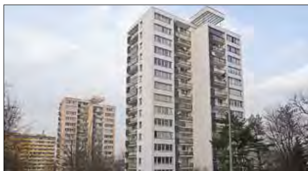
93. Prokem typickým pro humanistickou fázi výstavby sídlišť 60. let byly střešní pergoly. Nejčastěji měly funkci architektonizace útaahové šachty (skořepinové střechy na věžových domech sídliště Invalídovna), jejího faktického orámování (Praha 8 – Dáblíce, Beroun-Hlíčky), či jen funkci symbolickou (Praha 8 – Kobylisy). Zde má funkci čistě výtoarnou. Střešní pergola je vždy aluzí na střešní terasy, i v případě, že střecha není pochozí. Praha 4 – Krč, Bernoláková čp. 1226/2 a 1190/4. Foto: Hana Řepková, 2021.
