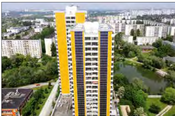
327. Do architektury doacetipatrového domu jsou zakomponovány fotovoltaické panely. Německo, Berlín, sídliště Hellersdorf, Helene-Weigel-Platz 6/7. 70. léta 20. století. Foto: Hana Řepková, 2018.
