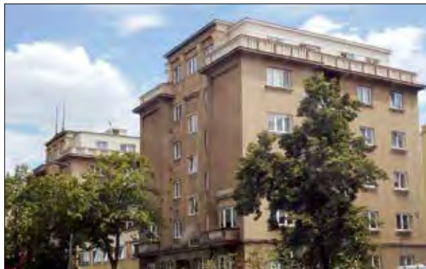
121. Zděné zábradlí střešních teras, 50. léta 20. století. Praha-Břeunov, Patočkova ulice. Foto: Hana Řepková, 2020.
