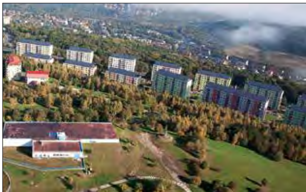
329. Fotovoltaické panely jsou jednotně instalované na konstrukcích evokujících pultové střechy. Teplice, sídliště Nová Ves, ulice Javorová, Habrová, Březová a Novoveská. Foto: Jiří Jiroušek, 2019.
