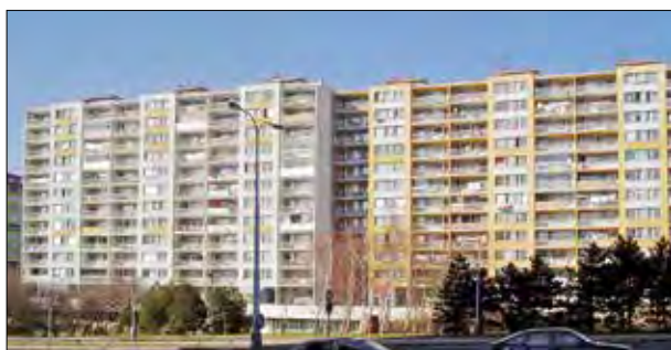
141. Stejný princip byl použit i na opačném rameni „větrníků“, zdůrazňuje monumantalitu hlavní třídy souboru. Praha 8 – Bohnice, sídliště Bohnice, čp. 402–412, Katovická 2–22. Foto: Hana Řepková, 2012.
