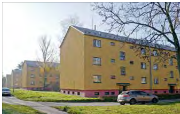
160. Skupina stejných domů řešena jednotně. Okna mají rámy ve shodné barvě s dveřmi a klempířskými proky. Soubor je chráněn jako městská památková zóna. Ostrava-Poruba, čp. 362–365, Dělnická 27–33. Pohled k jihu. Konec 40. let. Foto: Hana Řepková 2021.
