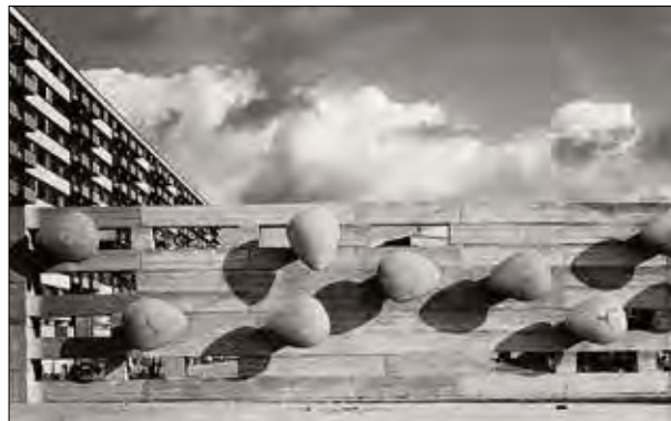
207. Nadčasovým urbanismem, kvalitní architekturou a množstvím děl významných výtvarníků vyniká brněnská Lesná. Na fragmentu průčelí deskového domu je patrná dobová barevnost: bílé parapetní panely, šedé desky zábradlí z jemně vlnitého plechu, černé meziokenní oložky a rámy oken. Lesná je galerií pod širým nebem, dekorativní stěny mezi hřišti jsou dílem významných tvůrců. Zde dekorativní stěna od Sylvy Lacinové, litý beton, 1969. Cenné sídliště je narušeno demolicemi, dostavbami, přestavbami a nástavbami. Návrh na prohlášení souboru výtvarných děl za kulturní památku byl již podán, řízení dosud nezačáto. Brno-Sever, sídliště Lesná, Jurkovičova ulice. František Zounek, Viktor Rudiš, 1961–1970. Foto: Josef Tichý, 1969. Přezato z: Kořínková 2015.
