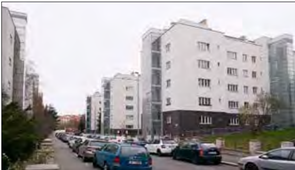
152. První dva domy břevnovského malobytového souboru ze 30. let orientované štítem do ulice Patočkova získaly přístavbu barevných výtahů v roce 2005. Sousední domy na ně navázaly (a), domy orientované do ulice Nad Kajetánkou získaly přístavbu výtahů zhruba o 10 let později, již v provedení z čirého skla kombinovaného s pískovaným (b).
