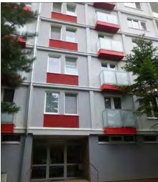
295. Kontrastní barevnost zdůrazňující prvky fasády: (a) – v červené celá nosná konstrukce balkonu, méně vhodné je nabarvení parapetu; (b) – barevná pole fasády částečně zvýrazňují skeleto-panelovou konstrukci.
