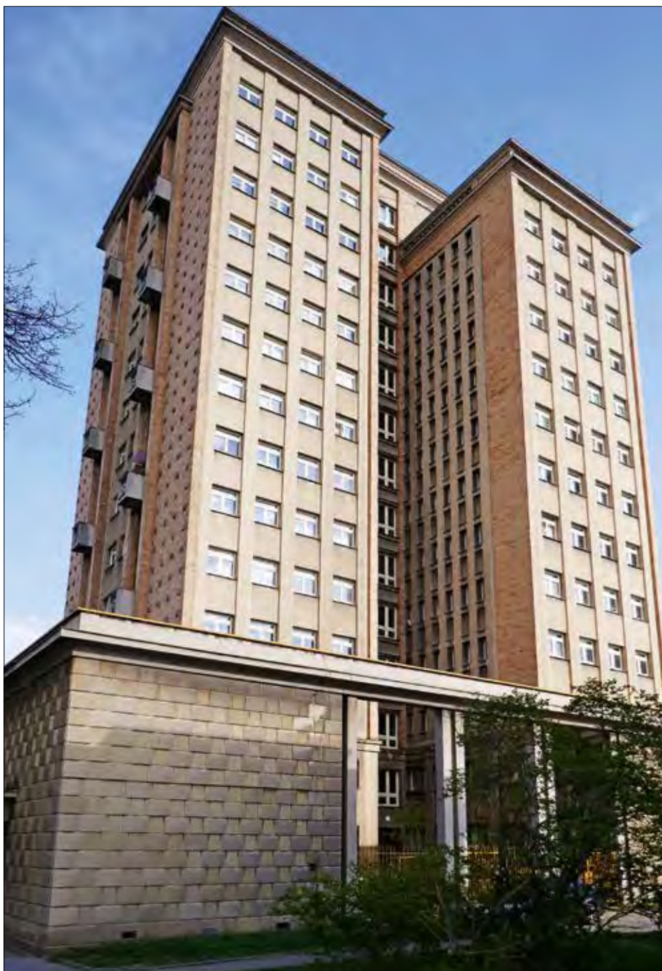
11. Atypické věžové domy s obkladem, omítkou a omítkovou rustikou mají vyzdívanou skeletovou konstrukci. Šestice výškových domů je součástí sídliště Rozdělov a přesto z něj zcela vybočuje. Pro svou výjimečnost jsou památkově chráněné. Kladno-Rozdělov, Vítězná 2955, Josef Haulíček. Foto: Hana Řepková, 2018.
