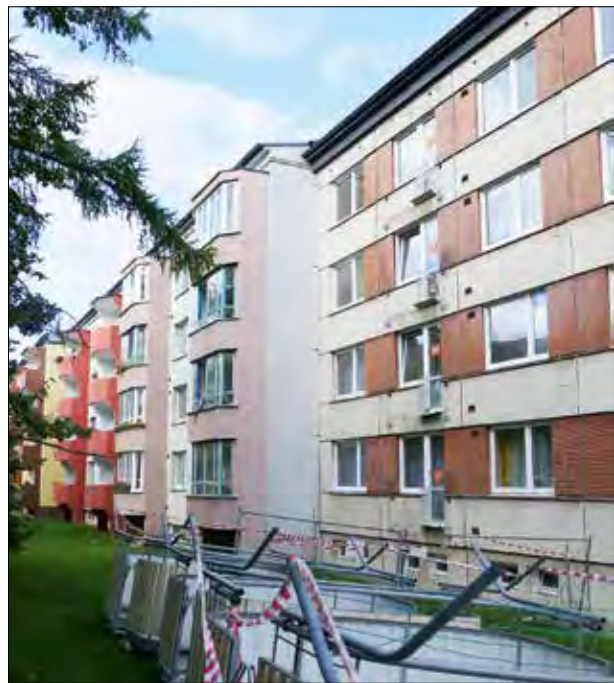
101. Zánik pásových oken s meziokenními oložkami ze skleněné mozaiky v přímém přenosu: vlevo několik tvarových i barevných variací přistavěných lodžii, jedna horší než druhá. Uprostřed tvarově jednodušší lodžie s rovnými boky jednotně zasklené jako arkýře. Vpravo řemenová fasáda se skleněnou mozaikou ve velmi dobrém stavu. Vlastníci si však drahého a luxusního materiálu neováží. Jihlava, sídliště Břežinovy sady. 60. léta. Foto: Hana Řepková, 2020.
