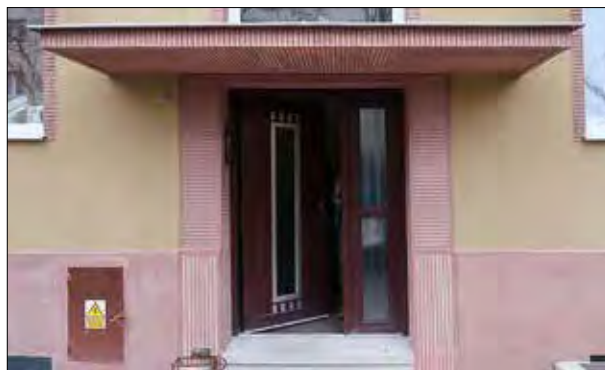
148. Příkladná restaurátorská obnova portálu památkově nechráněného objektu. Polsko, Gdyně, Krasickiego 38. 30. léta 20. století. Přeuzato z: https://www.whitemad.pl/budynek-z-lat-30-xx-wieku-gdynia/ , vyhledáno 8. 12. 2022.
