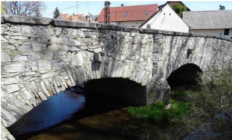
Obr. 90. Žichovice, 1. pol. 17. století – provedení funkčního odvodnění.
