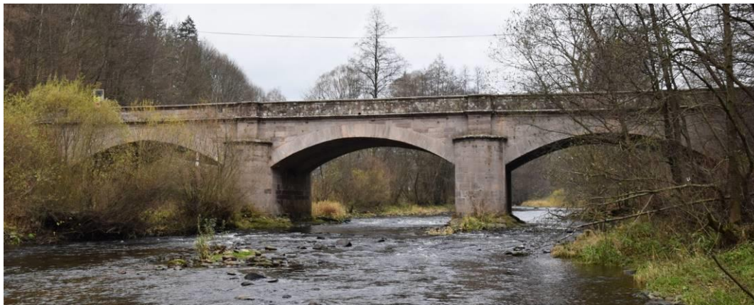
Obr. 105. Poniklá, pohled na most od jihu.
