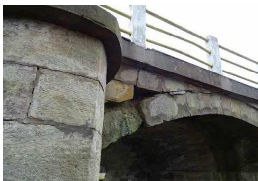
Obr. 87. Městská Habrová, 2.pol. 19.stol. trhlina ve spáře
