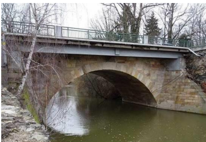
Obr. 98. Beroun, 1864, rozšíření mostu betonovou deskou.
