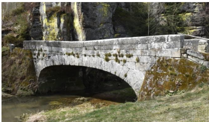
Obr. 112, 113. Troskovice, Podsemínský most, poklesnutí středu klenby.
