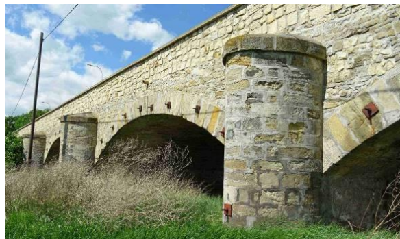
Obr. 94. Postoloprty, 1. pol. 19. století, klenba s osazenými příčnými táhly.
