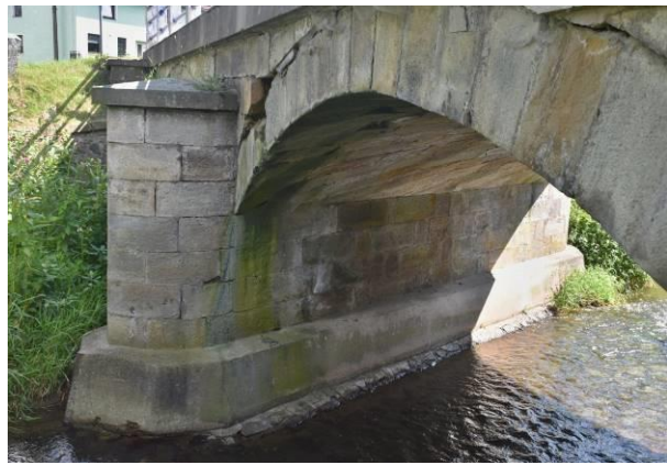
Obr. 109, 110. Městská Habrová, poruchy s trhlinami podél klenby.
