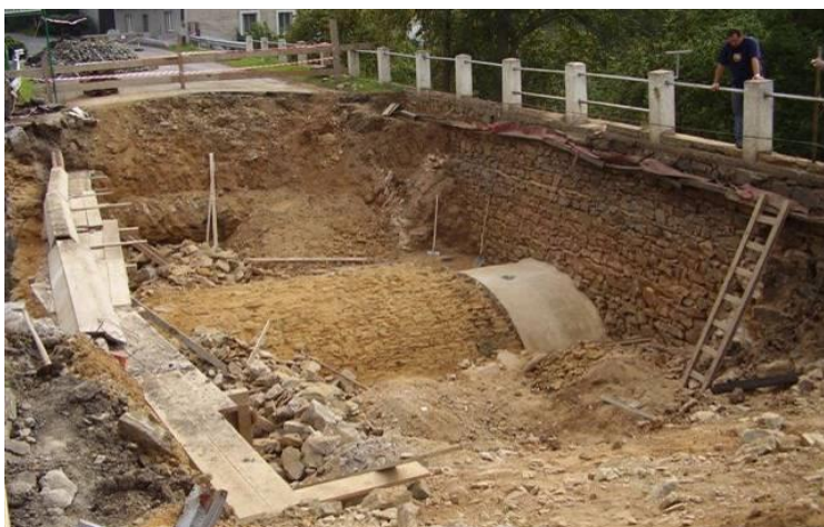
Obr. 100. Kouřim, 2. pol. 19. stol., odhalený rub kamenné klenby, na pravé straně je vidět dodatečné rozšíření mostu pozdější betonovou klenbou.
