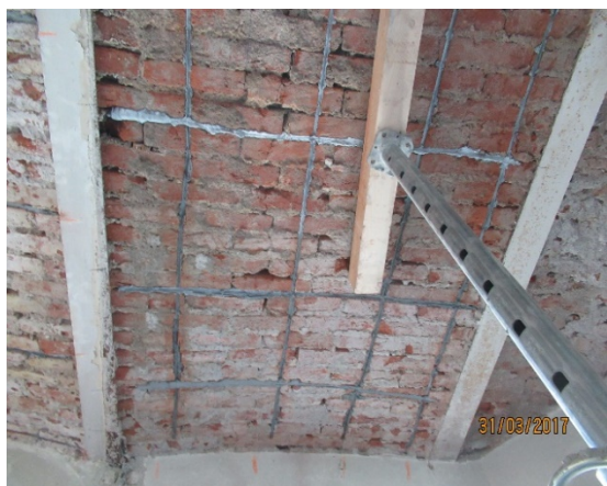
Foto č. 1: Sanace cihelné klenby vloženou výztuží z vysoko pevnostní oceli (autor: I. Šimůnek)
