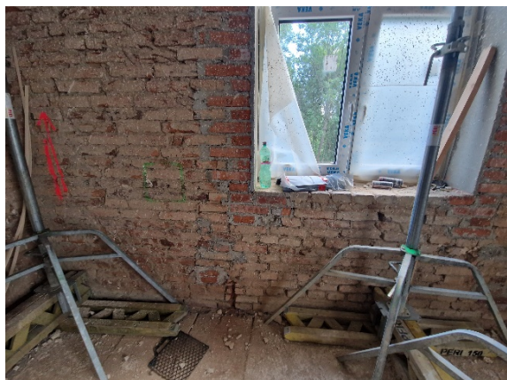
Foto č. 3: Náhrada části vadného zdiva (autor: I. Šimůnek)
