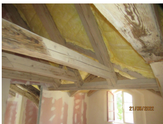
Foto č. 5: Protézování prvků krovu (autor: I. Šimůnek)
