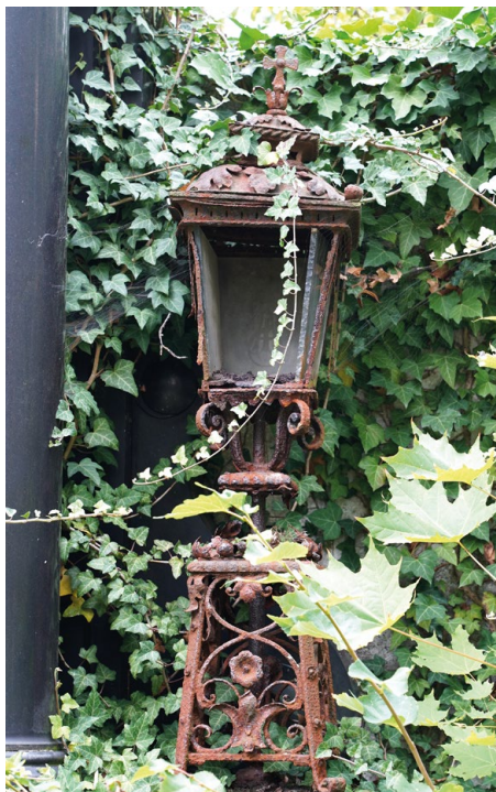
Obr. 20: Kovová lucerna s částí zachovaných původních skleněných výplní s gravírovanými ornamenty se symbolem kříže. Hřbitov v Hodkovicích nad Mohelkou.
