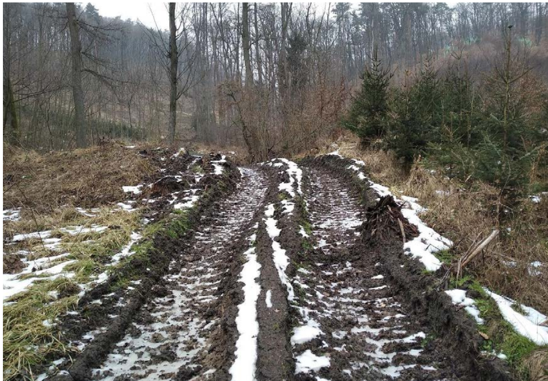
Hrás rybníka porušená vedením lesní cesty. (Foto: Jakub Novák, 2021)
