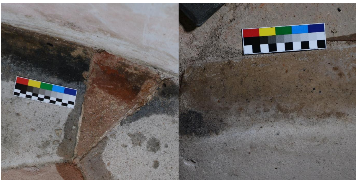
Obr. 3 Okrajové části, kde se dochovaly povrchové úpravy naznačující možné barevné provedení „černé“, „červené“ a „žluté“ dlažby.
