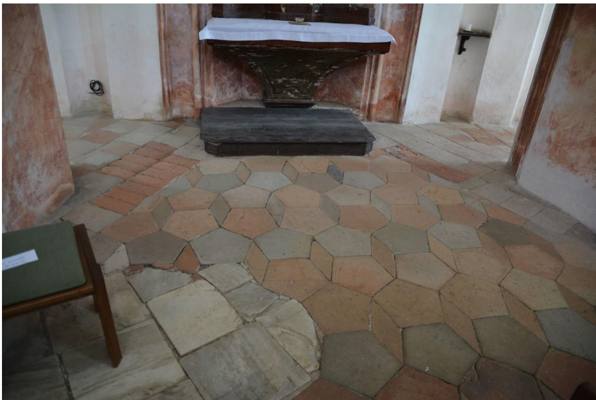
Obr. 2 Směrem od středu se střídají „černá“, „žlutá“ a „červená“ pětiboká dlaždice, což je dobře viditelné v pravém dolním rohu fotografie, ale směrem k oltáři jsou barvy „žlutých“ a „červených“ dlaždic zaměnitelné. Dlažba prostoru u oltáře 3.
