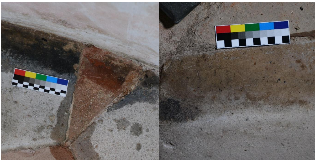
Obr. 3 Okrajové části, kde se dochovaly povrchové úpravy naznačující možné barevné provedení „černé“, „červené“ a „žluté“ dlažby.
