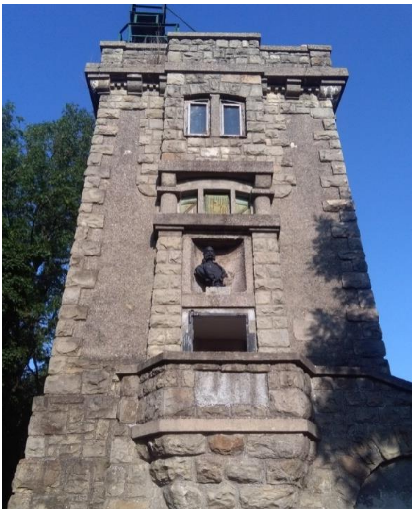
Obr. 5 – Vyhliďková věž z roku 1908 na místě zbořeného Husarského chrámu (foto J. Drozda)
