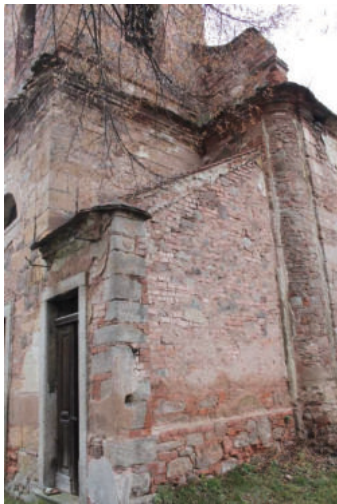
Schodišťový přístavek v pohledu od jihozápadu. Foto: T. Brož 2014.
