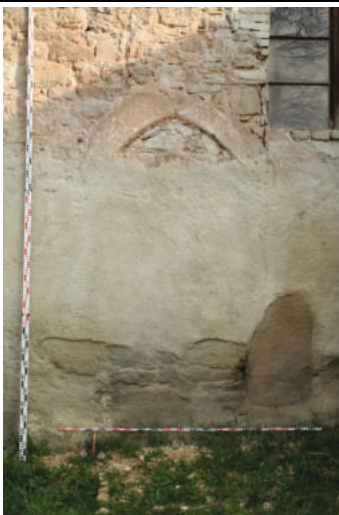
Detail zazděného středověkého portálu na jižní straně lodi. Foto: J. Skopec 2014.
