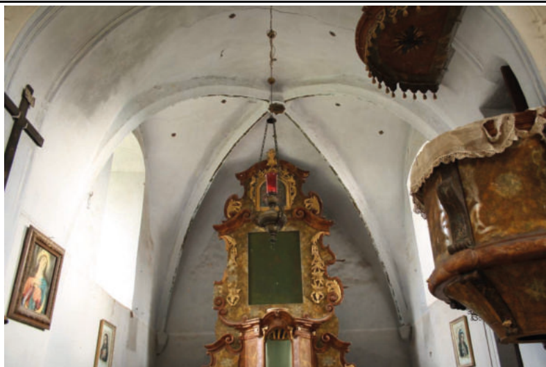
Pohled na klenbu presbytáře od západu. Foto: J. Skopec 2014.
