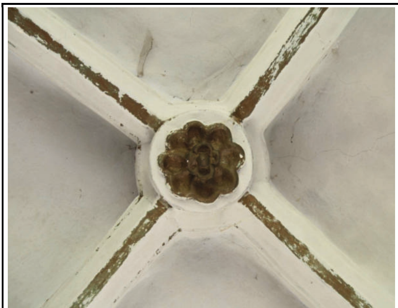
Detail svorníku klenby presbytáře. Foto: J. Skopec 2014.
