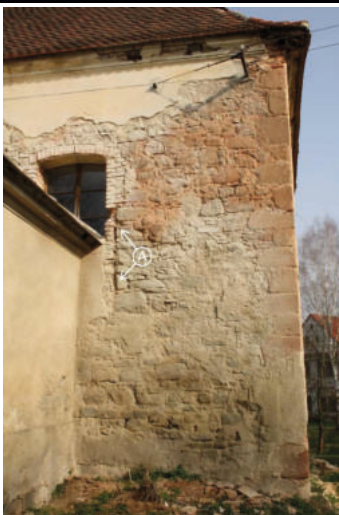
Pohled na východní polovinu jižního průčelí presbytáře. A – spára mezi cihelnou obezdívku stávajícího okenního otvoru a zalícovaným kamenným zdivem presbytáře, které naznačuje možnost existence středověkého okenního otvoru. Foto: J. Skopec 2014.
