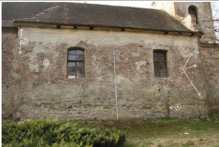
Čelní pohled na severní průčelí lodi. A – vertikální spára určující původní délku středověké lodi s dochovanými kvádry spodní partie nárožního armování. B – středověké kvádry druhotně použité při prodloužení lodi v roce 1788. C – zazděný okenní otvor pocházející z bližší neurčitelné doby před rozšířením lodi roku 1788. D – přezděné nároží související patrně s rozšířením lodi roku 1788. Foto: J. Skopec 2014.
