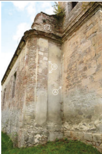
Pohled do severního koutu svíraného západní stěnou lodi a severní stěnou věže. A – dřík pilastru západního průčelí věže, který byl zakryt dodatečně přiloženou věží. B – středověké kvádry druhotně použité při prodloužení lodi v roce 1788. C – zachovaný fragment štítu z doby výstavby věže, který je oddělený zřetelnou spárou od úpravy patrně z 30. let 19. století. Foto: J. Skopec 2014.
