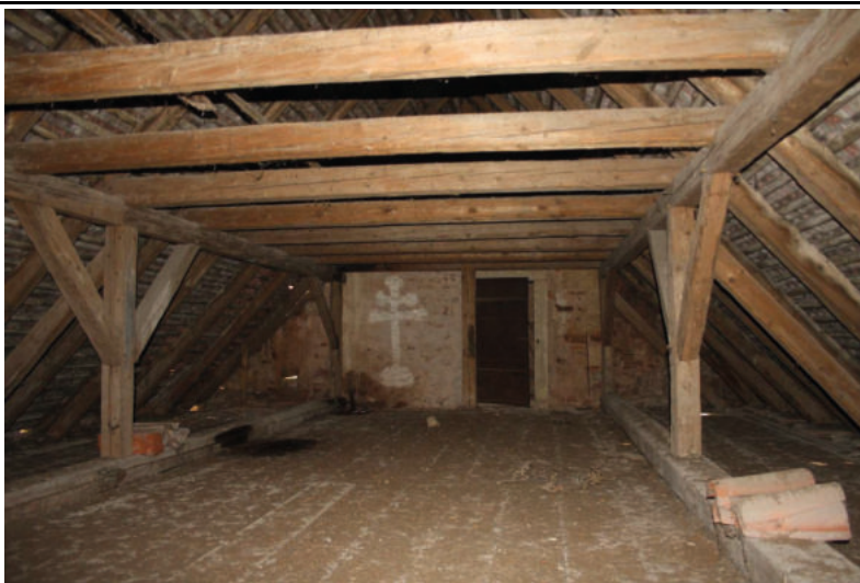
Pohled do krovu nad lodí směrem k západu. Foto: J. Skopec 2014.
