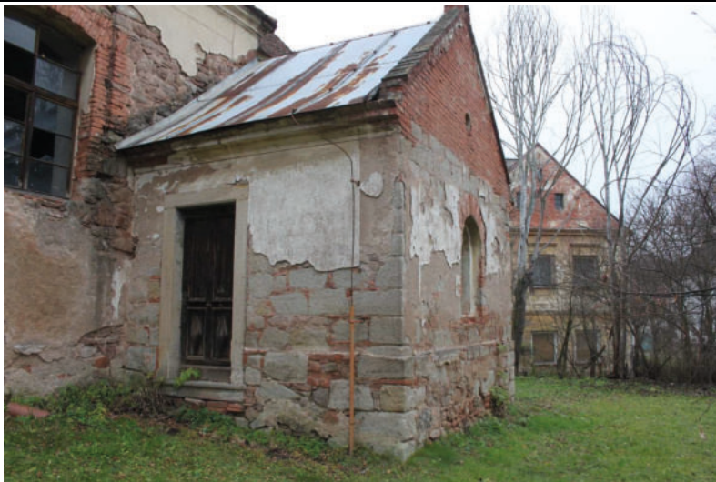
Sakristie v pohledu od jihozápadu. Foto: T. Brož 2014.
