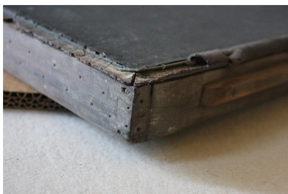
Obr. 17: Profilované a sesazované rohové spoje.
