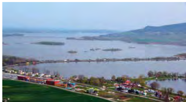
Obr. 4.1.1 Současný letecký snímek soustavy nádrží Nové Mlýny (H. Mlejnková, 2016)
