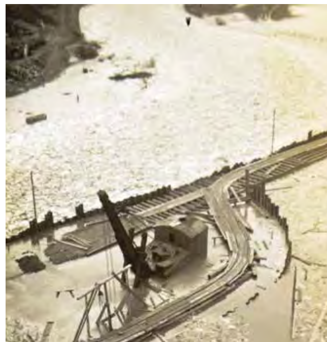
Obr. 2.1.2 Stavba hráze Vranovské přehrady, pohled na údolí zatopené povodní, která prověřila dílo ještě před jeho dokončením, 4.1.1932 (Povodí Moravy, s.p., Znojmo)
