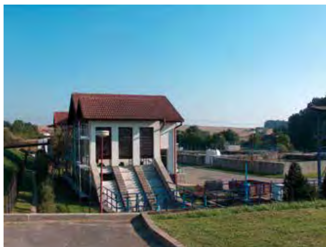
Obr. 1.3.7 Čistírna odpadních vod ve Velké Bíteši (S. Juráš, 2010)
