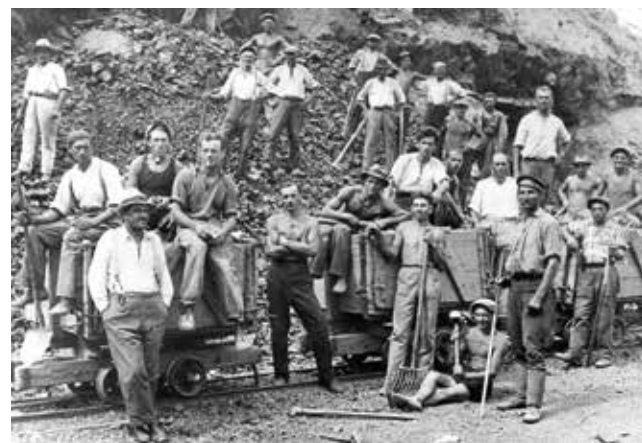
Obr. 3.1.2 Parta stavebních dělníků na stavbě hráze Kníničské (dnes Brněnské) přehrady (www.brneskaprehrada.cz)
