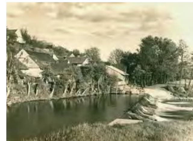
Obr. 3.9.6 Šikmý pevný jez v obci Kníničky (archiv MČ Brno-Kníničky/Zeno Čížmář)
