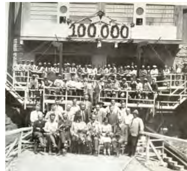
Obr. 2.1.5 Spotřebováno 100 000 m 3 betonu, 21.5.1932 (Povodí Moravy, s.p., Znojmo)
