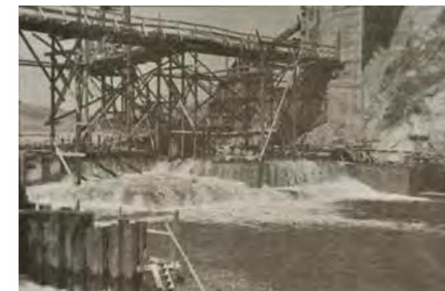
Obr. 3.9.4 Povodeň v březnu 1939 na rozestavené hrázi Brněnské přehradě (ŠLEZINGR 1998)
