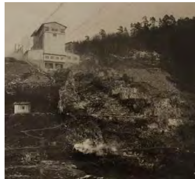
Obr. 2.1.3 Stavba hráze Vranovské přehrady – odstřel v lokalitě budoucí kaskády, 1931 (Povodí Moravy, s.p., Znojmo)
