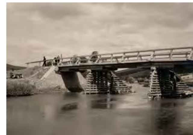
Obr. 3.9.5 Dřevěný most se dvěma pilíři přes Svatku v obci Kníničky (Ze sbírky Národního památkového ústavu v Brně)
