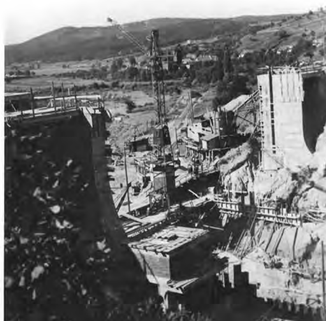
Obr. 3.1.1 Stavba hráze Kníničské přehrady, v pozadí dnes zatopená obec Kníničky, 1939 (www.brneskaprehrada.cz)
