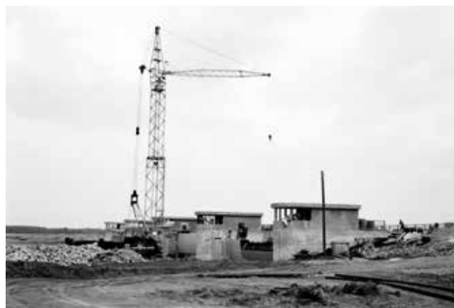
Obr. 4.1.2 Stavba hráze horní nádrže vodního díla Nové Mlýny – pohled na segmentový uzávěr s nasazenou klapkou (Regionální muzeum v Mikulově)
