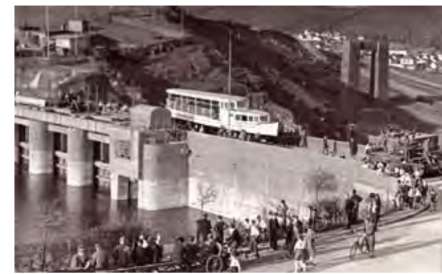
Obr. 3.1.6 Transport první lodě do přístaviště v Brně-Bystrci (Archiv MČ Brno–Kníničky/Zeno Čížmář)
