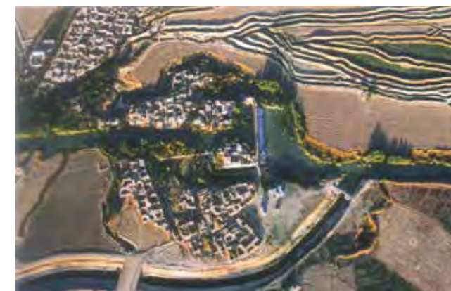
Obr. 1.2.2 Emírova přehrada (Band-e Amir) byla vybudována v roce 980 na místě ještě starší nádrže. Slouží k zavlažování oblasti Marv Dacht v Íránu (převzato z J. Němce, 2016)
