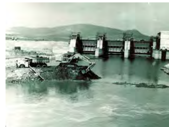
Obr. 4.1.4 Stavba dolní novomlýnské nádrže, 1987 (Povodí Moravy, s.p.)
