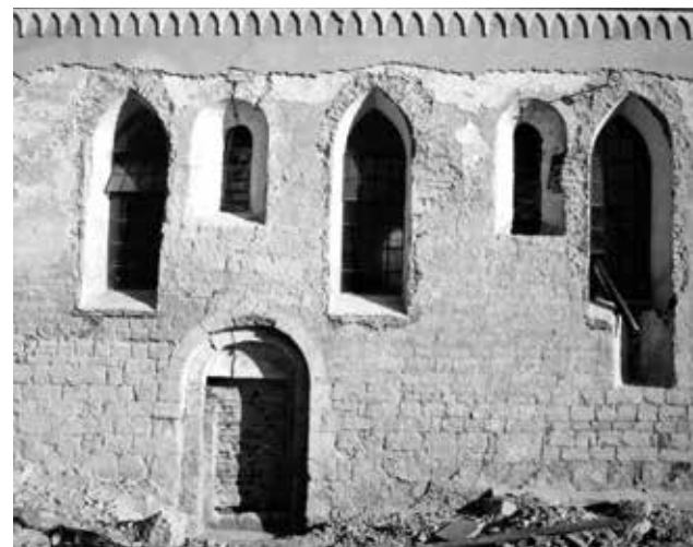
Obr. 4.2.3 Mušov, kostel sv. Leonarda. 1 – původní vstup do románského kostela z jižní strany, 2 – jižní strana kostela po odstranění novodobé omítky. Patrna jsou dvě románská okna a portál (Regionální muzeum v Mikulově)
