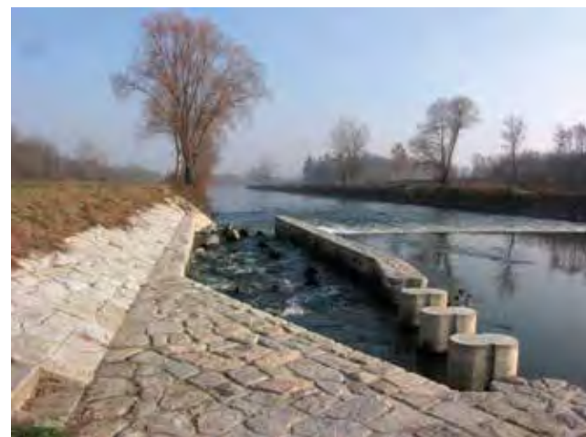
Obr. 4.6.10 Rybí přechod přes Jamborův práh v Lednici dokončil migrační zprostupnění řeky Dyje po Nové Mlýny (D. Veselý, 2012)
