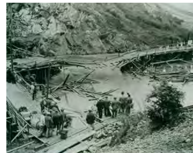
Obr. 3.9.3 Dělníci na staveništi Brněnské přehradě za povodně v létě 1937 (archiv MČ Brno–Kníničky/Zeno Čížmář)
