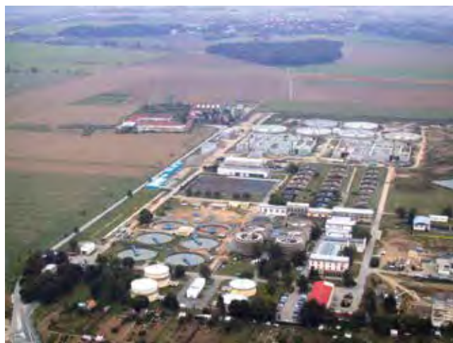
Obr. 1.3.6 Čistírna odpadních vod v Brně-Modřicích, 2002 (Brněnské vodárny a kanalizace, a.s.)
