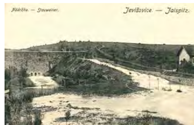
Obr. 1.2.1 Nádrž Jevišovice na dobových pohlednicích (na spodní si můžeme všimnout hrázného sledujícího průchod povodně) (archiv autora: D. Veselý)
