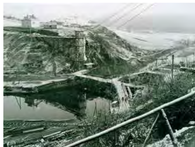
Obr. 3.1.3 Stavba Kníničské přehrady v letech 1937–1938 (www.brneskaprehrada.cz)
