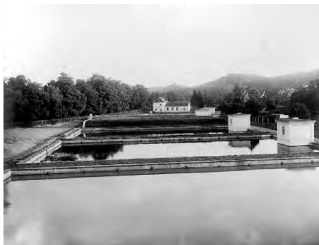
Obr. 3.7.1 Úpravna vody Brno–Pisárky (Brněnské vodárny a kanalizace, a.s.)
