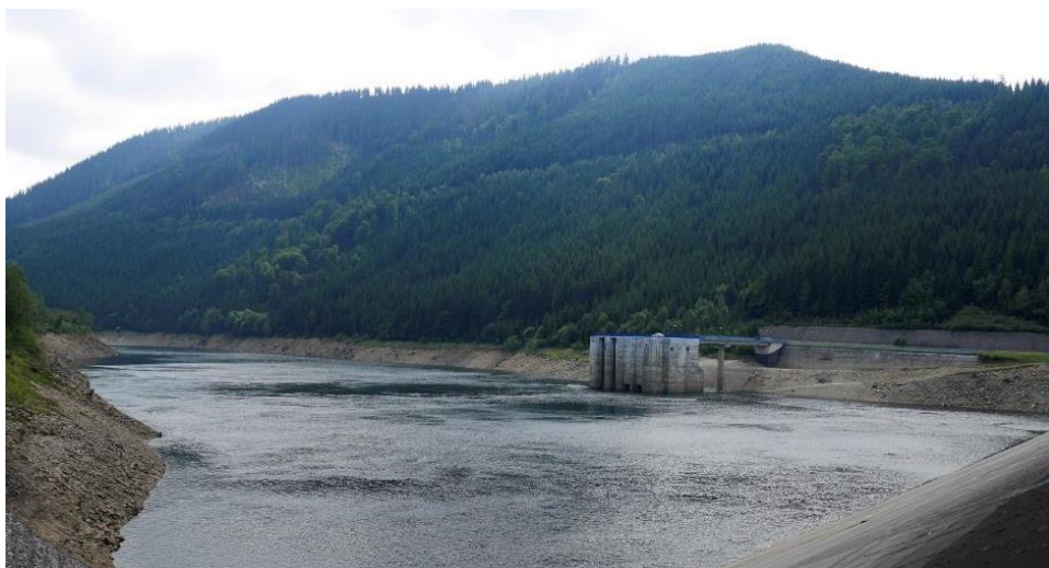
Obr. 4.147: PVE Dlouhé Stráně – dolní nádrž. Foto Michaela Ryšková, 2019.
