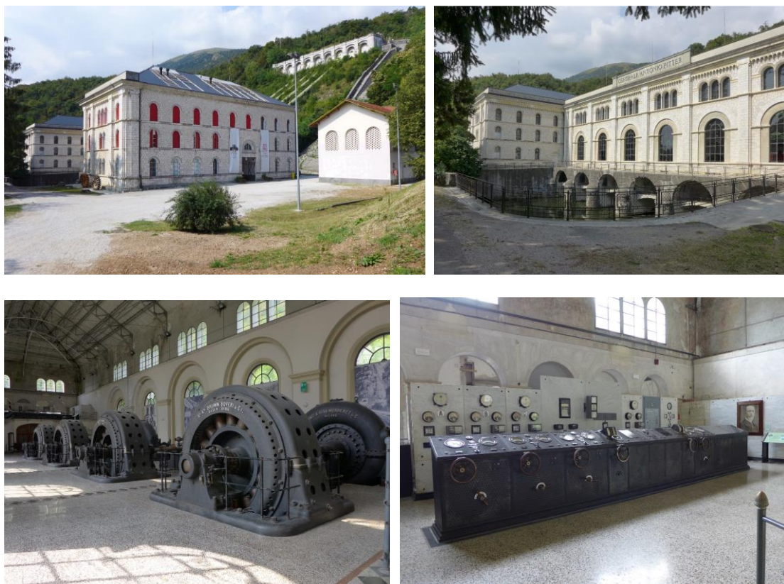
Obr. 5.16: Malnisio di Montereale Valcellina (Itálie): vodní elektrárna A. Pitter. Foto Michaela Ryšková, 2016.
