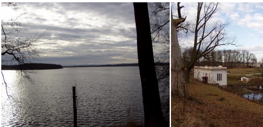
Obr. 4.72: Rybník Rožmberk a malá vodní elektrárna vybudovaná při rybníku Rožmberk v roce 1922. Foto Eva Dvořáková, 2006.
