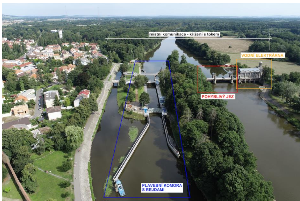
Obr. 4.120: Stupeň Poděbrady – prvky funkčního celku. Foto Radek Bachan, 2021.
