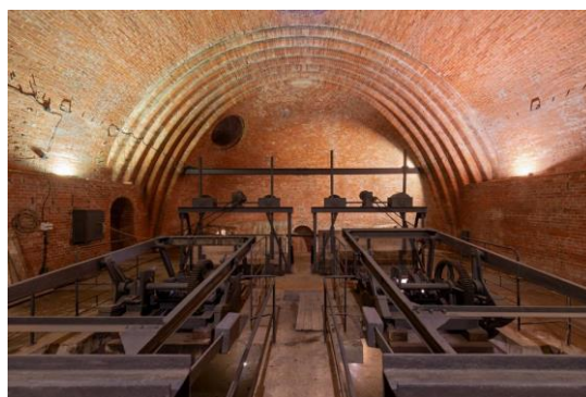
Obr. 3.23: Bethlehem (USA), čerpací stanice. Evropské raně moderní systémy zásobování vodou 16. a 17. století na principu vzdáleného gravitačního napájení s čerpadly poháněnými vodními koly byly přeneseny do Ameriky. Za nejstarší čerpací stanice vody v USA je považována stanice vybudovaná v roce 1754 pro potřeby městečka Bethlehem, založeného přistěhovalci tzv. Moravské komunity. Voda byla čerpána z pramene do vodárenské věže a odtud proudila gravitačně do pěti cisteren a nádrží. V budově na snímku pracovala čerpací stanice do roku 1832. (Douet, 2018). Foto Michaela Ryšková, 2018.
