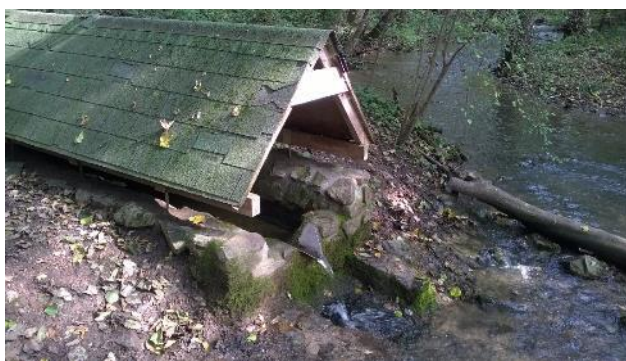
Obr. 4.207: Ochoz u Brna – pramenní jímka (tzv. Kaprálůva studánka) zachytávající vývěry podzemní vody v těsné blízkosti řeky Říčky. Foto David Honek, 2014.
