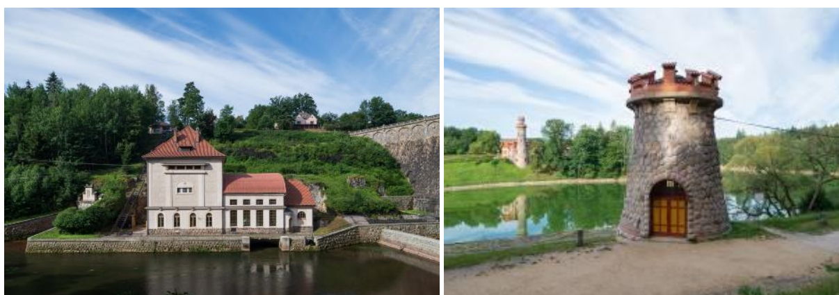
Obr. 4.39: Přehrada Les Království (1910–1919) – vlevo budova vodní elektrárny. Vpravo šoupátková věž pro ovládání spodních výpustí v levém obtokovém tunelu, v pozadí domek hrázného. Foto Viktor Mácha, 2020.
