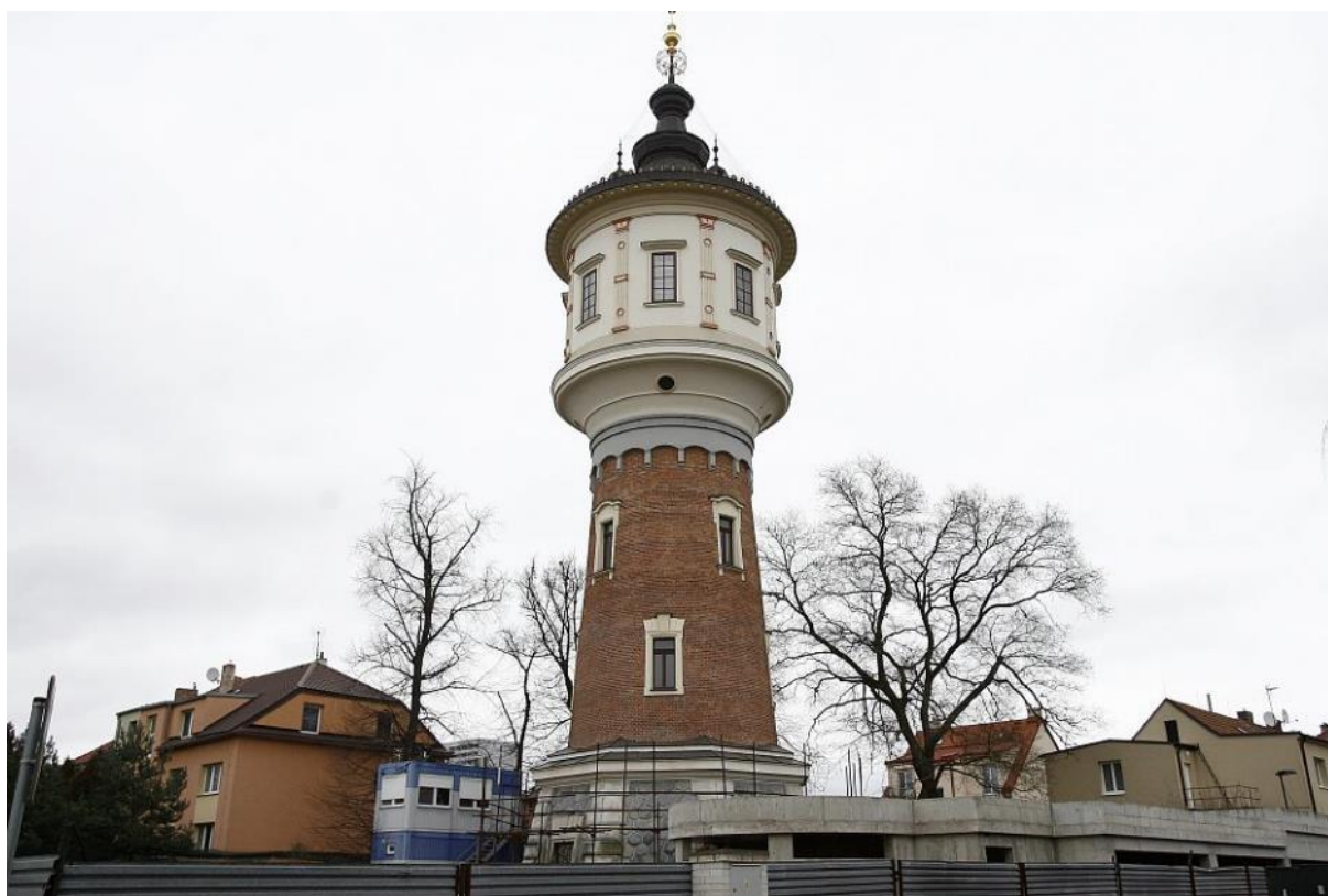
Obr. 5.22: Praha-Libeň – věžový vodojem na Mazance – po rekonstrukci a přestavbě na bydlení. Foto J. Kořátko, 2017.
