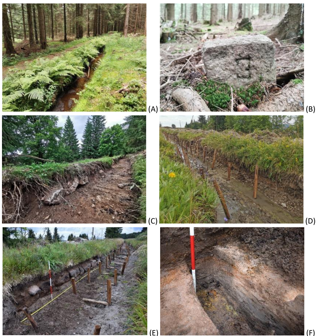
Obr. 5.13: Blatenský vodní příkop: (A) lesní partie toku, stav před rekonstrukcí; (B) historický mezník na hranici pozemku vodního toku; (C) koryto po vyjmutí dožilé výdřevy; (D) beranění nové výdřevy koryta. Foto Jakub Chaloupka, 2021; (E) Blatenský příkop u Kozích sejfů těsně nad Horní Blatnou, ukázka začištěného armování břehů odkrytého stavbou; (F) příkop u Kozích sejfů nad Horní Blatnou, ukázka sedimentačního
