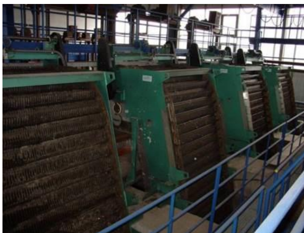
Obr. 4.239: Jemné česle – strojně stírané (převzato z: archiv VÚV).
