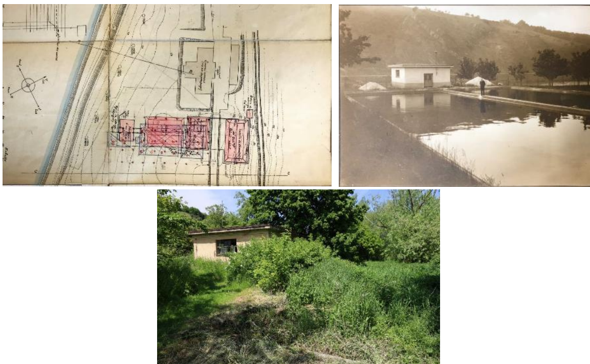
Obr. 4.199: Praha, Bohnice – soukromá říční vodárna pro potřeby Zemského ústavu pro choromyslné, nové filtrační zařízení – polohopisný plán a usazovací nádrže v roce 1926 a současný stav usazovacích nádrží. V roce 1925 ke spuštění samostatně stojící filtrační stanice, která čistila vodu, čerpanou z původní čerpací stanice. Systém sestával z čerpací stanice a pískových filtrů systému Puech-Chabal. Nejpozději roku 1972 došlo k odstavení celého systému a napojení Ústavu na městský rozvod vody. Budova strojovny je v současnosti využívána jako zázemí pro autoopravnu, filtry byly zavezeny zeminou, ostatní budovy byly buď destruovány či nechány ladem. Foto Archiv PVK, f. PV, kt. 249, sign. H – 1096, f. Fotoarchiv PVK, kt. 16, sign. OV - 239 a Jan Kolář, Archiv PVK, 2021.
