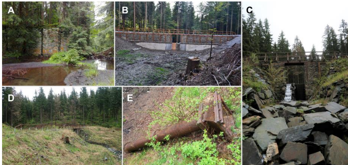
Obr. 5.11: Žďárský potok, obnova klauzy na Splavském potoce: (A) zbytky původní hráze (převzato z: Rymarovsko, 2021); (B) opravená hráz z návodní strany (převzato z: Rymarovsko, 2021); (C) středná část hráze s průtočnou sekci; (D) celkový pohled na hráz ze vzdušní strany; (E) původní odtokové potrubí. Foto (C), (D) a (E) Martin Caletka, 2021.
