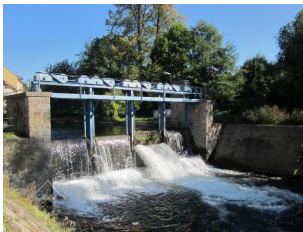
Obr. 4.108: Vlevo stavidlový (tabulový) jez zdvižný. Schéma Radka Račoch a Radek Bachan, 2021 (upraveno dle: Gabriel a kol., 1989). Vpravo stavidlový jez na Metuji v Hronově (převzato z: vodnimlyny.cz, 2013.)
