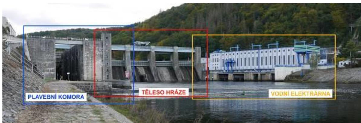
Obr. 4.35: VD Štěchovice (1937–1945) – tížná betonová hráz. Ukázka funkčního celku – přehrada + plavební komora + vodní elektrárna. Foto Michaela Ryšková, 2020.
