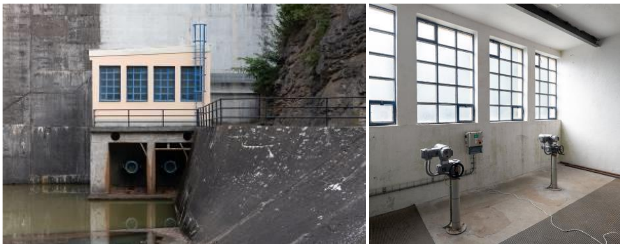
Obr. 4.24: Přehrada Vrchlice (1966–1970) – klenbová přehrada. Vlevo provozní rozstřikovací uzávěry spodních výpustí, vpravo ovládací zařízení rozstřikovacích uzávěrů. Foto Viktor Mácha, 2020.
