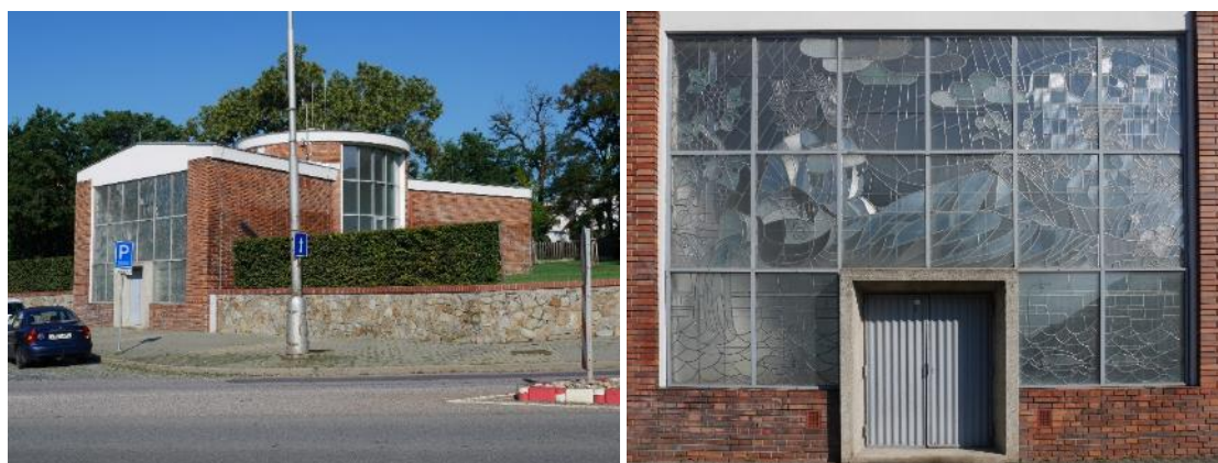
Obr. 3.19: Znojmo, zemní vodojem se dvěma železobetonovými kruhovými nádržemi byl postaven v letech 1949-1950 podle návrhu Viléma Lorenze. Pro okno v uličním průčelí byla zhotovena vitráž Allegorie řeky Dyje z různě strukturovaného skla provedená podle návrhu Vojtěcha Kubašty roku 1950 (Stará, 2007). Foto Michaela Ryšková, 2020.
