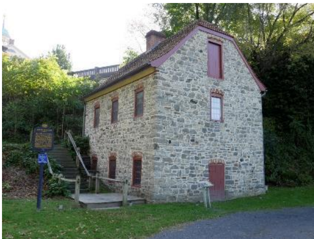
Obr. 3.23: Bethlehem (USA), čerpací stanice. Evropské raně moderní systémy zásobování vodou 16. a 17. století na principu vzdáleného gravitačního napájení s čerpadly poháněnými vodními koly byly přeneseny do Ameriky. Za nejstarší čerpací stanice vody v USA je považována stanice vybudovaná v roce 1754 pro potřeby městečka Bethlehem, založeného přistěhovalci tzv. Moravské komunity. Voda byla čerpána z pramene do vodárenské věže a odtud proudila gravitačně do pěti cisteren a nádrží. V budově na snímku pracovala čerpací stanice do roku 1832. (Douet, 2018). Foto Michaela Ryšková, 2018.
