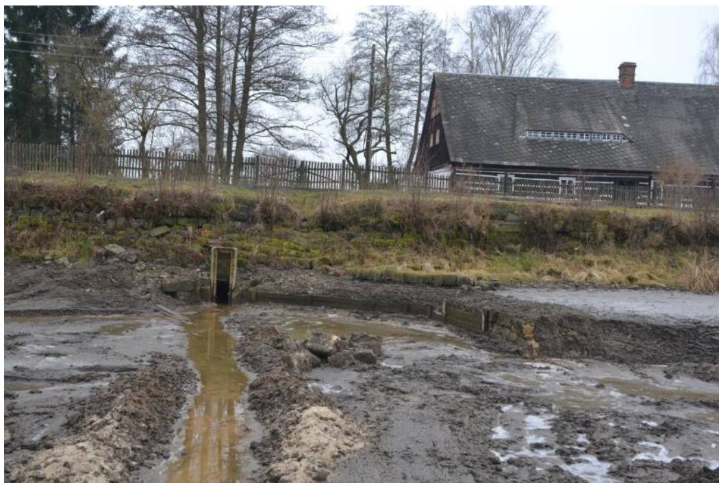
Obr. 4.64: Markvartice u Jablonného v Podještědí, Markvartický rybník – spodní výpusť jalového odtoku s požrákem, návodní líc s typickým opevněním z pískovcových kvádrů, stav po vypuštění rybníka. Foto Miroslav Kolka, 2014.
