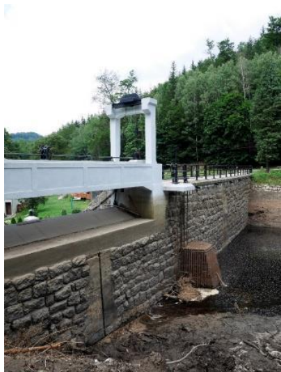
Obr. 4.132: MVE Rudolfov II: (A) návodní líc hráze se vtokovým objektem; (B) strojovna MVE. Foto Michaela Ryšková, 2021.
