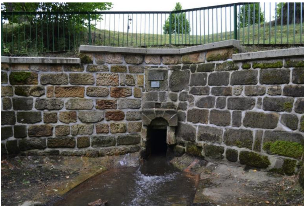
Obr. 4.65: Hamr na Jezeře, Hamerský rybník – vzdušní líc hráze s vyústěním spodní výpusti, datováno 1821, stav po novodobých úpravách zdiva. Foto Miroslav Kolka, 2017.
