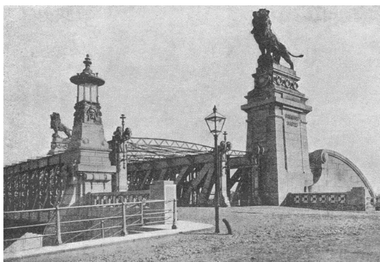
Obr. 3.15: Viedeň-Nussdorf (Rakousko), most nad zdymadlem. Zdymadlo včetně mostu a provozních budov z let 1894–1899 je po architektonické stránce dílem Otto Wagnera. (převzato z: Wagner, 1910).
