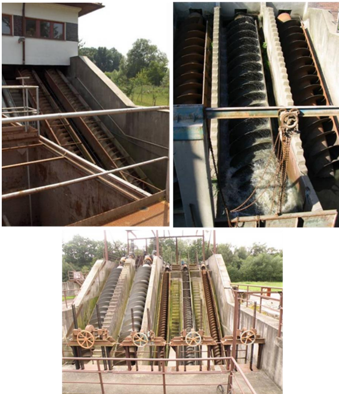
Obr. 4.242: Šneková čerpadla (převzato z: archiv VÚV).
