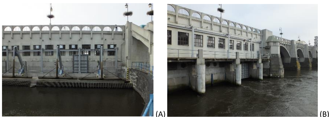
Obr. 4.141: MVE Kolín: (A) vtokový objekt (vlevo); (B) výtokový objekt. Foto VUT v Brně, FAST, 2015.
