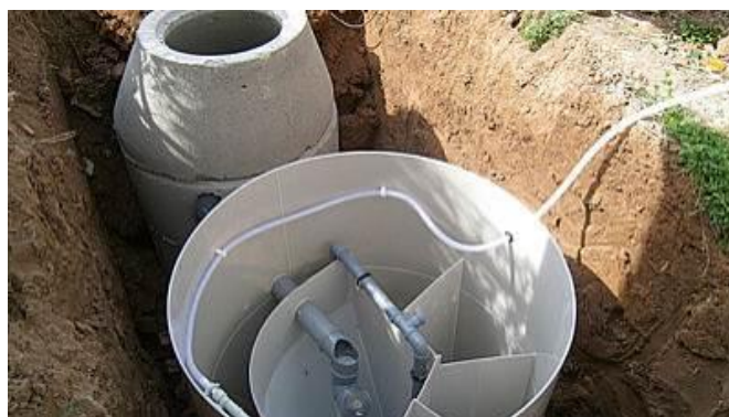
Obr. 4.257: Domovní čistírna připravená k osazení (převzato z: archiv USBF Technology).
