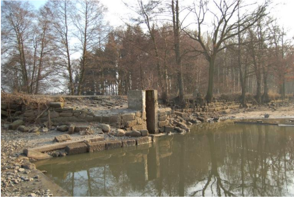
Obr. 4.55: Holany, rybník Jílovka – konstrukce hráze s opevněním návodního líce z pískovcového zdiva, partie opevnění ve vazbě na hlavní výpust a loviště. Foto Miroslav Kolka, 2018.
