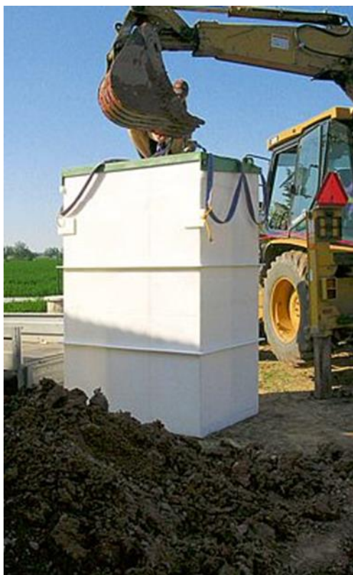
Obr. 4.257: Domovní čistírna připravená k osazení (převzato z: archiv USBF Technology).
