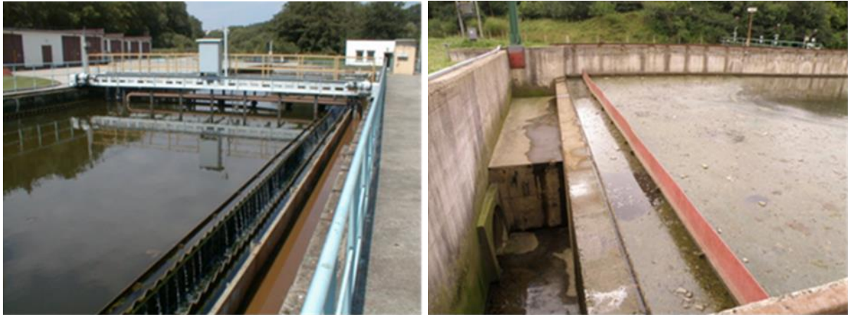
Obr. 4.243: Horizontální usazovací nádrž (převzato z: archiv VÚV).
