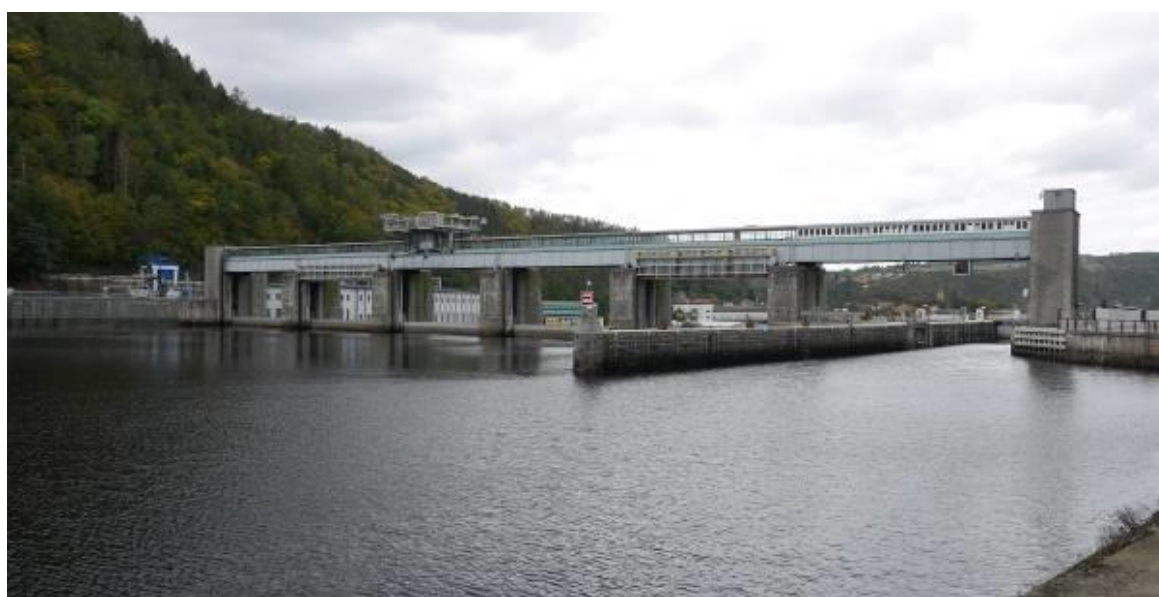
Obr. 4.35: VD Štěchovice (1937–1945) – tížná betonová hráz. Ukázka funkčního celku – přehrada + plavební komora + vodní elektrárna. Foto Michaela Ryšková, 2020.
