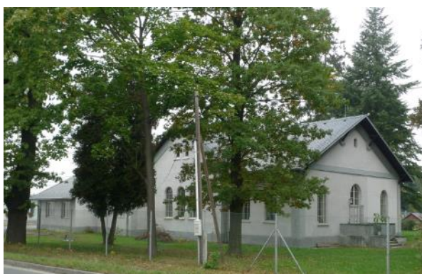
Obr. 4.194: Opava – areál vodárny v ulici Jaselská z roku 1875 s objektem původní parní strojovny. Foto Alena Borovcová.
