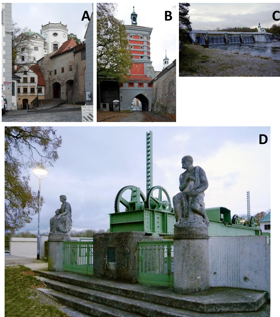
Obr. 3.2 Augsburg, vodohospodářský systém: (A–B) vodárenské věže u Červené brány, (C–D) jez Hochablass z let 1911–1912, foto Michaela Ryšková, 2019.
