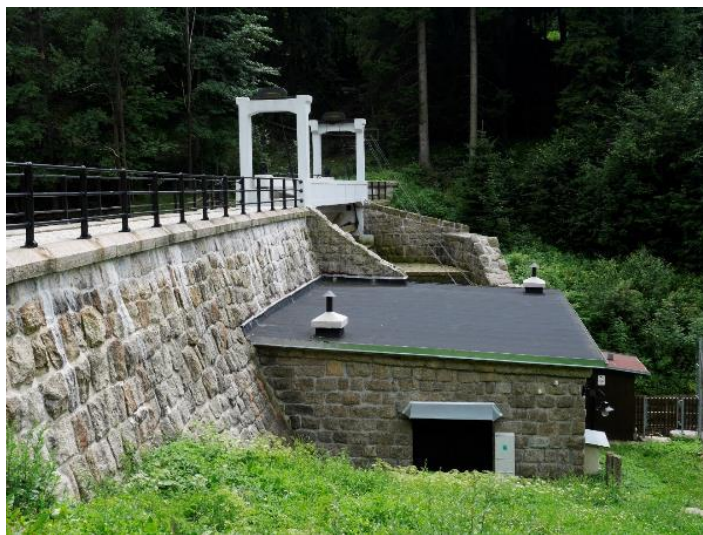
Obr. 4.132: MVE Rudolfov II: (A) návodní líc hráze se vtokovým objektem; (B) strojovna MVE. Foto Michaela Ryšková, 2021.
