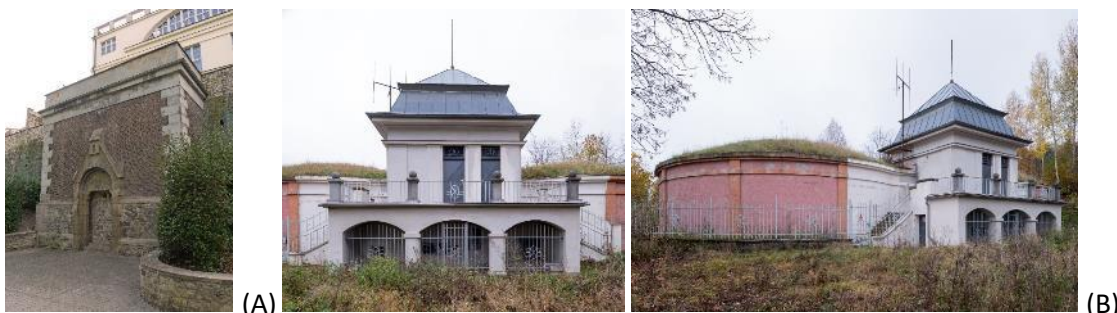
Obr. 4.215: Zemní vodojemy: (A) Louny, zemní vodojem Foto 2020; (B) Příbram, zemní vodojem Husa / U Husy, dokončený kolem roku 1930, jímá vodu z dolu Drkolnov. Foto Viktor Mácha, 2019.
