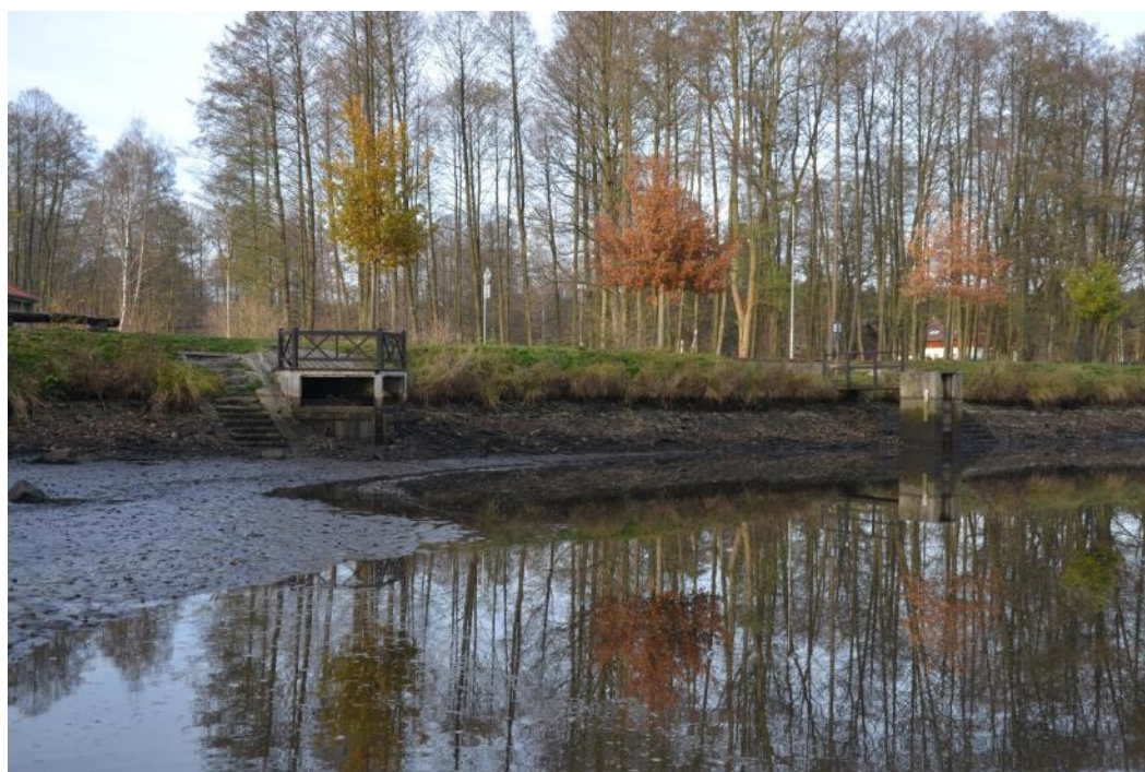
Obr. 4.52: Hradčany, Hradčanský rybník – přímá hráz s hlavní výpustí (vpravo) a odtokem do náhonu na zaniklý mlýn (vlevo), stav po vypuštění rybníka. Foto Miroslav Kolka, 2017.
