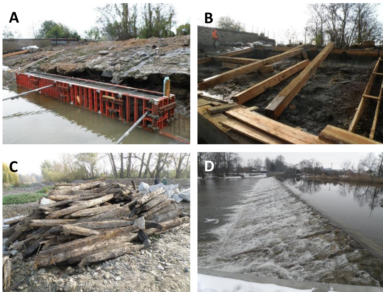
Obr. 5.5: Znojmo-Oblekovice – rekonstrukce jezu v Oblekovicích na řece Dyji: (A) Založení nové paty jezu, říjen 2018; (B) Výměna trámového rastru jezového tělesa, listopad 2018; (C) původní části dřevěné trámové konstrukce; (D) rekonstrukce dokončena, leden 2019. Foto Miriam Dzuráková, 2018-2019.
