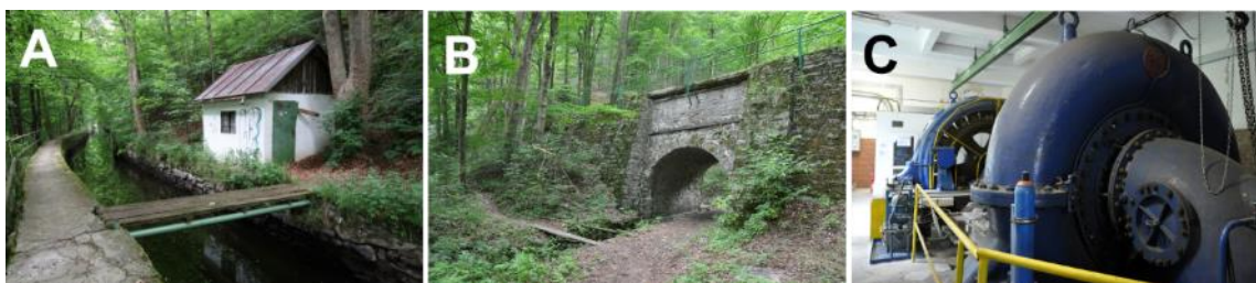
Obr. 4.183: Weissshuhnův náhon a vodní elektrárna papírny: (A) koryto horního náhonu se strážním domkem; (B) akvadukt v úrovni křížení s Kamenným potokem; (C) interiér strojovny vodní elektrárny s Francisovou turbínou a generátorem. Foto Radka Račoch, 2021 (A) a (B), Miriam Dzuráková, 2019 (C).
