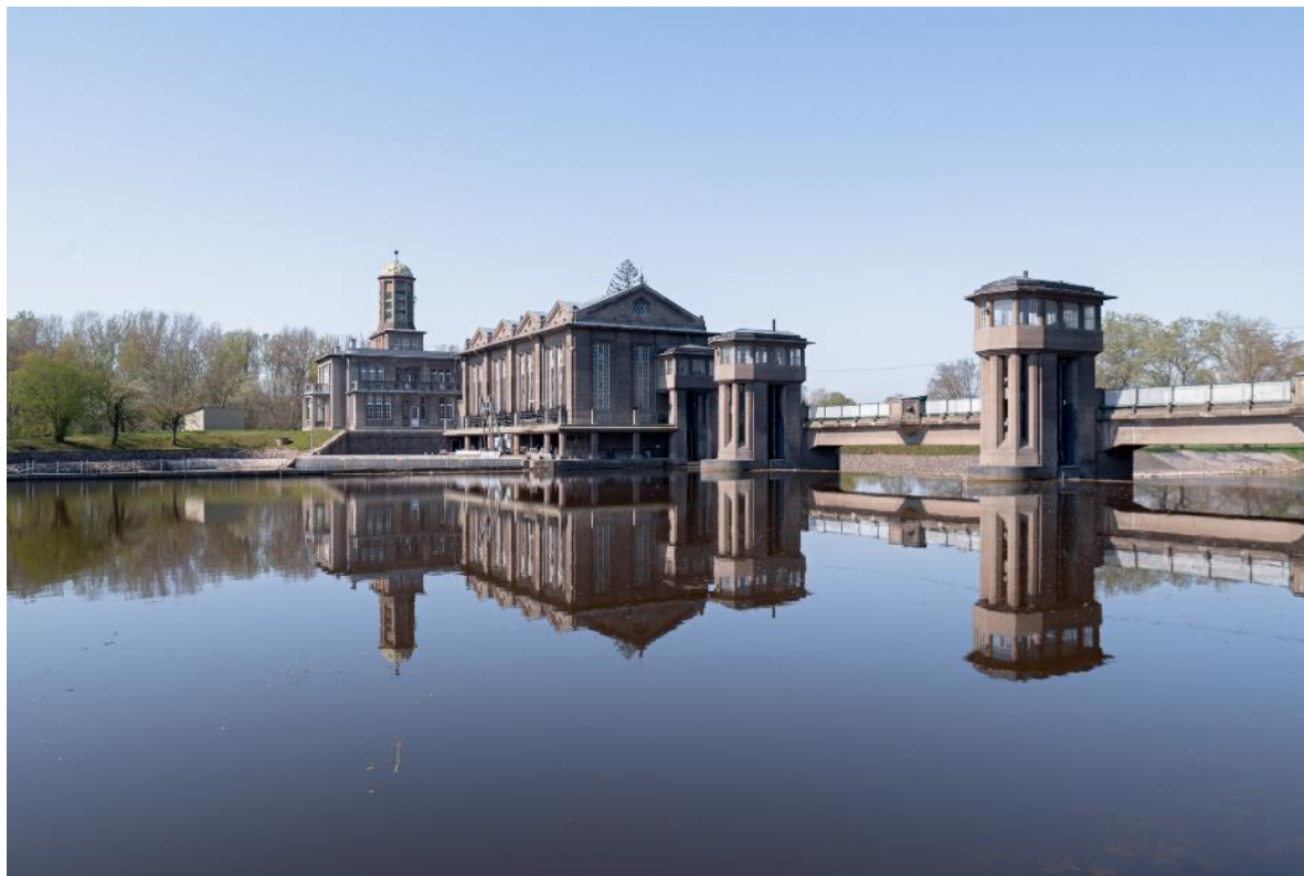
Obr. 3.17: Poděbrady, jez a vodní elektrárna, v jednotném architektonickém tvarosloví jsou dílem architekta Antonína Engela. Foto Viktor Mácha, 2019.
