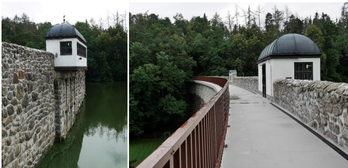
Obr. 5.25: Přehrada Jevišovice – objekt pro ovládání spodních výpustí. Foto Michaela Ryšková, 2020.
