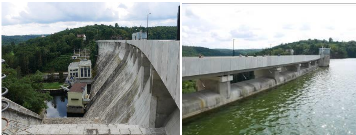
Obr. 4.14: Přeprada Vranov (1930–1934) – ukázka betonové hráže a korunového nehrazeného přelivu (vpravo). Foto Michaela Ryšková, 2020.
