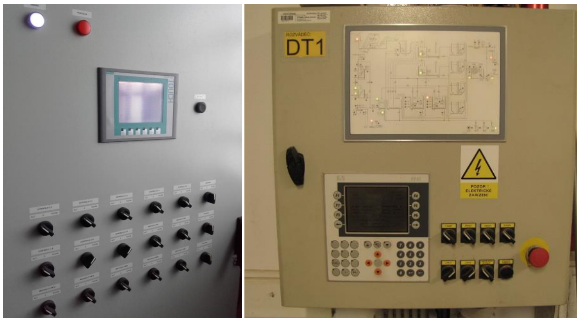
Obr. 5.29: Dnes již historická zařízení pro řízení provozu ČOV. Foto Miloš Rozkošný, 2021.
