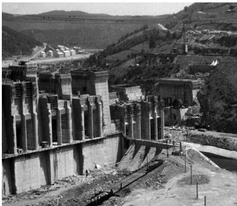
Obr. 4.144: VD Orlík – ve výstavbě, detail bloků s vtoky na VE. Foto archiv VUT v Brně, FAST.
