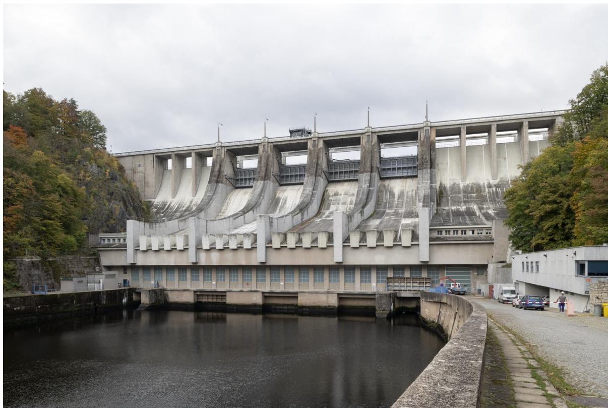
Obr. 4.41: Přehrada Slapy (1949–1957) – tížná betonová přehrada, korunový bezpečnostní přeliv o čtyřech polích hrazený zdvižným segmentem. Foto Viktor Mácha, 2021.
