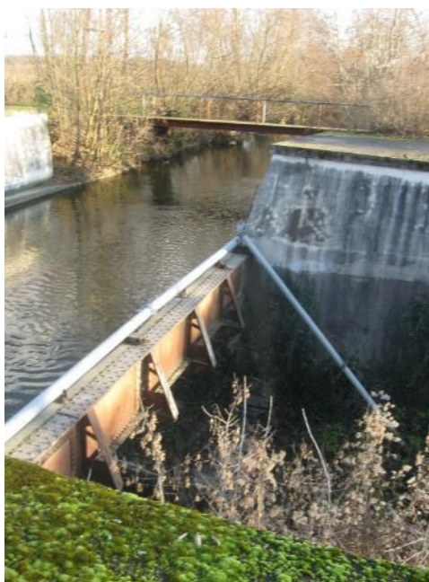
Obr. 4.93: Rakousko, Laa an der Thaya – železný akvadukt na náhonu z Dyje. Foto Milena Forejtníková, 2019.
