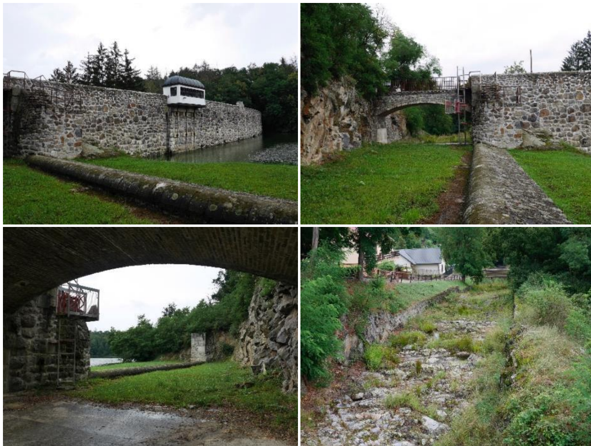
Obr. 4.28: Přehrada Jevišovice (1884–1896) – zděná tížná přehrada. Vlevo nahoře přelivná hrana nehrazeného bočního bezpečnostního přelivu, vpravo nahoře přelivná hrana a spadiště. Vlevo dole pohled do spadiště zpod mostu, vpravo dole skluz. Foto Michaela Ryšková, 2020.
