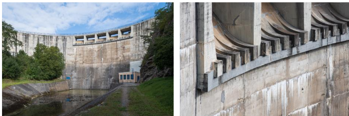
Obr. 3.13: Přehrada Vrchlice (1966–1970), rytmizovaný detail rozrážečů vody korunového přelivu kontrastuje s monumentální plochou vzdušného líce hráze. Foto Viktor Mácha, 2020.
