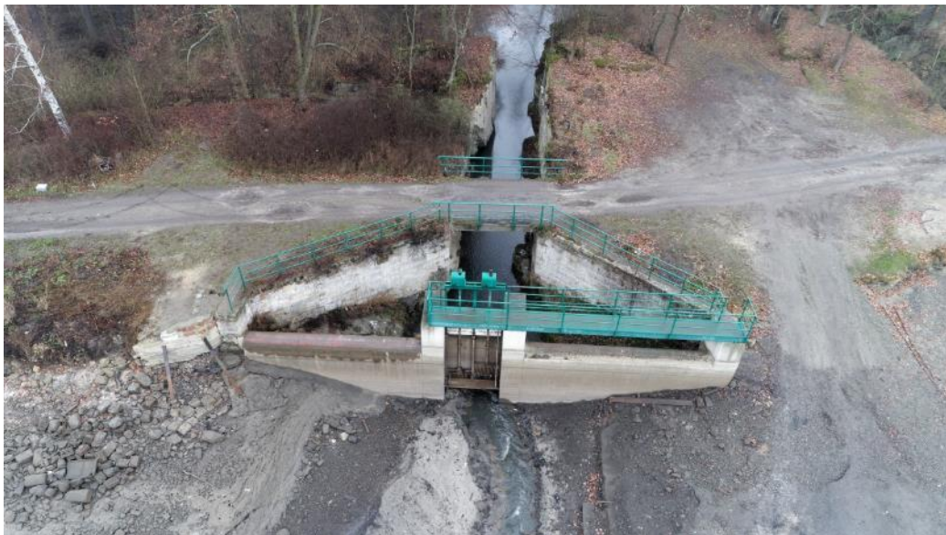
Obr. 4.56: Holany, Holanský rybník – hlavní výpust s odtokem do skalní pískovcové průrvy. Foto J. Vidman, 2018.
