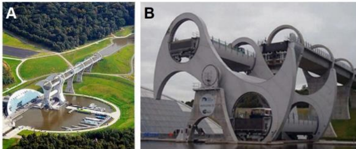
Obr. 4.82: Falkirk (velká Británie, Skotsko), rotační lodní zdvihadlo. Foto z propagačních materiálů, osobní archiv Mileny Forejtníkové.
