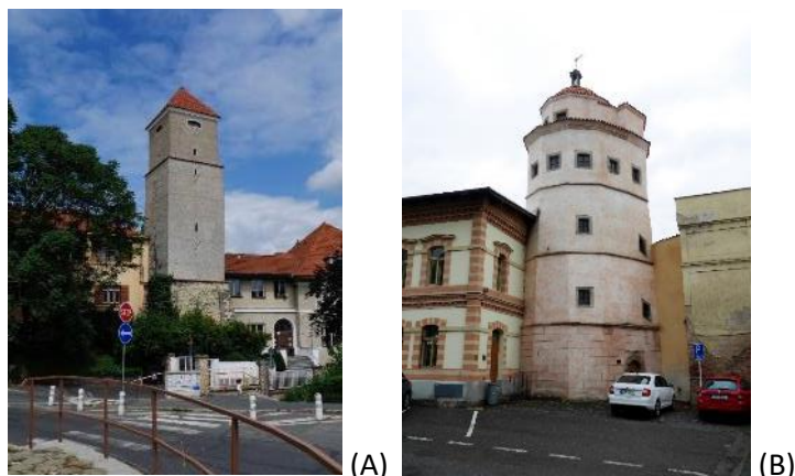
Obr. 4.190: Příklady vodárenských věží: (A) Mělník, renesanční vodárenská věž na Pražském předměstí, pocházející zřejmě ze 14. století, je volnou součástí městského středověkého opevnění. Do její nádrže čerpána užitková voda z potoka Pšovka. Svému účelu sloužila až do roku 1882 (Hlušíčková, 2002); (B) Nymburk, tzv. Turecká věž z konce 16. století, postavená na místě starší dřevěné věže. Foto Michaela Ryšková, 2021.
