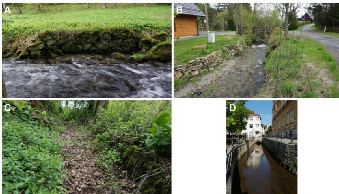
Obr. 4.91: Stavební materiál – kámen – Jeseníky Karlov, M. Morávka: (A) skládaný kámen, trvanlivost ověřená časem; (B) novější varianta skládaného kamene; (C) zaniklý kamenný náhon; Chrudim: (D) kamenné zděné stěny vodního kanálu v intravilánu. Foto David Honek, 2020.
