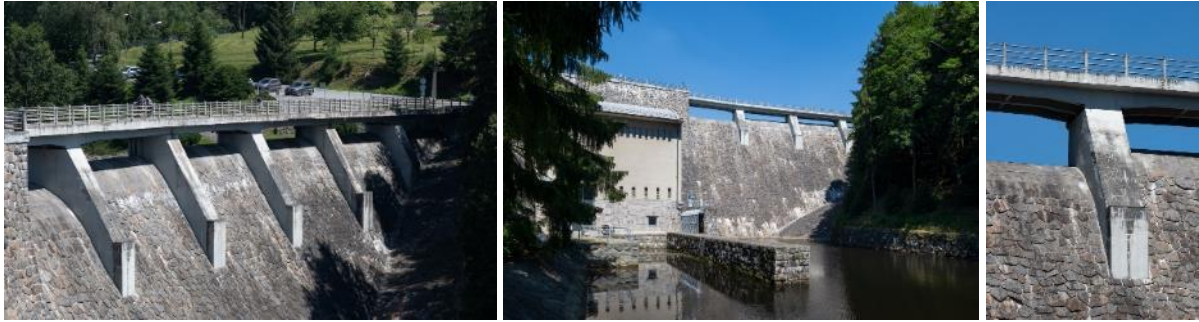
Obr. 4.26: Přehrada Pastviny (1933–1938) – zděná tížná přehrada. Poslední doposud vystavěná zděná hráz v ČR. Na obrázcích je nehrazený korunový přeliv se šesti poli s různou úrovní přelivné hrany. Voda je odvedena skluzem do vývaru, který je uzavřen stupňovitým železobetonovým prahem. Foto Viktor Mácha, 2020.
