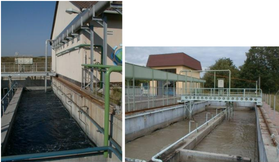
Obr. 4.241: Horizontální komorový lapák písku (převzato z: archiv VÚV).
