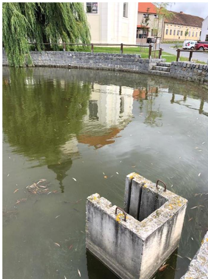
Obr. 4.61: Ostrov u Stříbra – návesní MVN s betonovým otevřeným dvojitým požerákem. Foto Renata Pavelková, 2021.
