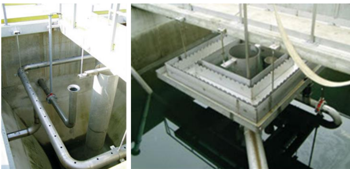
Obr. 4.246: Vertikální usazovací nádrž (převzato z: VH-Z-DIS, 2021)
