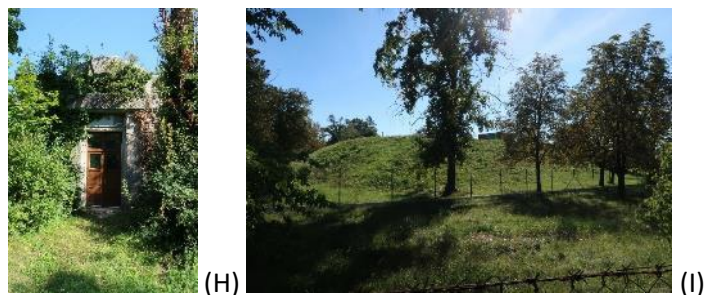
Obr. 4.231: I. březovský vodovod – vybrané části: (A) strojní zařízení studny; (B) šoupátkový domeček Blansko; (C) odlehčovací věž Letovice; (D) zemní vodojem Březová nad Svitavou; (E) potrubí; (F) šoupátková komora Březová nad Svitavou; (G) ovládací zařízení šoupátkové komory; (H) vstup do zemního vodojemu Holé Hory II a (I) zemní vodojem Holé Hory II. Foto David Honek, Miriam Dzuráková, 2019 a 2020.
