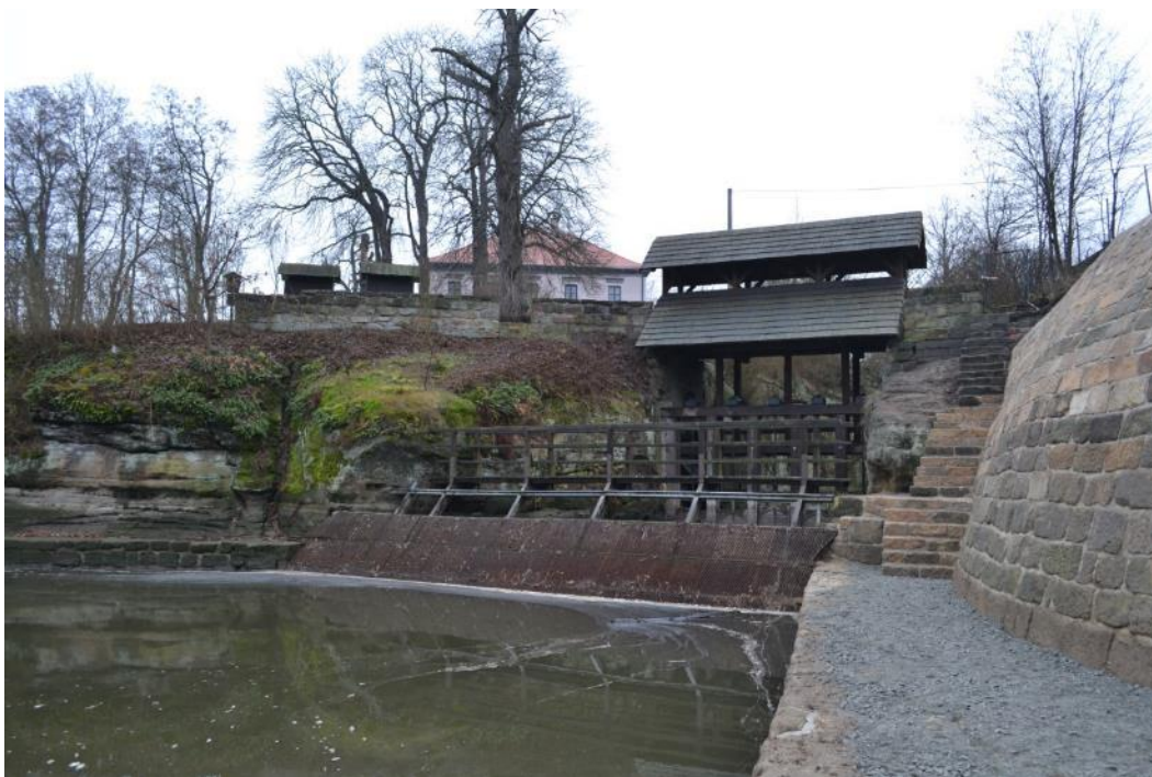
Obr. 4.63: Zahrádky, Novozámecký rybník – výpusť s otevřeným odpadem a masivní stavidlovou trámovou konstrukcí s pochozí lávkou, stříškou a česly, veškeré konstrukce jsou osazené do dráží ve skalních pískovcových stěnách. Foto Miroslav Kolka, 2015.
