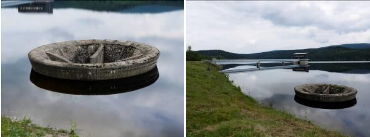
Obr. 4.30: Přehrada Josefův Důl (1976–1982) – zemní sypaná hráz, šachtový bezpečnostní přeliv. Foto Michaela Ryšková, 2020.
