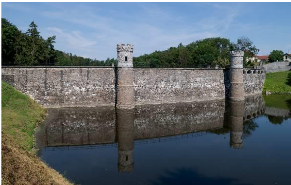
Obr. 4.9: Přehrada Pařížov (1909–1913) – manipulační věže na návodní straně hráze pro ovládání revizních šoupátkových uzávěrů. Foto Viktor Mácha, 2020.
