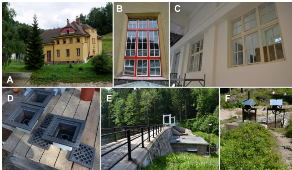
Obr. 5.8: Rudolfov – rekonstrukce vodního díla a elektrárny: (A) fasáda po obnově; (B) Nové jednoduché vnější okenní výplně ve strojovně s fasádou před obnovou; (C) vnitřní okenní a dveřní výplně byly zachovány původní a repasovány; (D) obnova nefunkčního systému odvodnění hráze vyrovnávací nádrže s repasí a grafitovými nátěry odvodňovacích prvků; (E) hráz po dokončení nátěrů zábradlí s budovou MVE II v pravé části snímku; (F) obnova všech jímacích objektů na přivaděči. Foto Petr Nedomlel, 2008 (A), 2012 (B) a (C).
