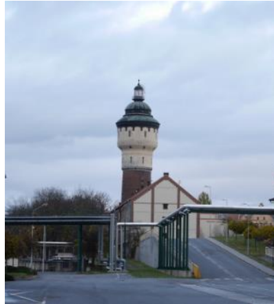
Obr. 4.196: Plzeň – věžový vodojem v areálu pivovaru Prazdroj z let 1905–1907 byl součástí vodovodu Měšťanského pivovaru. Prováděcí projekt zpracoval ing. Spalek a stavitel Hucl. Dvě železné nádrže byly usazeny nad sebou, jedna na pramenitou a druhá na říční vodu. Systém vodárny sestával vedle věžového vodojemu z elektrárny pohánějící říční čerpací stanici, objektu hrubého filtru, odželezovací stanice a pračky písku a vodárenské budovy u studny na Roudné. Foto Alena Borovcová, 2020.
