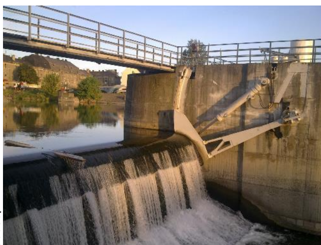
Obr. 4.109: Segmentový jez. Schéma Radka Račoch a Michaela Mrvová, 2021 (upraveno dle: Gabriel a kol., 1989). Vpravo segmentový jez v Přerově. Foto Archiv VUT, 2019.
