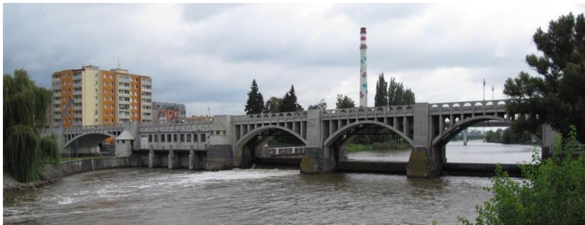
Obr. 4.131: MVE Kolín – pohled z prostoru podjezí na strojovnu a výtokovou část MVE (vlevo) a 3 pole válcového jezu (vpravo). Foto VUT v Brně, FAST, 2014.
