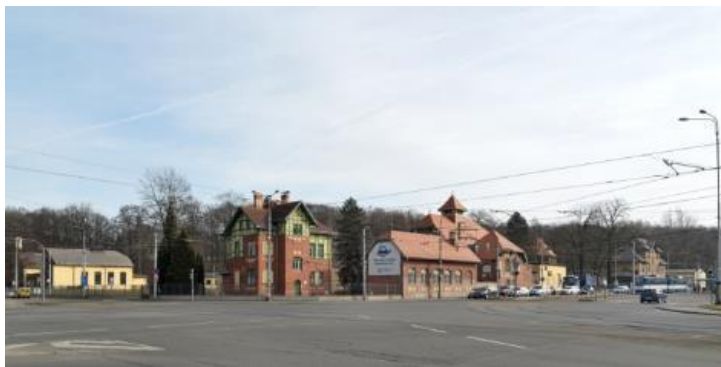
Obr. 5.1: Ostrava – úpravna vody, celkový pohled. Foto Roman Polášek, 2019.
