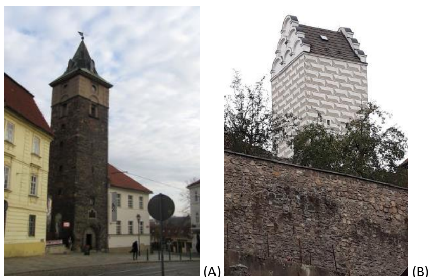
Obr. 3.9: Vodárenské věže: (A) Plzeň, pozdně gotický věžový vodojem z kamenného zdiva, zmiňovaný poprvé roku 1532. Klasicistní objekt čerpací stanice (vpravo) byl postaven z kamene ze zbořené Pražské brány. Gotizující tvar střechy věže pochází zřejmě z roku 1845, kdy byla zvýšena při přestavbě provedené stavitelem Kristiánem Lexou. V roce 1843 byla v nejvyšším patře měděná nádrž o objemu 2,7 m 3 . Čerpací stanice byla vybavena okovaným vodním kolem a tříválcovou pumpou a čerpala vodu z řeky. Vstupní portál osazený
