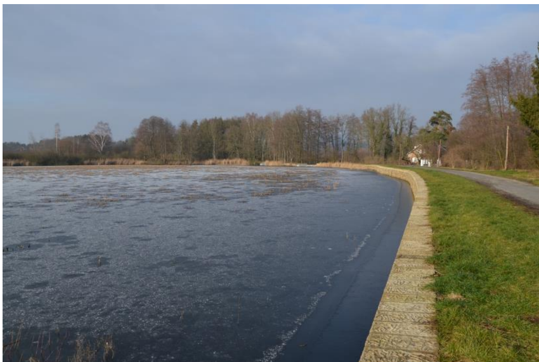
Obr. 4.51: Holany, Holanský rybník – vydutý tvar hráze s obnovenou návodní zdí z pískovcových kvádrů. Foto Miroslav Kolka, 2018.
