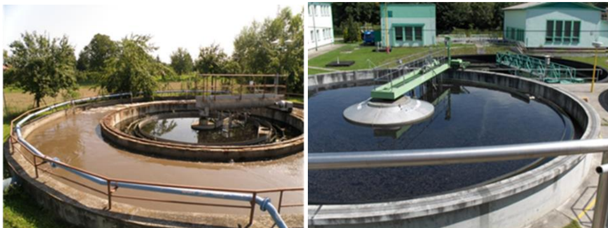
Obr. 4.253: Dosazovací nádrž (převzato z: archiv VÚV).
