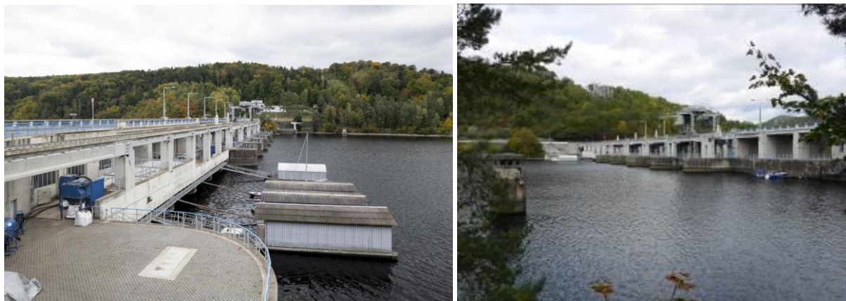
Obr. 4.42: Přehrada Slapy (1949–1957) – tížná betonová přehrada, pohled na návodní líc. Foto Viktor Mácha, 2021 a Michaela Ryšková, 2020.
