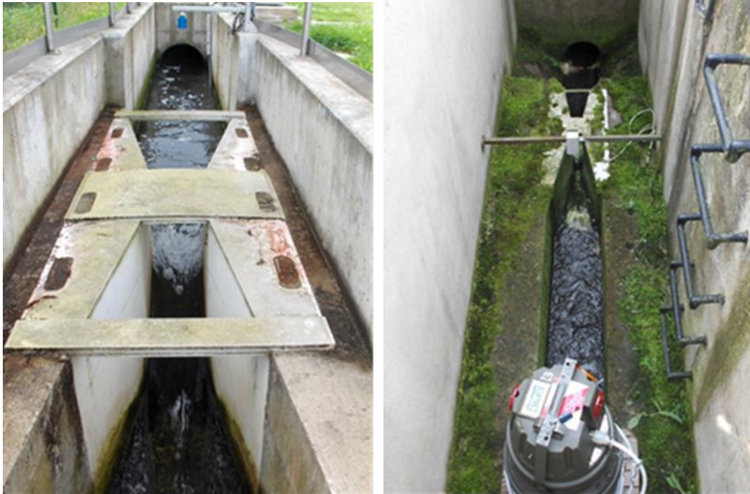
Obr. 4.255: Parshallův žlab (převzato z: archiv VÚV).
