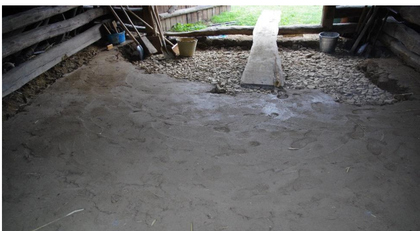
Obr. 8: Pokládka hliněné mazaniny na ztuhnutou vrstvu hrubého kameniva, celkový pohled.
