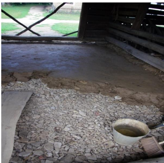
Obr. 9: Pokládka hliněné mazaniny na ztuhnutou vrstvu hrubého kameniva, celkový pohled.
