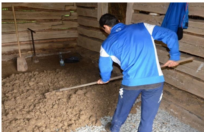
Obr. 12: Mlat zhotovený „suchou cestou“- srovnání výšky hliněného těsta hráběmi před hutněním.
