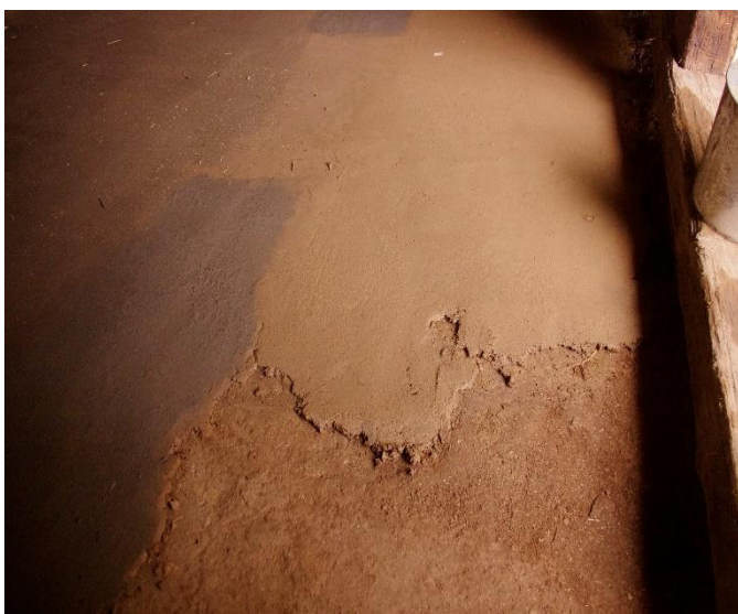
Obr. 16: Plocha mlatu s nanesenou stěrkou a zatírací směsí (vlevo).
