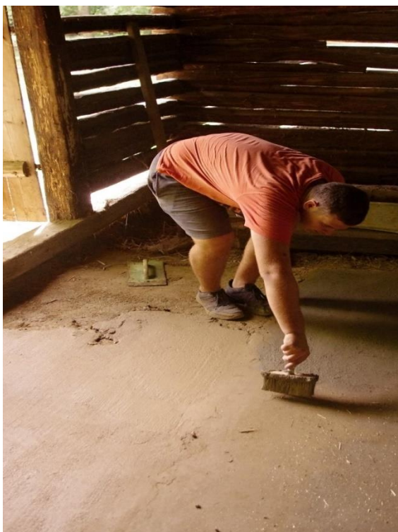
Obr. 15: Zatírání mírně zavadlé stěrkové vrstvy
