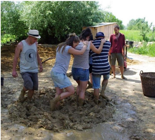
Obr. 3: Zpracování hliněného těsta pomocí vyšlapávání.
