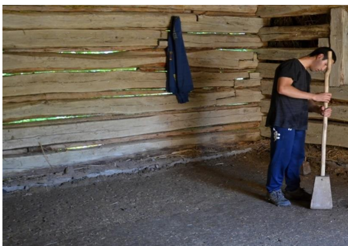
Obr. 13: Ruční hutnění mlatu zhotoveného „suchou cestou“.
