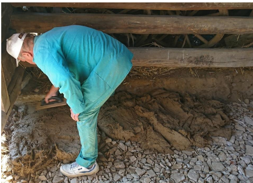
Obr. 6: Pokládka hliněné mazaniny.
