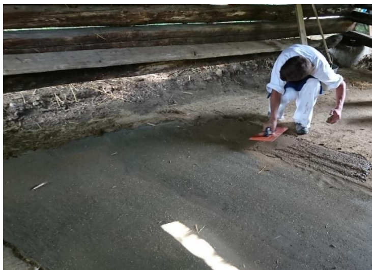
Obr. 14: Aplikace stěrky v tloušťce 10 až 30 mm.
