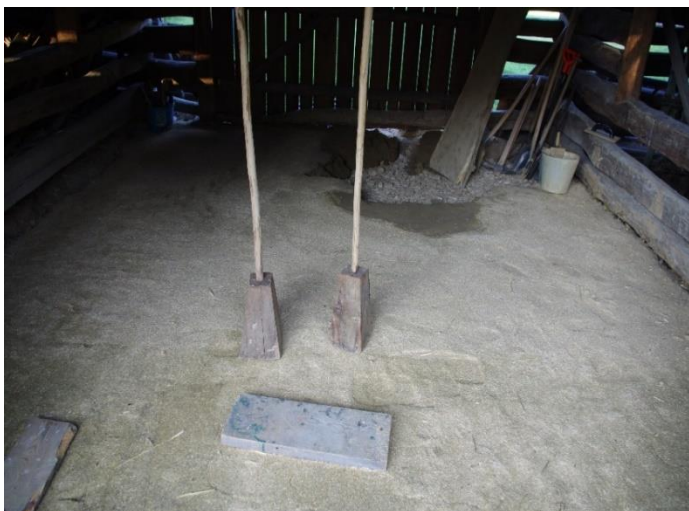
Obr. 10: Postupné hutnění částečně zavadlé hliněné mazaniny v plastickém stavu.
