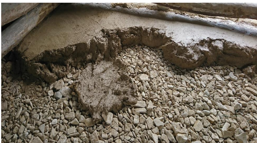
Obr. 7: Pokládka hliněné mazaniny.
