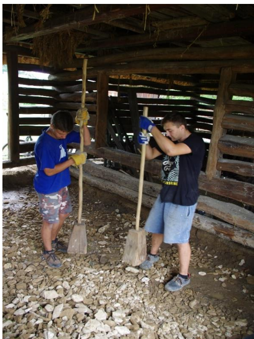
Obr. 5: Zatloukání a hutnění valounů pěchy do vlhkého podloží.
