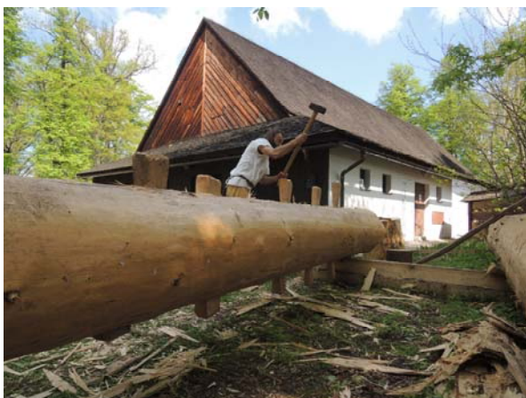
Obr. 22 Postupné zatlukání klínů při štípání
