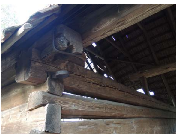
Obr. 13 Detail točnice vrat na jižní straně stodoly
