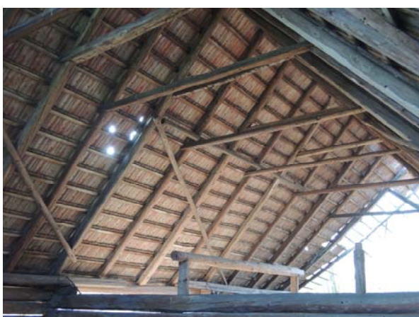
Obr. 12 Celkový pohled do krovu od severovýchodu
