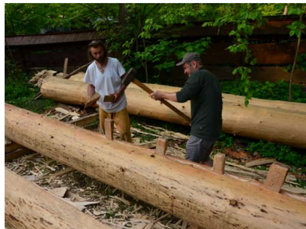
Obr. 23 Vkládání klínů do připravených dlabů
