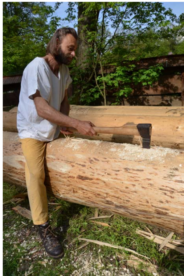
Obr. 21 Dlabání lůžka pro vkládání klínu
