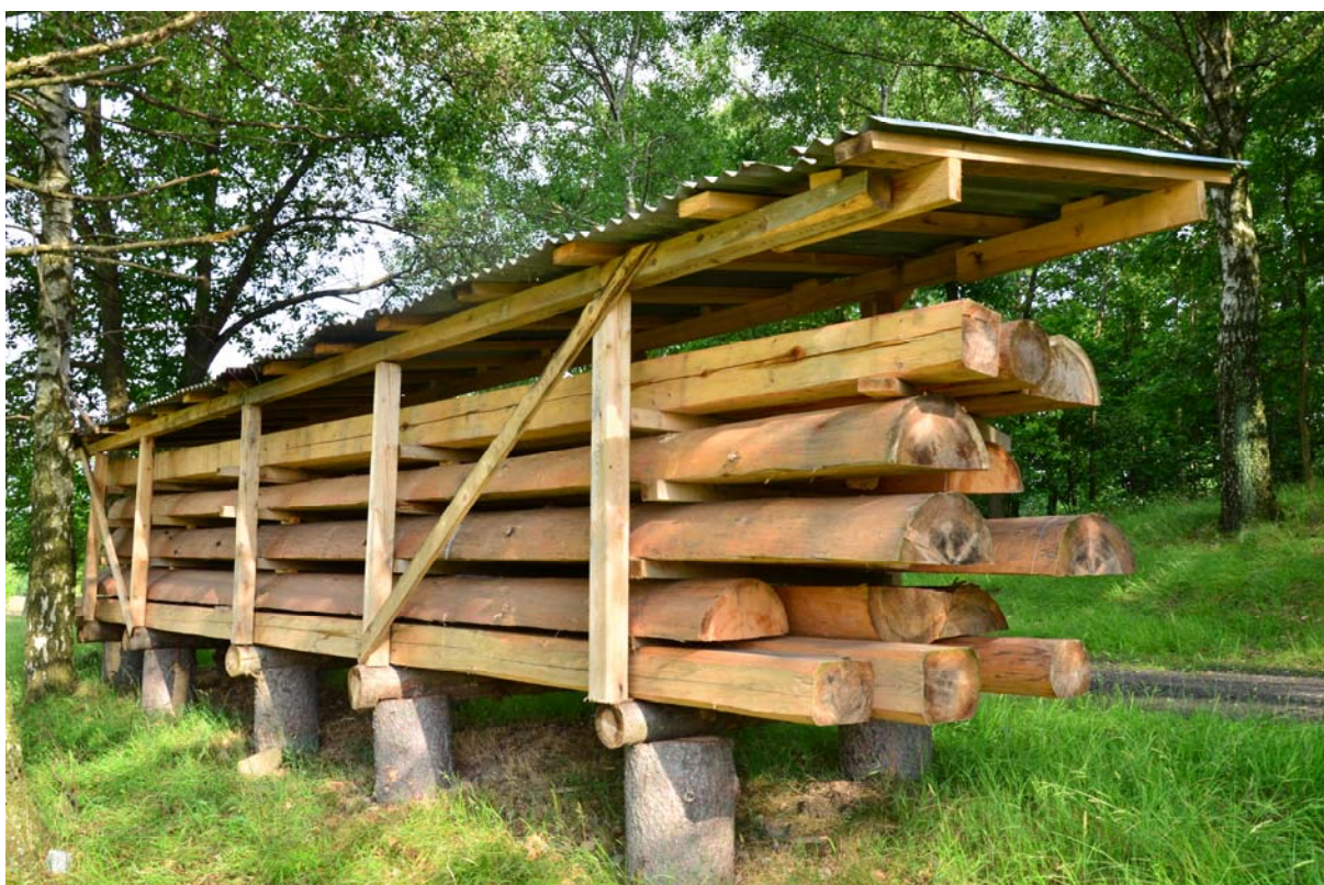
Obr. 29 Uskladnění finálně opracovaných půlkulatých srubnic v zastřešené hráni
