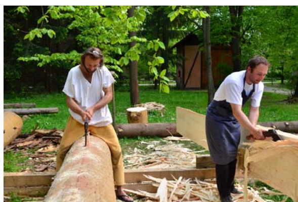
Obr. 27 Licování vnitřní plochy a příprava další kulatiny ke štípání
