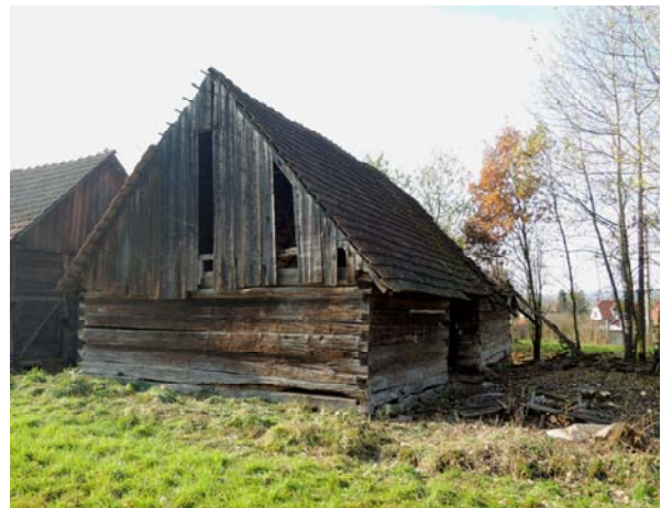
Obr. 3 Severovýchodní pohled na stodolu
