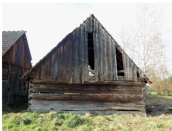
Obr. 11 Východní stěna východní části stodoly
