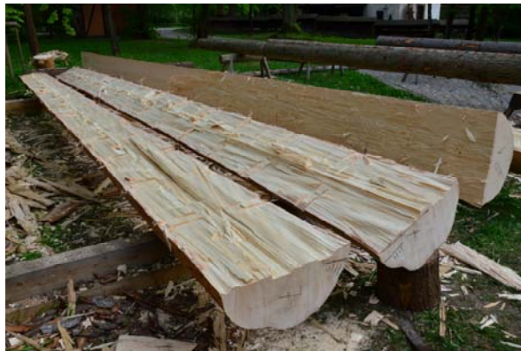
Obr. 1 Kulatina po rozštípnutí
