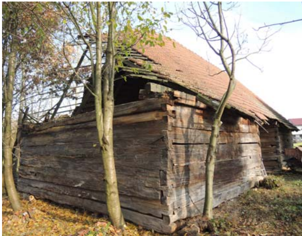
Obr. 2 Jihozápadní pohled na stodolu
