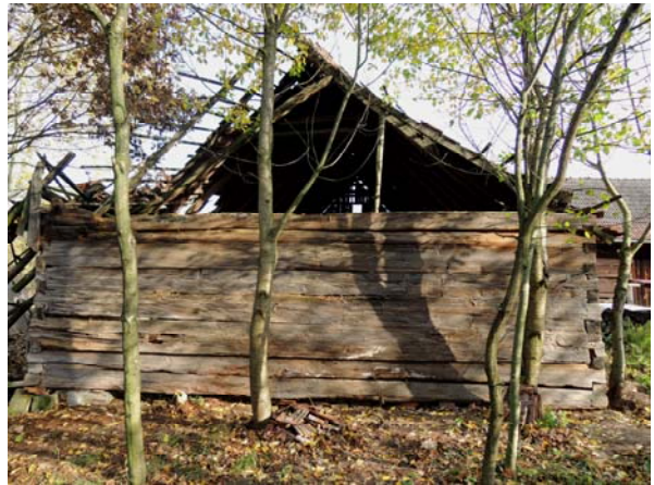
Obr. 5 Západní stěna západní části stodoly
