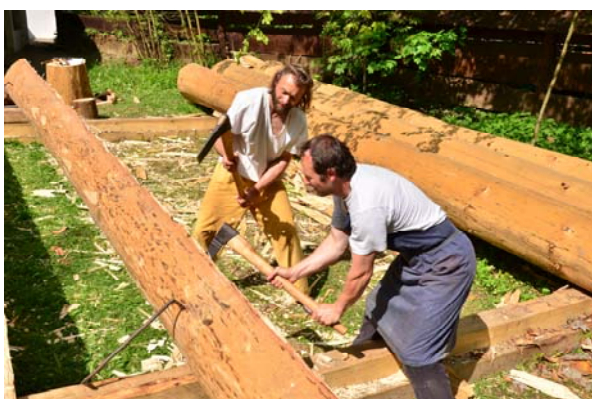
Obr. 26 Vrubování vnitřní plochy po štípání
