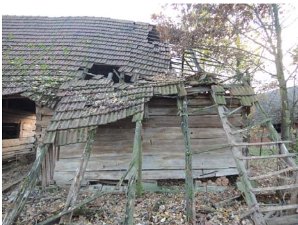
Obr. 6 Severní stěna západní části stodoly
