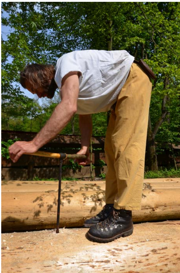
Obr. 20 Vrtání otvorů pro vedení dlabu
