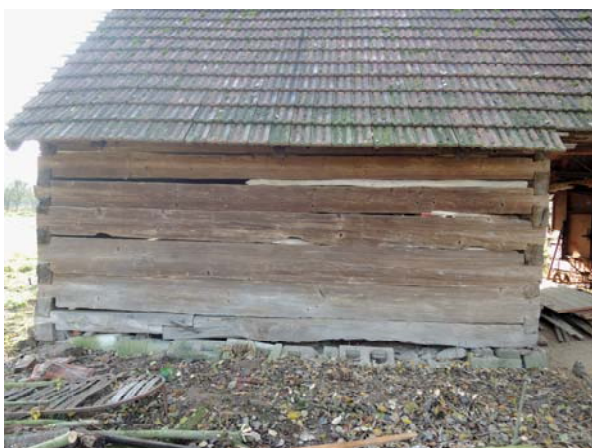
Obr. 10 Severní stěna východní části stodoly
