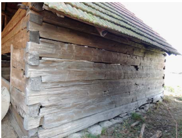
Obr. 8 Jižní stěna východní části stodoly
