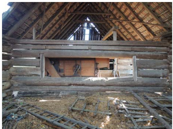
Obr. 7 Východní stěna západní části stodoly
