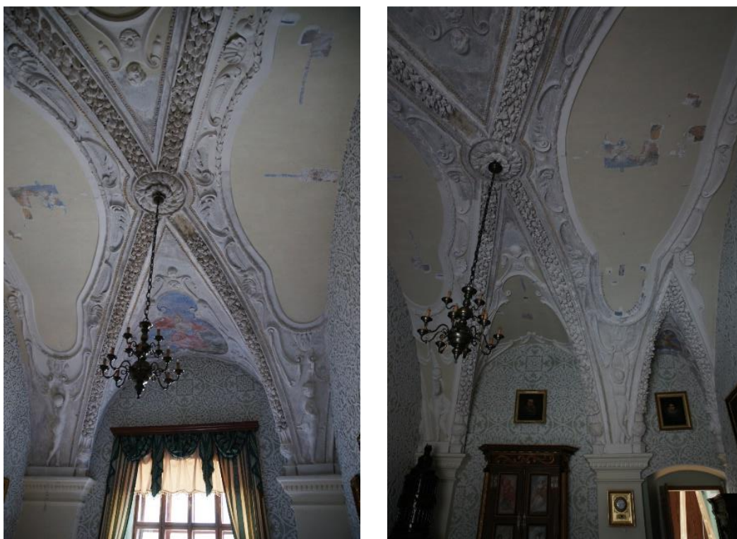
Obrázek 1: Fragment štukové výzdoby původního tzv. Tencalova sálu, po stavební úpravě prostor jídelny. Na snímku jsou vidět různé fáze průzkumu a restaurování nástropních maleb od Giacoma Tencally, které jsou rámovány bohatou štukovou výzdobou z dílny Ticinských štukatérů Inozenca a Giovanni Bartolomea Comety. Zelenobílá štuková arabeska na stěnách pochází ze stavební úpravy provedené v 19. století.
