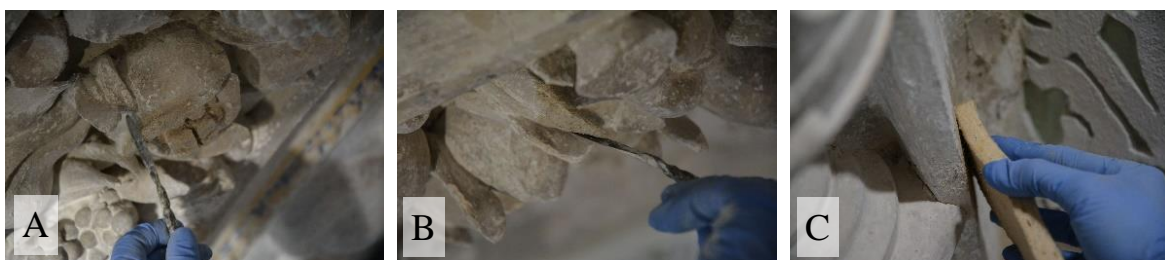
Obrázek 24: Maltové a štukové doplňky. Ukázka z povrchového doplnění poškozeného ovoce (A), modelace chybějící špičky lístku (B) a úprava širší trhliny v maltovém žeburu (C).
