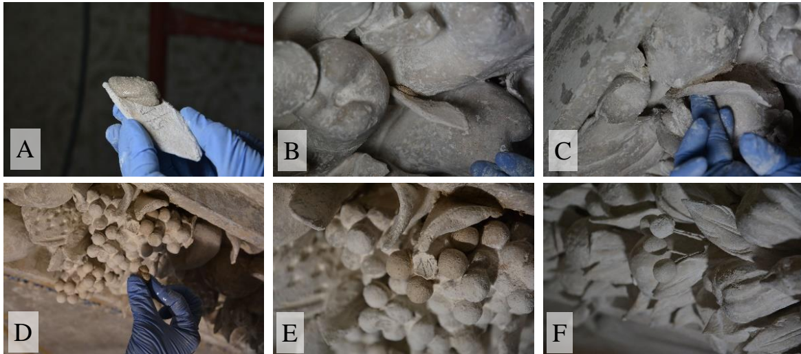
Obrázek 23: Osazování repliky drobných štukových doplňků. Ukázka z lepení lístků (A–C), doplňování kuliček do hroznu vína (D-E) a třešní (F).
