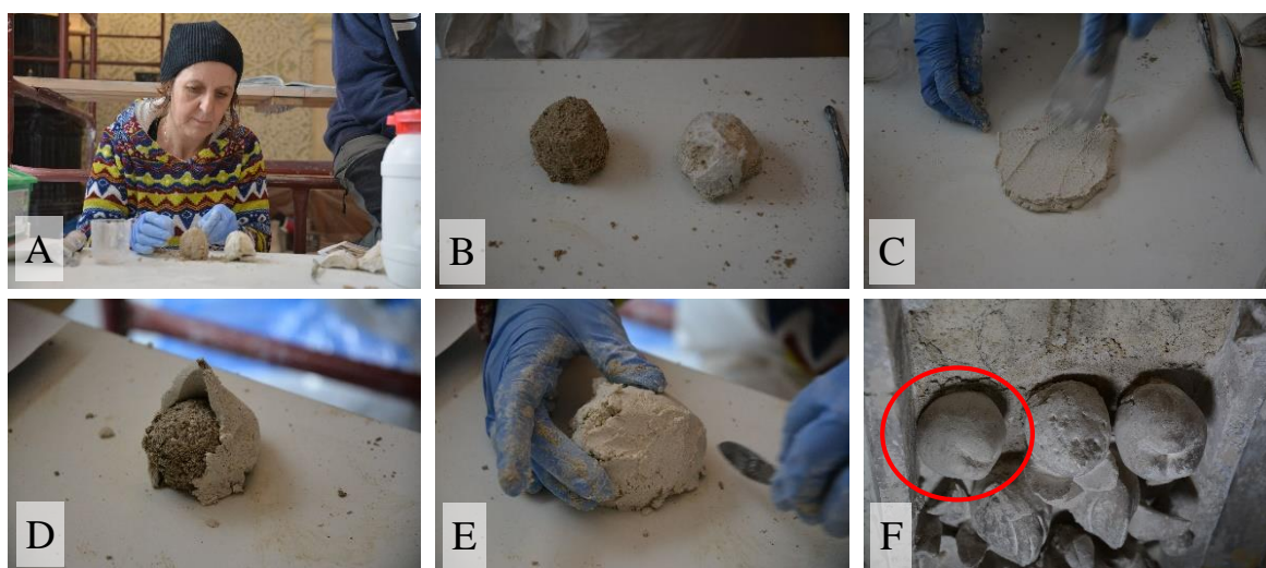
Obrázek 20: Výroba repliky. Výroba jádra (A, B), příprava štukové vrstvy (C) a její nanесení na jádro (D). Modelace tvaru pomocí špachtle (E) a přilepení na plánované místo (F).
