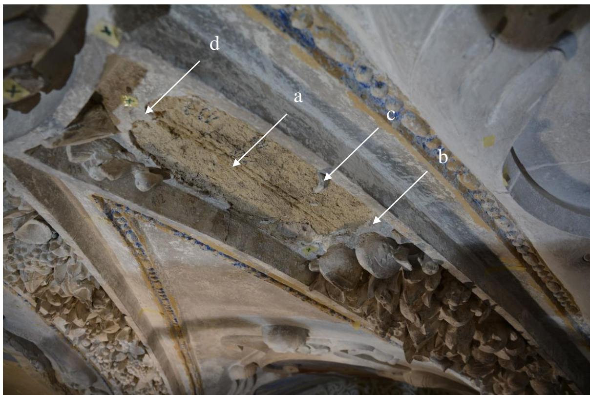
Obrázek 5: Detail štukového žebra u vrcholu lunety napojeného na kruhový lem okolo středové růžice. Na snímku je zachycen stav před zpětným osazením transferovaného ovoce. Na maltovém podkladu ( a ) jsou zbytky sádro-vápenné hrubé lepicí malty ( b ), která ho plošně pokryla. Menší tvary byly připevněny ke stranám žeber popř. větších tvarů jemnou lepicí maltou ( c ). Nejvýše osazený tvar byl osazen na kotvící hřeb v místě ( d ).
