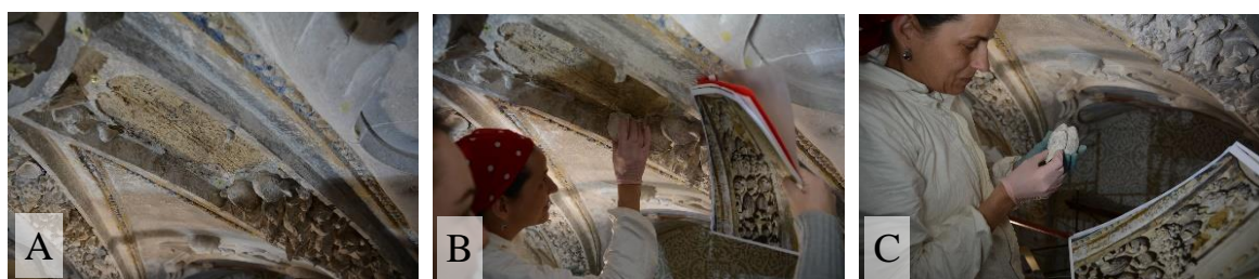
Obrázek 18: Příprava na zpětné osazení transferovaných tvarů. Kontrola podkladu (A), zkouška umístění jednotlivých tvarů dle fotodokumentace a označení (B, C).
