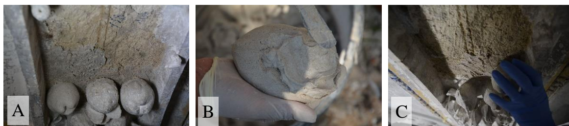
Obrázek 19: Lepení transferů. Nanesení lepicí malty na podklad (A) a na podstavu zpětně osazovaného ovoce (B). Lepený tvar lze přitlačit a udržet ve stabilní poloze rukou (C).
