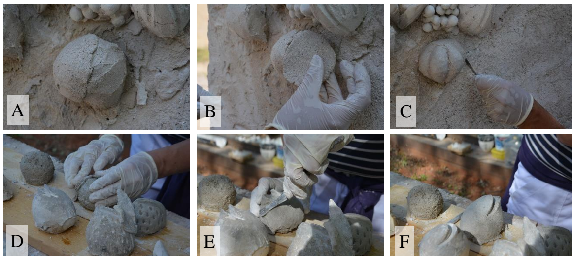
Obrázek 12: Ukázky postupu při modelaci ovocných tvarů z ruky na klenbě (A-C) a na stole (D-F).
