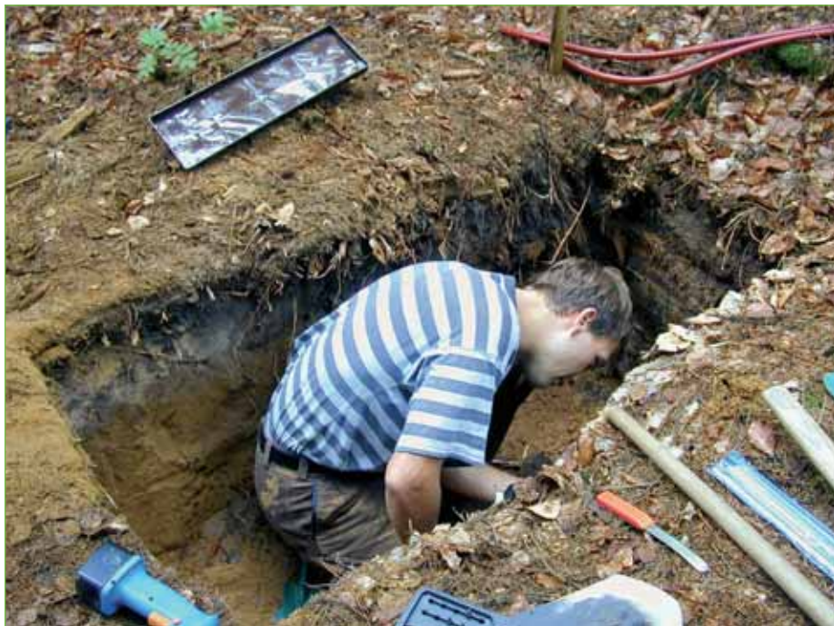
Obr. 5.2.5.5 Instalace lyzimetrů Installation of lysimeters
