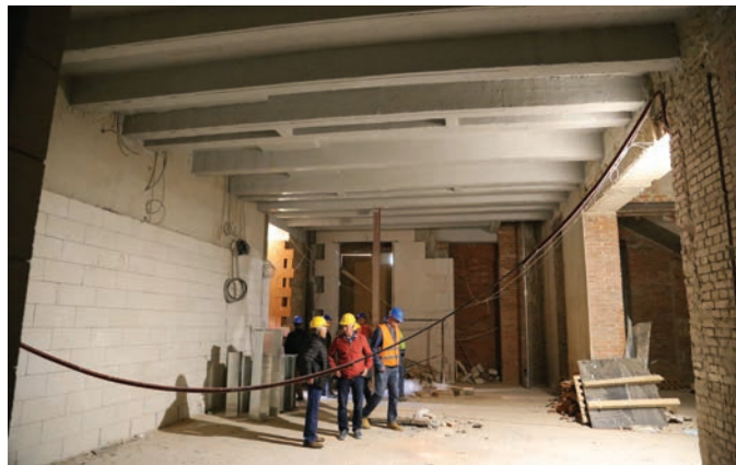
Rekonstrukce nového sídla PNP v Praze-Bubenci, interiér 2. nadzemního patra.
