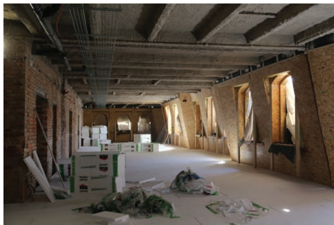
Rekonstrukce nového sídla PNP v Praze-Bubenci, interiér 3. nadzemního patra.
