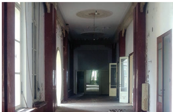
Rekonstrukce budoucího sídla PNP v Petschkově vile, stav krátce po zahájení prací
