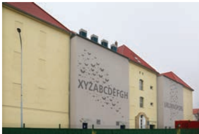
Centrální depozitář v Litoměřicích, budova SO.021 – pohled zepředu
