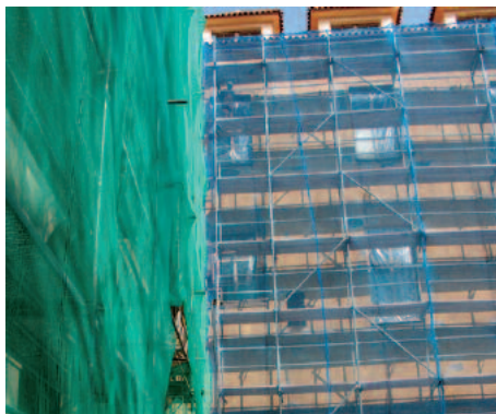
rekonstrukce dvorní fasády duben 2005
