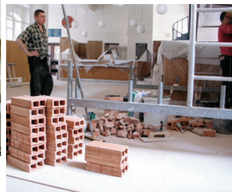
oprava stoupačky v hale služeb 25. - 28. 5. 2004
