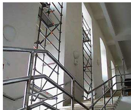
rekonstrukce STK – oprava oken srpen 2001
