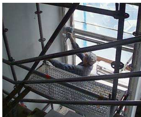
rekonstrukce STK – oprava oken srpen 2001
