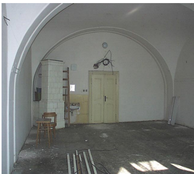
Obr. 8 Kanceláře odboru 3 před rekonstrukcí (místnost s balkonem, 1. patro)
