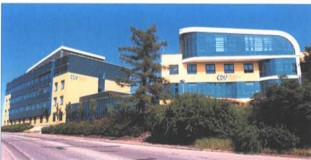
Obr. 1: Budova CDV na ulici Lišeňská a Dopravní VaV centrum.
