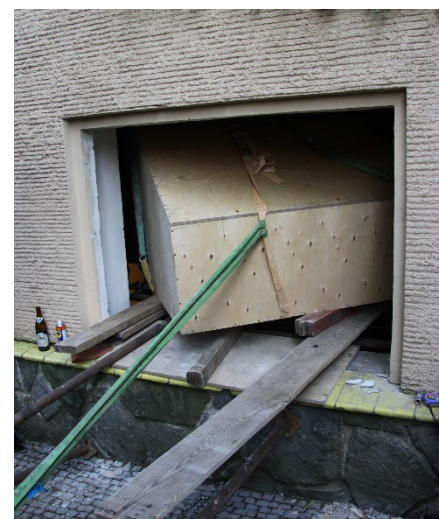
Obr. 17 Manipulace se zabaleným dílem v prostoru sklepa, naklonění z důvodu průchodu dveřními otvory
