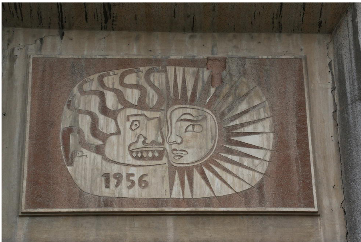
Obr. 7: Brno, Venhudova ulice. Sgrafito s datací, stav před restaurováním
