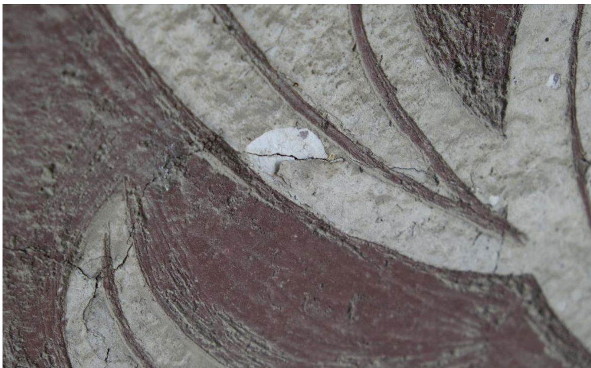
Obr. 3: Brno, MŠ Tučkova. Detail stavu před restaurováním – odlupování vrstveného nátěru intonaca bianca
