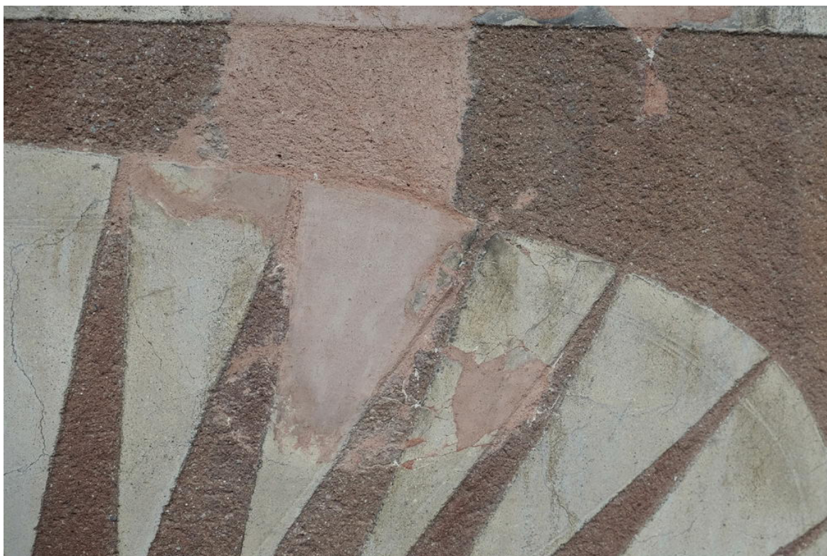
Obr. 18: Brno, Venhudova ulice. Vytmelený defekt po vytvrdnutí tmelu a povrchové úpravě (kletování a vyškrabání chybějící části motivu)
