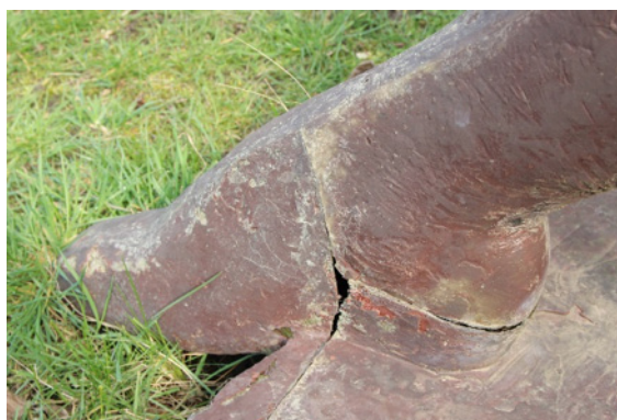
Obr. 9: Praskliny mezi spojovanými díly
