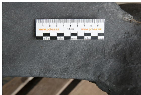
Obr. 6: Vlasové praskliny v povrchové vrstvě laminátu
