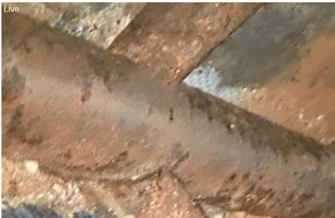
Obr. 3: Snímek stavu ocelové nosné konstrukce sochy „Rychlost“ od Jiřího Nováka pořízený endoskopem
