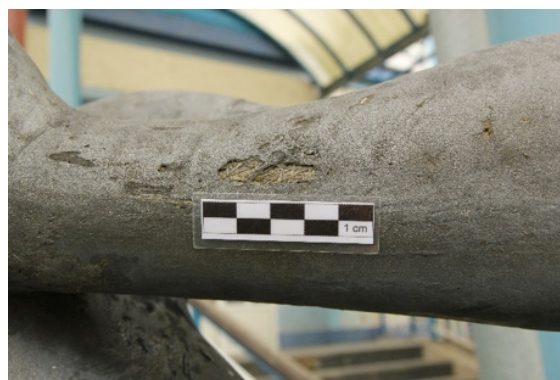
Obr. 10: Chybějící část povrchové vrstvy
