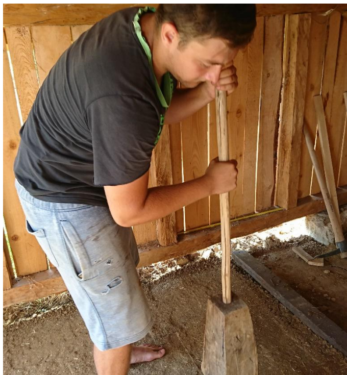
Obr. 13.: Hutnění těžkým dřevěným pěchem
