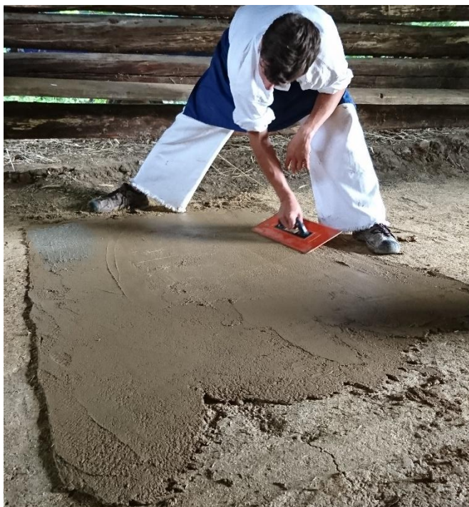
Obr. 14.: Aplikace stěrky v tloušťce 2 – 10 mm
