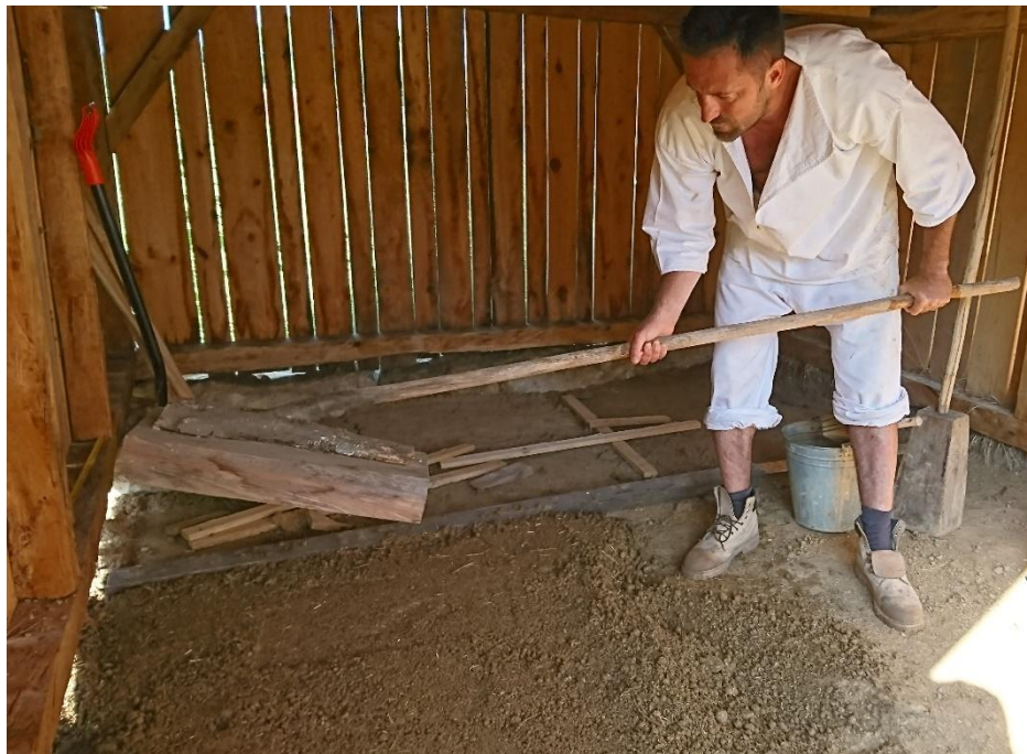
Obr. 12: Princip prvního hutnění plochým pěchem
