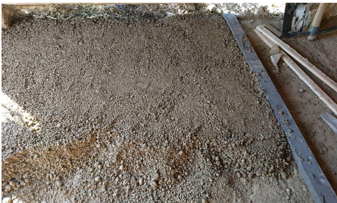
Obr. č. 10: Vytvoření pásu pro následné hutnění
