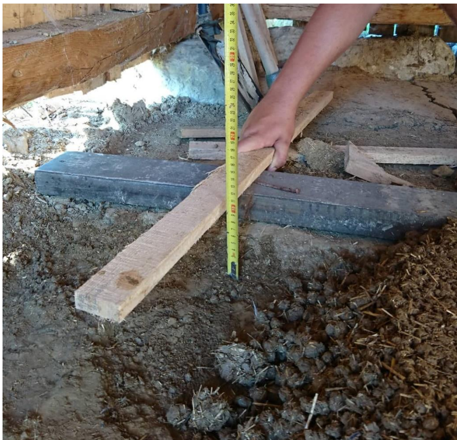
Obr. 8: Ustanovení výšky hliněné mazaniny, cca 10 cm
