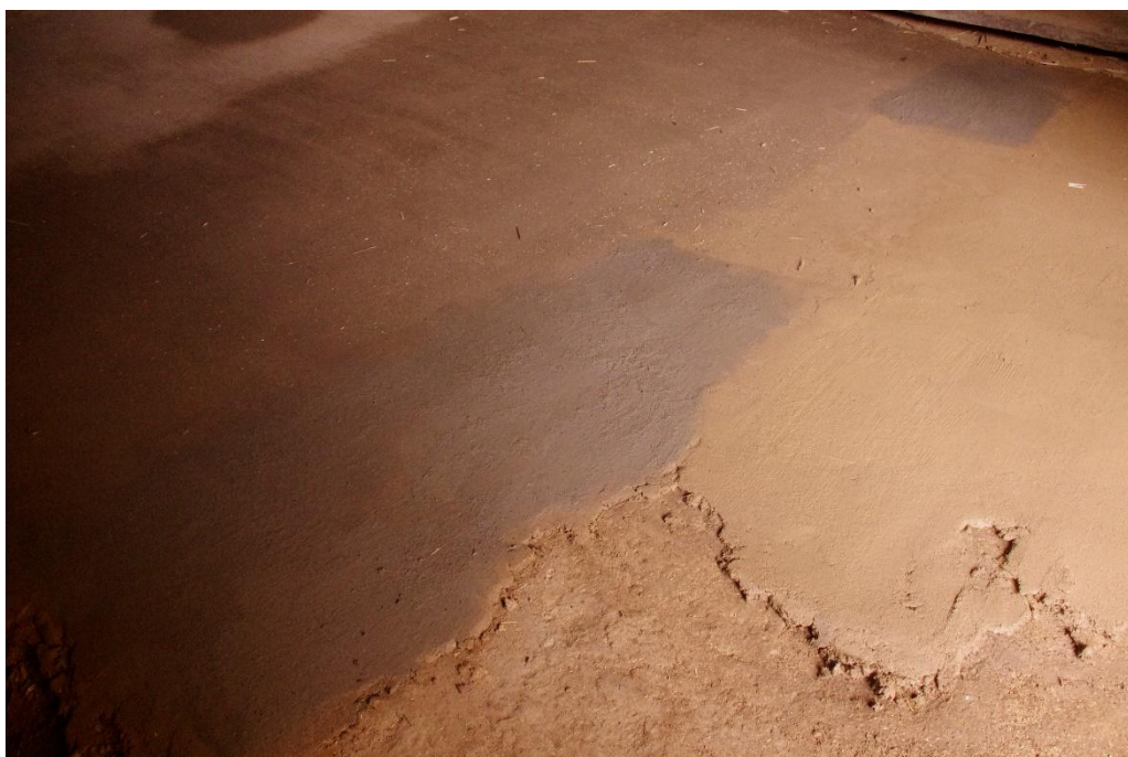
Obr. 15.: Zatírání povrchové vrstvy kravským lejmem
