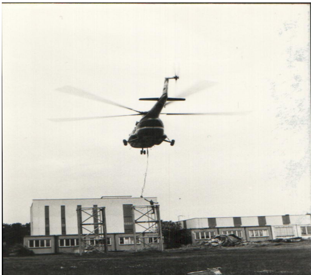
Montáž anténního systému radioreléové trasy mezi SVT a ÚTZCHT v Suchdole v červenci 1985 s pomocí vrtulníku Slovairu.
