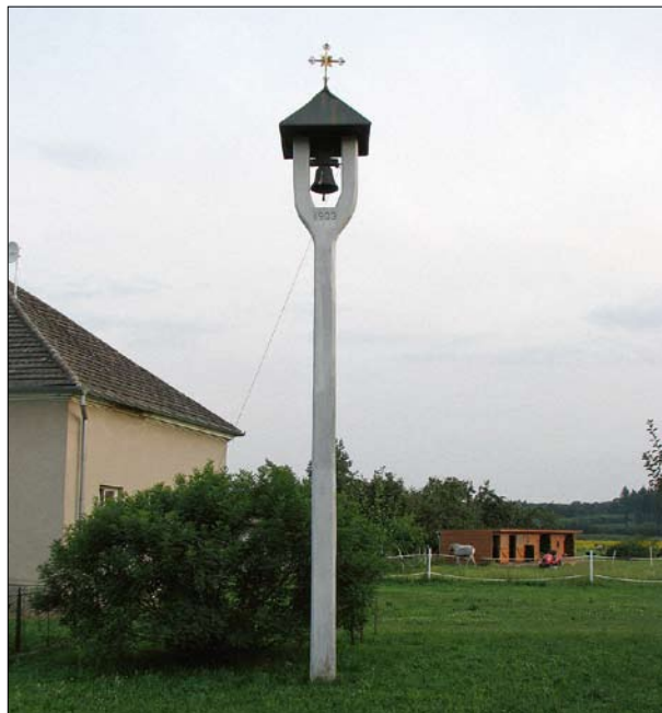
Břístev, okr. Nymburk, betonová zvonička z r. 1933 (foto P. Vácha, 2014).
