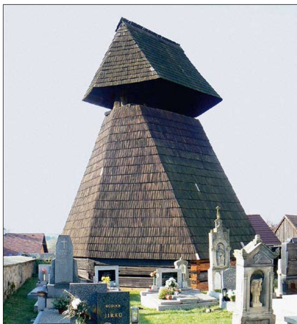
Osek u Sobotky, okr. Jičín. Šestiboká dřevěná zvonice. Základem stavby je vysoká zvonová stolice vzpěradlové konstrukce krytá šindelovou střechou (foto P. Vácha, 2014).
