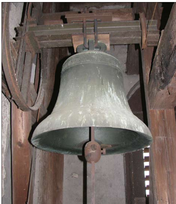
Veltruby, okr. Kolín. Novodobé srdce s posuvnou pěstí jištěnou šroubem (foto P. Vácha, 2013).
