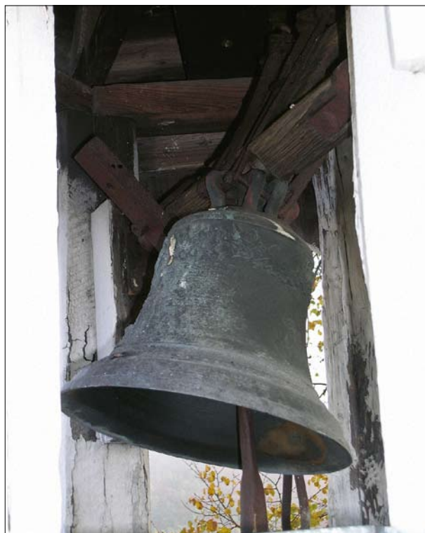
Nová Ves pod Pleší, okr. Příbram. Zvon z 18. století nebezpečně uvolněný v hlavě, srdce je značně podvěšeno (foto P. Vácha, 2005).
