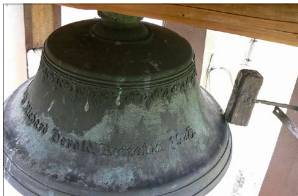
Prostřední Staré Buky, okr. Trutnov, kostel sv. Anny. Zvonovitý hodinový cimbál z r. 1923 s talířovou korunou. Kládívo z boku (foto P. Vácha, 2015).
