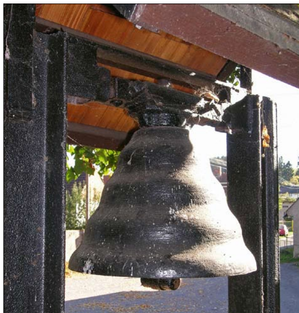
Hlubyně, okr. Příbram, tenkostěnný zvon zvlňného profilu, kolem r. 1920 (foto P. Vácha, 2005).
