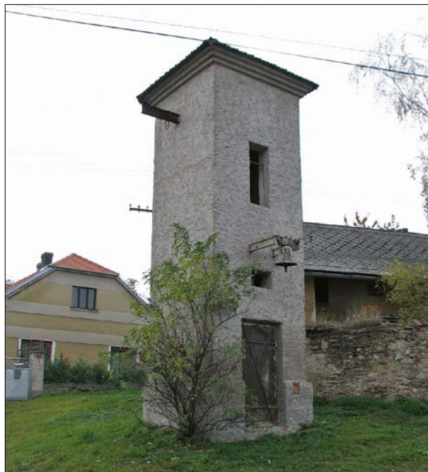
Krupá, okr. Kutná Hora, zvon zavěšený na průčelí transformátoru (foto P. Vácha, 2010).
