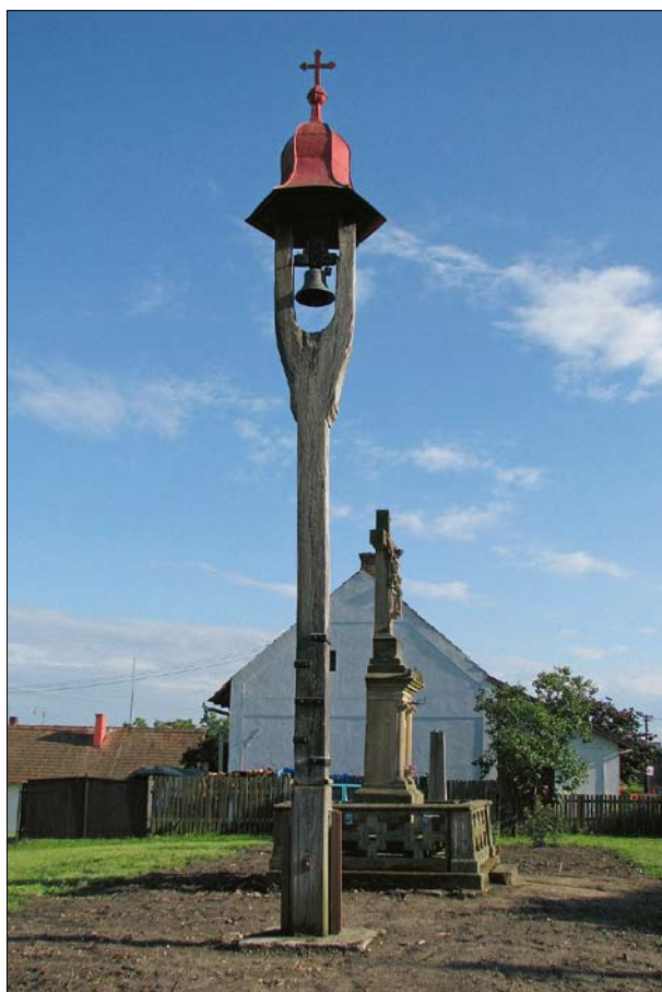
Pojedy, okr. Nymburk, dřevěná sloupová zvonička z jednoho kusu rozřezaného kmene stromu – rozsocha (foto P. Vácha, 2009).
