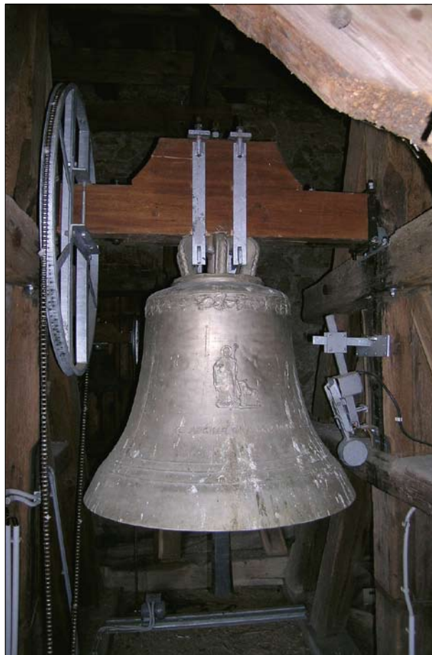
Hořovice-Velká Víska, okr. Beroun. Zvon z r. 2001 s elektropohonem a elektromagnetickým kládívem pro odbíjení hodin (foto P. Vácha, 2005).
