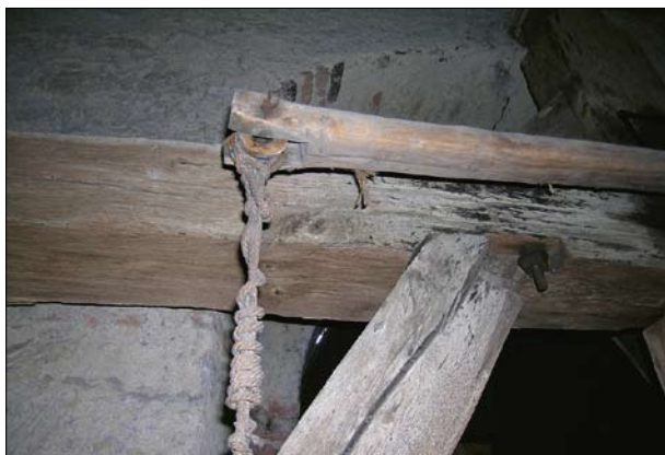
Břežno, okr. Mladá Boleslav, zvonice kostela sv. Václava. Páka zvonu s kladkou, která šetří provaz před opotřebením (foto P. Vácha, 2008).
