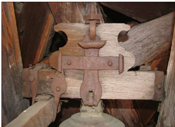
Přerov nad Labem, okr. Nymburk. Sloupková koruna zvonu, upevněná jedním třmenem, polovina 18. století (foto P. Vácha, 2010).
