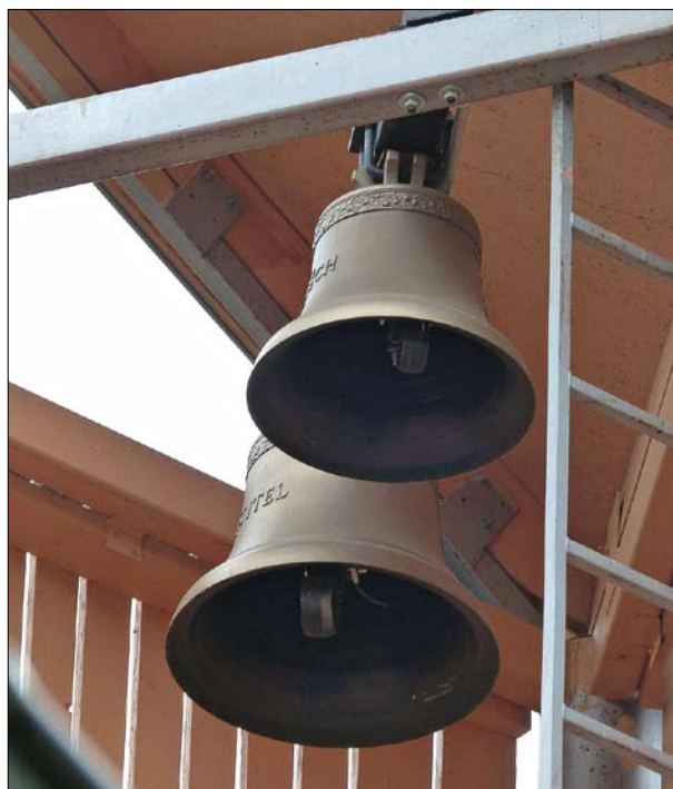
Dolní Kralovice, okr. Benešov, zvonice u hřbitova. Nepohyblivě zavěšené zvony s elektromagnetickými kladivy uvnitř. Na stavební konstrukci nepůsobí dynamické zatížení (foto P. Vácha, 2015).
