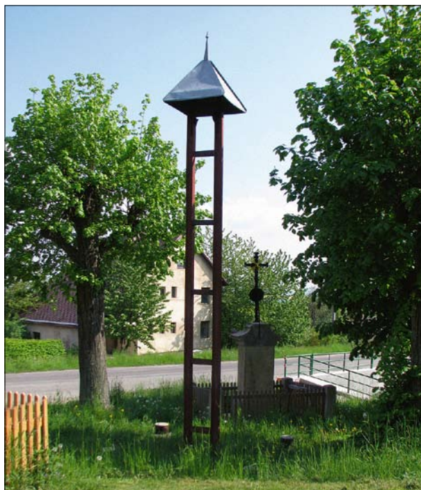
Prachov, okr. Jičín, železná dvousloupová zvonička žebříkové konstrukce (foto P. Vácha, 2014).
