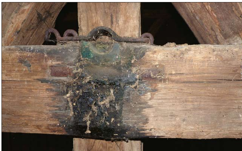
Králova Lhota, okr. Rychnov nad Kněžnou, kostel sv. Zikmunda. Kluzné ložisko s petlicí (foto P. Vácha, 2015).
