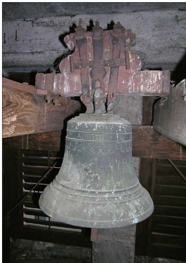
Velký Osek, okr. Kolín, zvon z r. 1750 s původním vybavením. Zvon je upevněn třmeny tvaru „Y“ a třmeny se skobami, spony a přepásání mají svinuté konce (foto P. Vácha, 2004).
