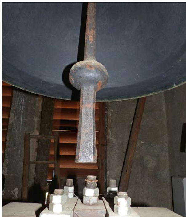
Oučáry, okr. Kolín, zvon z r. 2002. Srdce německé provenience s elipsoidní pěstí (foto P. Vácha, 2016).
