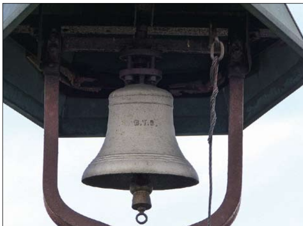
Doupě, okr. Jihlava, ocelový zvon ze 40. let 20. století litý Bochumskou ocelárnou, s originálním srdcem. Dodatečně natřený stříbrnou (foto P. Vácha, 2016).
