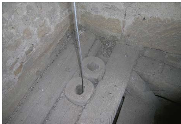
Litice, okr. Plzeň-město, kostel sv. Petra a Paula, dřevěné průchodky pro vedení provazů od zvonů (foto P. Vácha, 2009).
