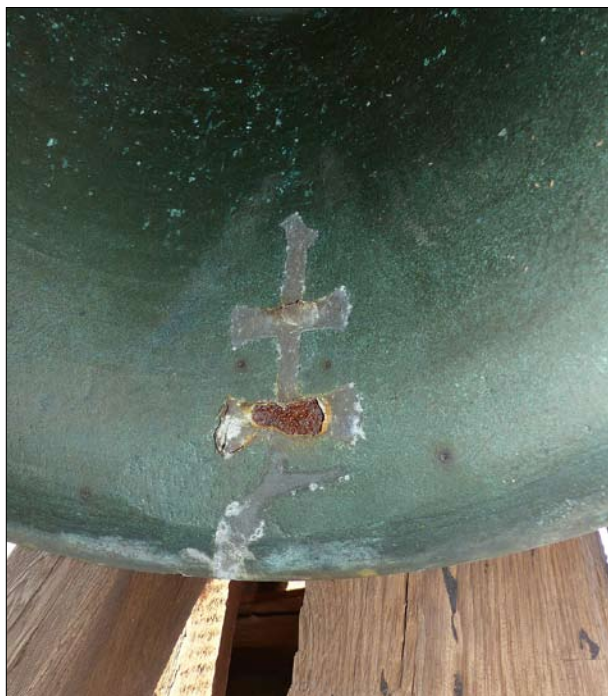
Mohelnice, okr. Mladá Boleslav. Historická oprava puklého zvonu (pravděpodobně v 19. stol.). Propilovaná puklina byla stažena zasekanými železnými motýlovitými sponami (zvenčí třemi, zevnitř dvěma) a zalita olovem. Zvon byl uveden do funkčního stavu, objevila se ale puklina na i protější straně (foto P. Vácha, 2016).
