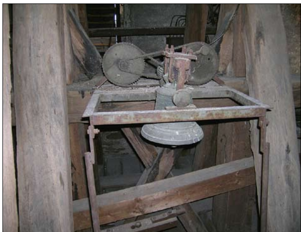
Kácov, okr. Kutná Hora, Příbram, hřbitovní kaple. Elektropohon zvonů zavěšených na lomených hřidelích, pohon ojnicí s převodem přes 2 kola na pomalý chod (foto P. Vácha, 2011 a 2015).
