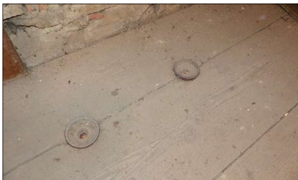
Velké Albrechtice, okr. Nový Jičín, kostel sv. Jana Křtitele. Skleněné průchodky pro provazy (přelom 19. a 20. stol.). Opotřebením skleněné průchodky i provazu je minimální (foto P. Vácha, 2015).
