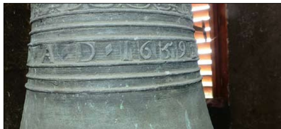
Kutná Hora, kostel Věch svatých. Zvon z r. 1659 od Benedicta Briota. Charakteristickým znakem tohoto zvonaře jsou písmena na obdélníkových ploškách (foto P. Vácha, 2016).
