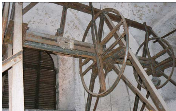
Praha-Nové Město, kostel Nanebevzetí P. Marie a sv. Karla Velikého. Pohled do ocelové zvonové stolice vzpěradlové konstrukce z r. 1939 s hlavami rekvirovaných zvonů (foto P. Vácha, 2015).
