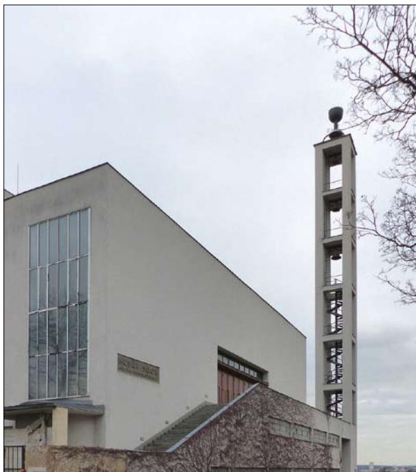
Praha-Vinohrady, Husův sbor, otevřená železobetonová zvonice (foto P. Vácha, 2015).
