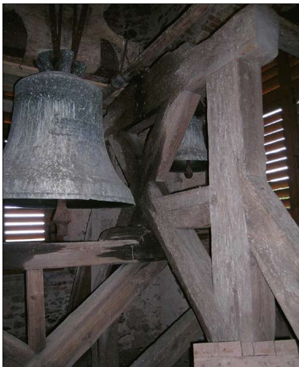
Všesulov, okr. Rakovník, dubová zvonová stolice štenýřovo-vzpěradlové konstrukce s příčnou vazbou (foto P. Vácha, 2009).
