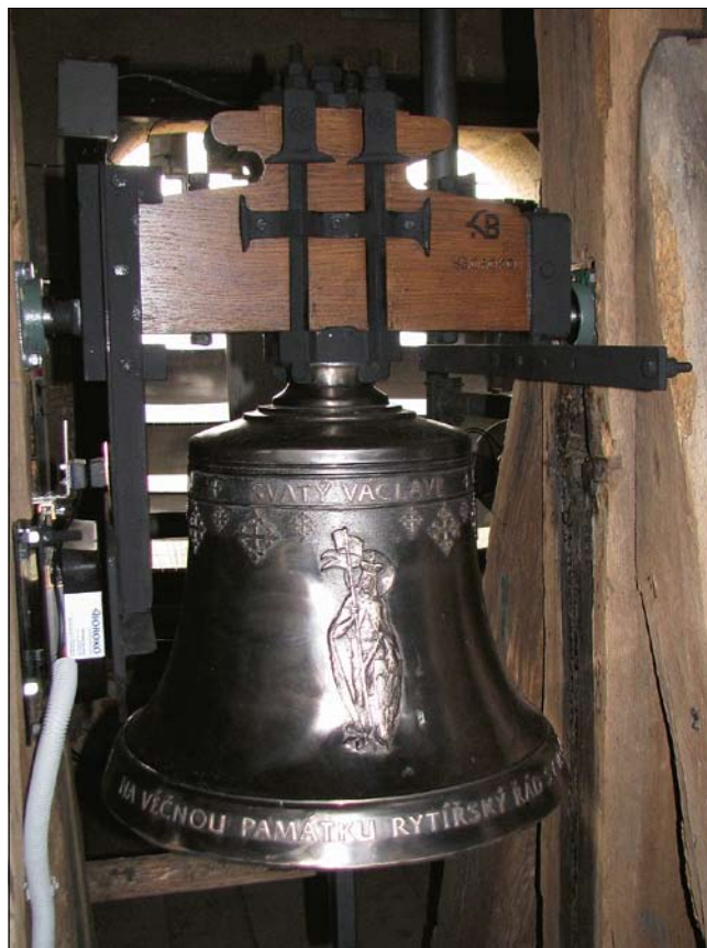
Choojen, okr. Benešov. Zvon z r. 2012 s přírubovými domkovými valivými ložisky a s pohonem lineárním motorem (foto P. Vácha, 2012).
