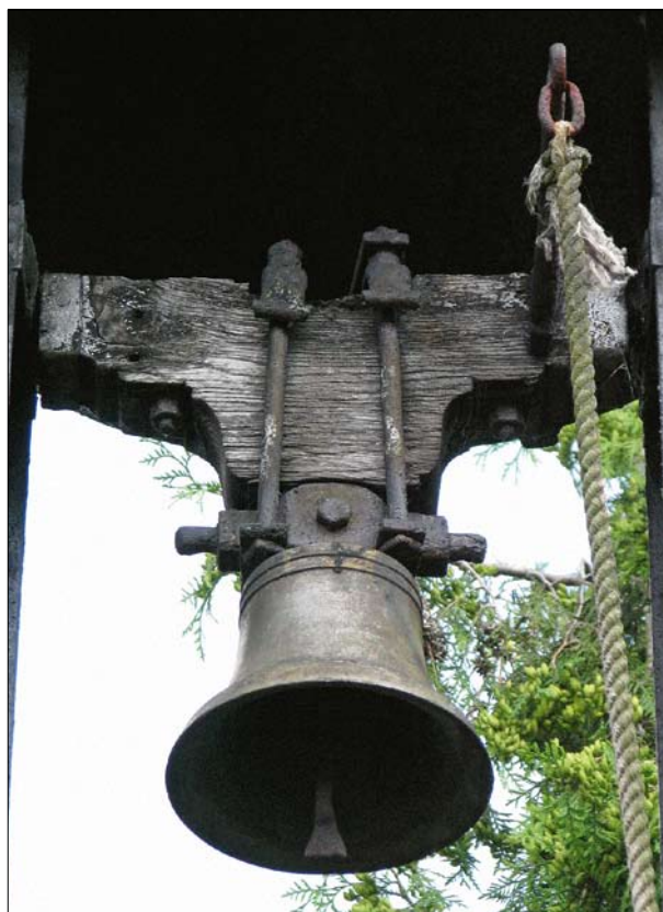
Syrovátká, okr. Hradec Králové. Zvon přenesený po rekvizici, zavěšený na překocené dřevěné hlavě původního zvonu s ponecháním původní železné hlavy. Snížené zavěšení na překocené hlavě umožňuje lepší dobíhání srdce a zpomaluje frekvenci úderů (foto P. Vácha, 2013).
