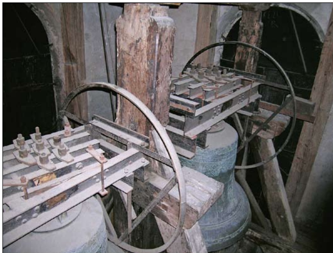
Velehrad, okr. Uherské Hradiště, basilika. Zvoony s ocelovými hlavami ve tvaru horizontálního rámu (foto P. Vácha, 2004).
