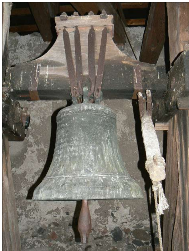
Lštění-Hradiště, okr. Benešov, zvon z r. 1601. Značně podvěšené srdce a utřžený třmen páky (foto P. Vácha, 2015).
