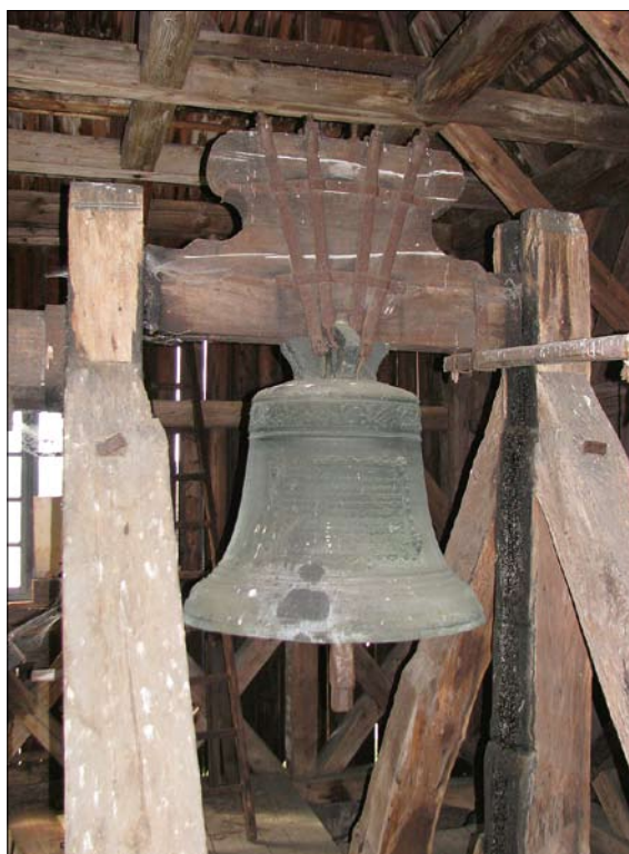
Políčka, okr. Svitavy, kostel sv. Jakuba. Nová dubová zvonová stolice vzpěradlové konstrukce se zvony zavěšenými ve dvou úrovních (foto P. Vácha, 2015).
