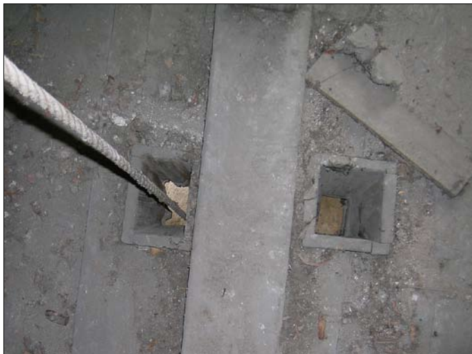
Tetín, okr. Beroun, zvonice kostela sv. Kateřiny. Průchod provazu otvorem s prkenným obložním (foto P. Vácha, 2004).
