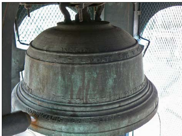
Slaný, okr. Kladno, radnice. Zvonovitý cimbál z r. 1740 s korunou s dvěma uchy. Kládívo vedeno orchem (foto P. Vácha, 2015).
