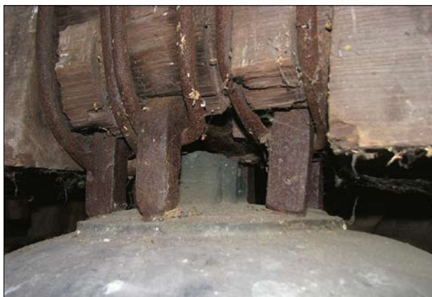
Lažánky, okr. Brno-venkov, zvon z r. 1534. Puklina opravená svařením v polovině 20. století. (Foto P. Vácha, 2015).
