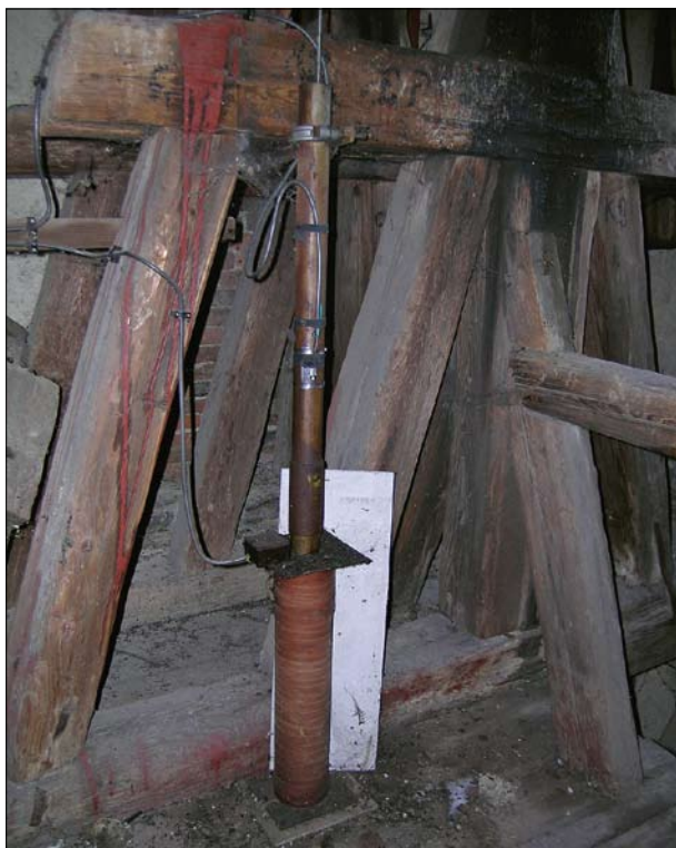
Břežová nad Svitavou, okr. Svitavy, zvon z r. 1524. Elektromagnetická pumpa – pohon založený na principu vtažení železného závaží do elektromagnetu. Zároveň bylo upoutáno srdce, a tak byl zvon poškozován (foto P. Vácha, 2006).
