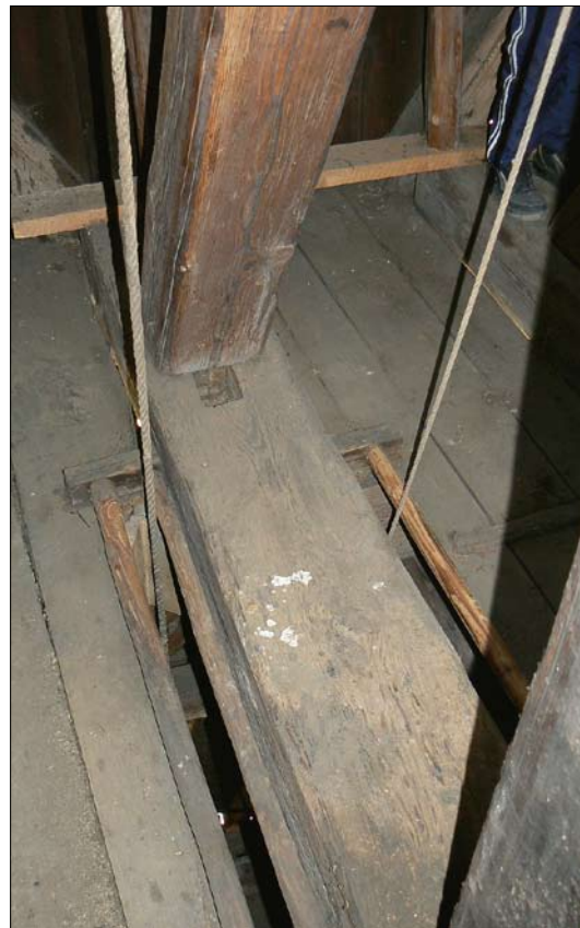
Tetín, okr. Beroun, zvonice kostela sv. Kateřiny. Průchod provazu otvorem s prkenným obložním (foto P. Vácha, 2004).
