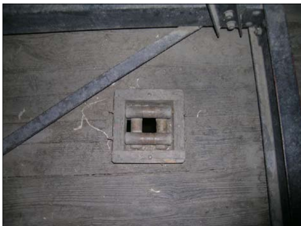
Košice (Slovensko), dóm sv. Alžběty. Otvor pro vedení provazu, usměřňovaného čtyřmi kladkami (foto P. Vácha, 2015).
