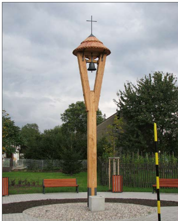
Želkovice, okr. Hradec Králové, zvonička sloupová s vidlicí připevněnou šrouby (foto P. Vácha, 2013).
