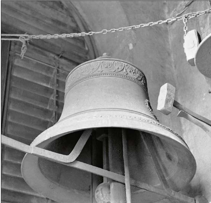
Libice nad Cidlinou, okr. Nymburk, evangelický kostel. Zvon z r. 1895 od Carla Schwabe, původní stav. Litinové stojany Patent Schwabe. (Foto P. Vácha, 1978 a 2003.)
