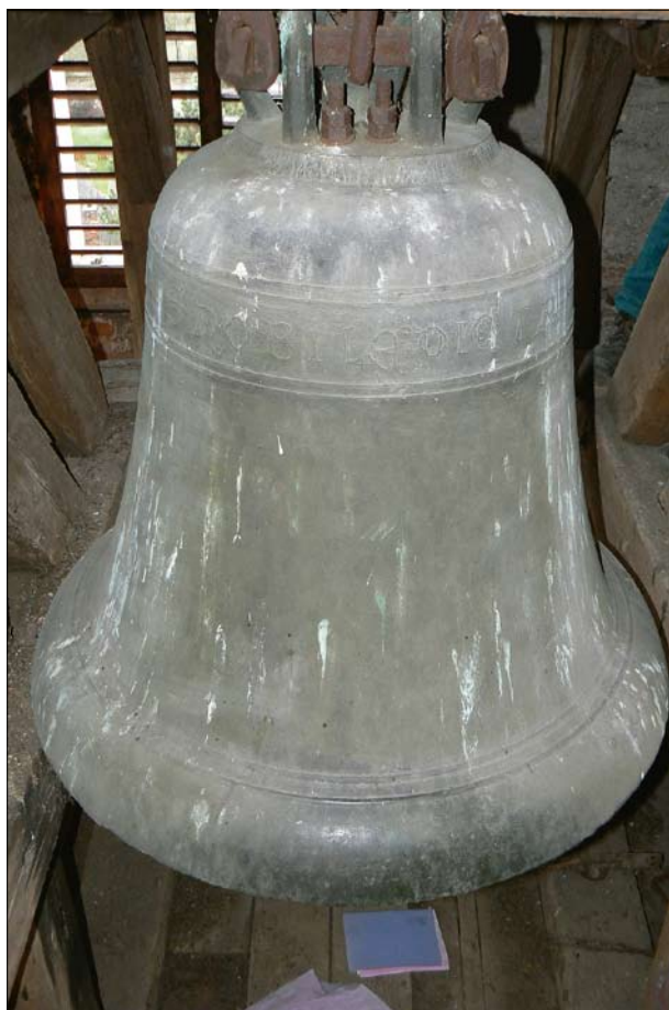
Vranov, okr. Benešov, zvon z 14. století s nápisem provedeným lineárně, vyrytím do svrchní části formy. Šrouby mezi uchy je druhotně připevněn závěs srdce (foto P. Vácha, 2014).
