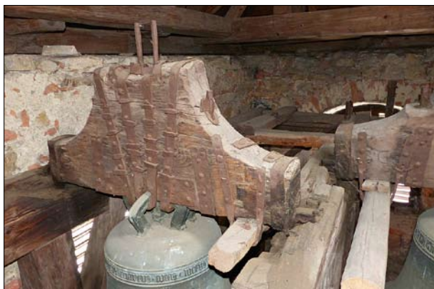
Velké Albrechtice, okr. Nový Jičín. Původní hlava zvonu z r. 1508. Archaický způsob upevnění zvonu třmeny přibíjenými hřeby a skobami. Místo závitů s maticemi je užito klínů zarážených do štěrbin (foto P. Vácha, 2015).
