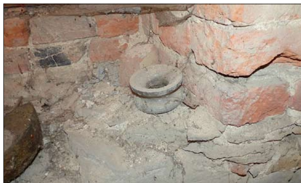
Velké Albrechtice, okr. Nový Jičín, kostel sv. Jana Křtitele. Skleněné průchodky pro provazy (přelom 19. a 20. stol.). Opotřebením skleněné průchodky i provazu je minimální (foto P. Vácha, 2015).
