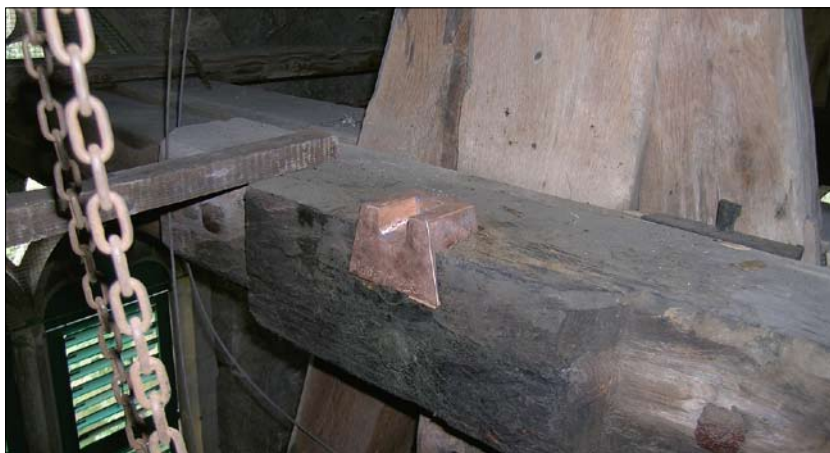
Poděbrady, okr. Nymburk, kostel Povýšení sv. Kříže. Bronzové kluzné ložisko, zhotovené podle původního (foto P. Vácha, 2007).
