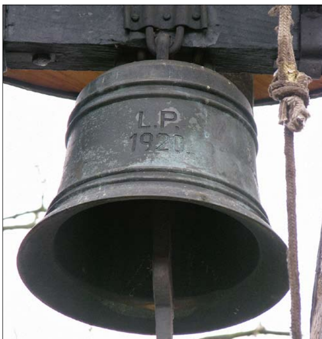
Bukovka, okr. Pardubice. Zvon z r. 1920. Novodobý decimový zvon (se spodním tónem v intervalu decimy) s nápisem provedeným do hloubky (foto P. Vácha, 2011).
