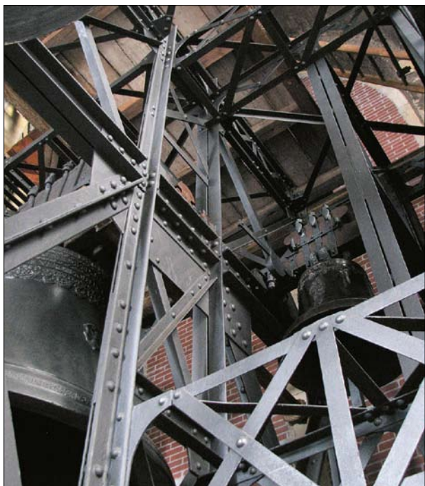
Praha-Nové Město, kostel Nanebevzetí P. Marie a sv. Karla Velikého. Pohled do ocelové zvonové stolice vzpěradlové konstrukce z r. 1939 s hlavami rekvirovaných zvonů (foto P. Vácha, 2015).
