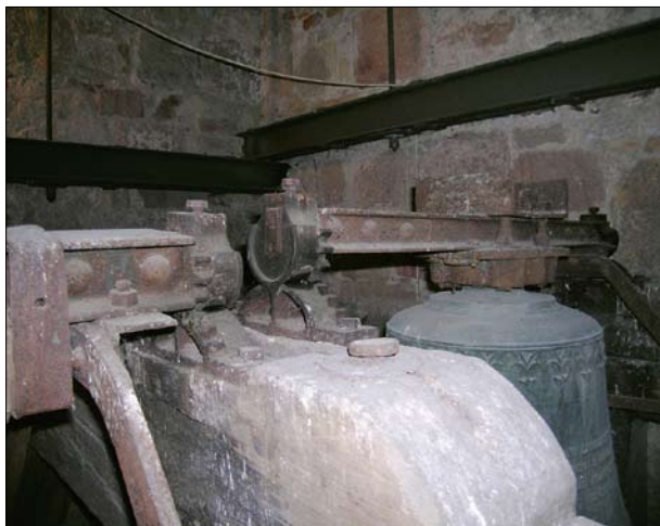
Litice, okr. Plzeň-město. Zvony na přímých (rovných) ocelových hlavách s ozubenými čepy převalujícími se po obloukových hřebenech. Zavěšení Rudolf Perner, 1927 (foto P. Vácha, 2009).
