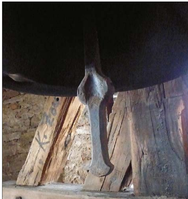
Votice, okr. Benešov, zvon z r. 1733. Oprava otlučené pěstí srdce. Aby bylo docíleno potřebného toaru, byl materiál překováním vyhnán ze středu k okraji (foto P. Vácha, 2015).
