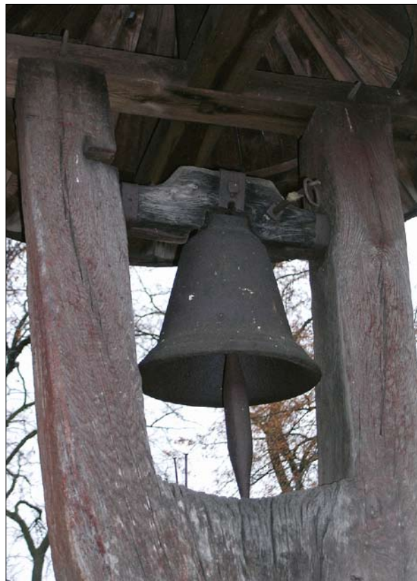
Různé typy ocelových zvonů, které byly náhradou za zvony rekvírované v I. světové válce: Zvánovice, okr. Praha-východ, Němčice, okr. Kolín, zvony neurčené provenience z let 1919–1920, dodávané s roubíkovitým srdcem (foto P. Vácha, 2006 a 2004).
