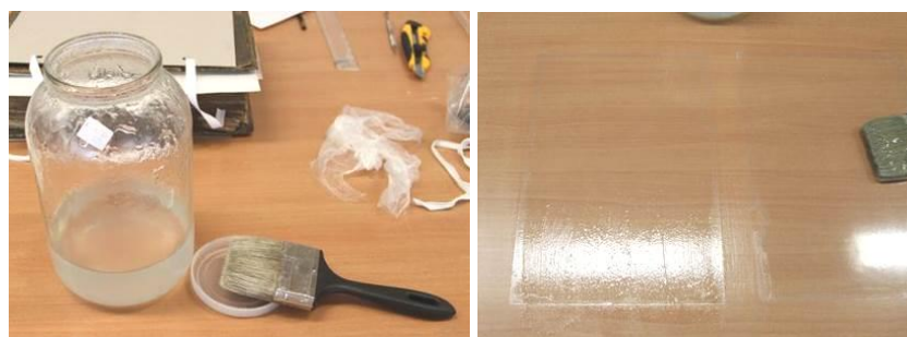
Obr. 47 Nanesení lepidla širokým plochým štětcem.
