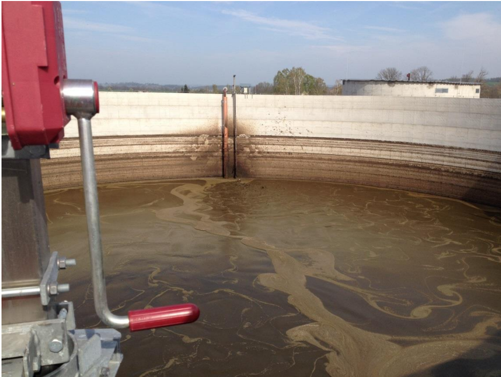
Obr. 1. Homogenizace kapalných organických hnojiv (digestát) v nádrži pro 6000 t pomocí homogenizátorů MEZ, a.s. Nedvědice /ČR/ (foto J. Dostál).
