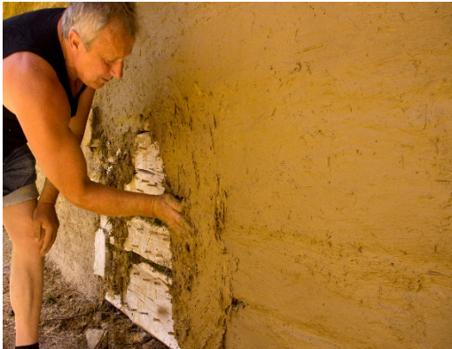
Obr. 9: Aplikace hliněné omítky ( lepenice ) na roubené stěny
