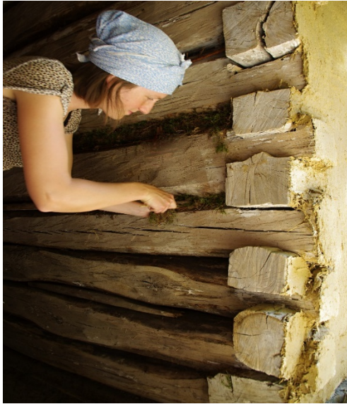
Obr. 5: Vycpávání spár srubu mechem
