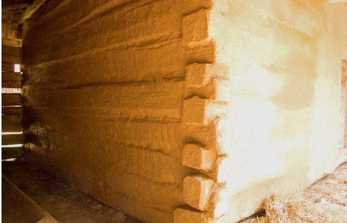
Obr. 11: Roubený objekt opatřený hliněnou omítkou
