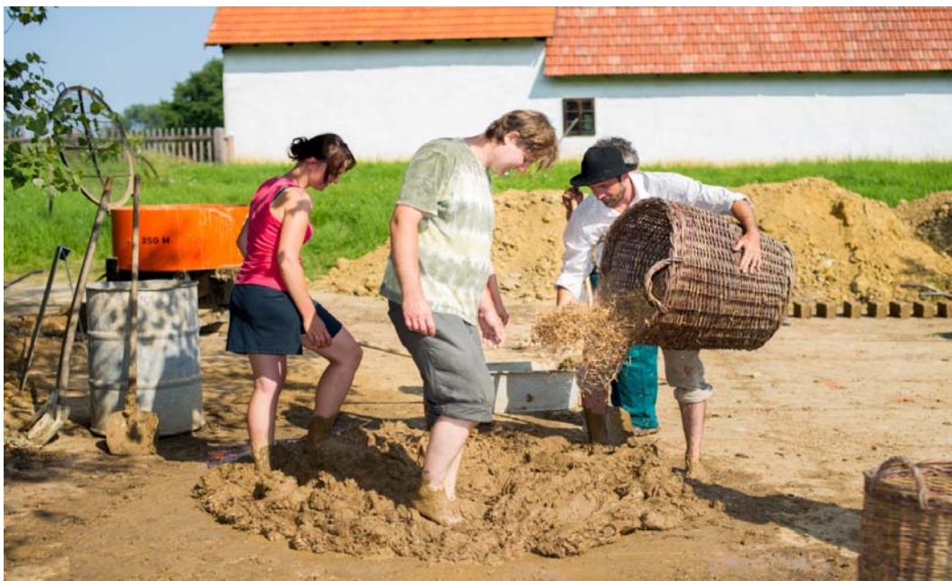
Obr. 4.: Výroba hliněného těsta pomocí vyšlapávání
