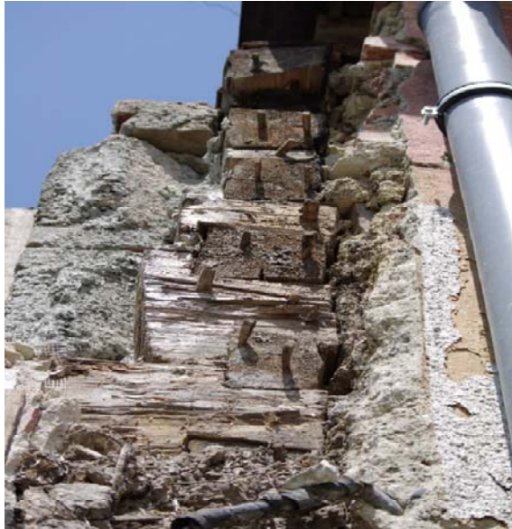
Obr. 6: Relikt recentní roubené stěny opatřené mechanickou oporou (kolíčky z tvrdého dřeva)
