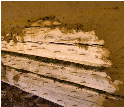
Obr. 8: Roubená stěna opatřená mechanickou oporou – kolíky ( ježky ) z tvrdého dřeva a připravena k omítání
