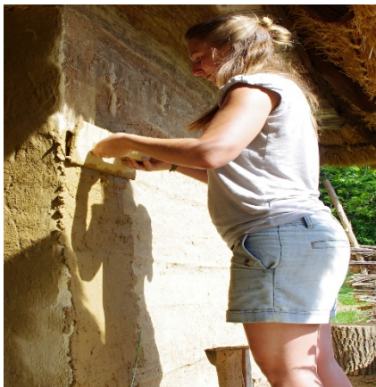
Obr. 10: Aplikace finální (štukové) vrstvy omítky
