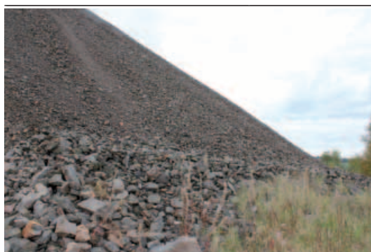
Halda – Lešetice Klasifikace: odkaliště sodné strusky Skutečnost: halda hlušiny z uranového dolu s různorodým horninovým materiálem Zdroj: foto © Z. Suchánek
