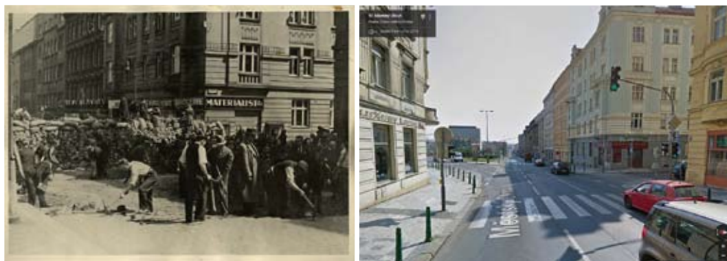
Obr.18: Neznámý autor, Stavba barikády ve Veletržní ulici, květen 1945. Záběr aplikace Google Street View slouží k ověření lokace zobrazení především v městském prostředí.
