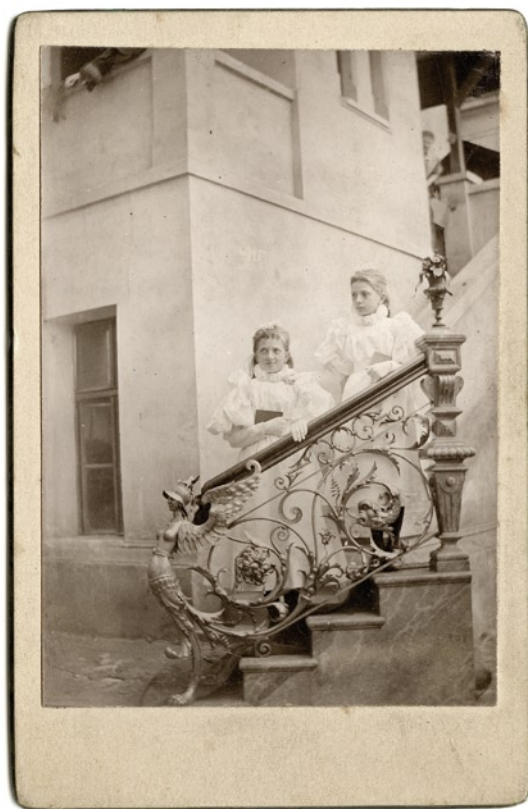
Část schodišového zábradlí podle návrhu Ladislava Haněla, 1890-91 zhotoveno pro Jubilejní zemskou výstavu v Praze 1891
