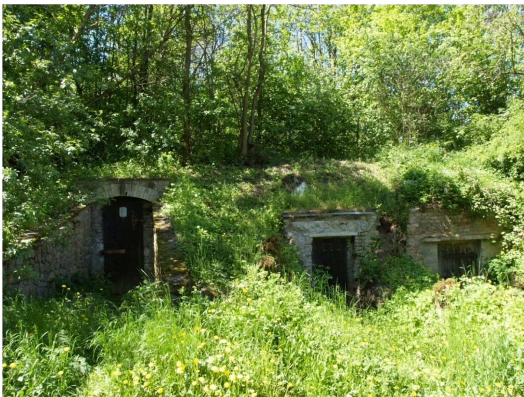
Foto 13: Sklepy vyhloubené v nánosech spraše na okraji výmladkového lesa u obce Rokytná
