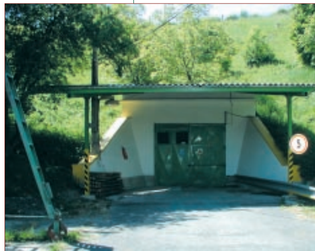
Vstup do podzemních prostor úložiště radioaktivních odpadů Richard
