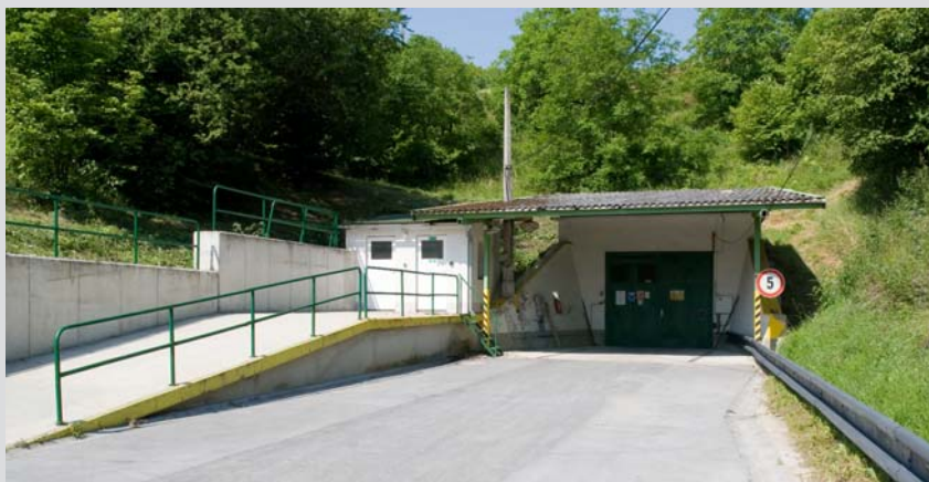
Vstupní portál úložiště Richard.
