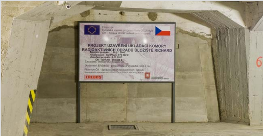
Projekt „Realizace uzavření komor v úložišti Richard“, uzavřená komora.
