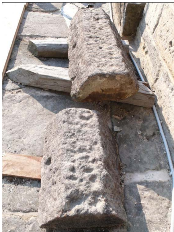
18) Hrad Kost, severovýchodní hradba jádra hradu, detail „hřebenáčů“ po jejich doplnění umělým kamenem (foto T. Rafl 2012).
