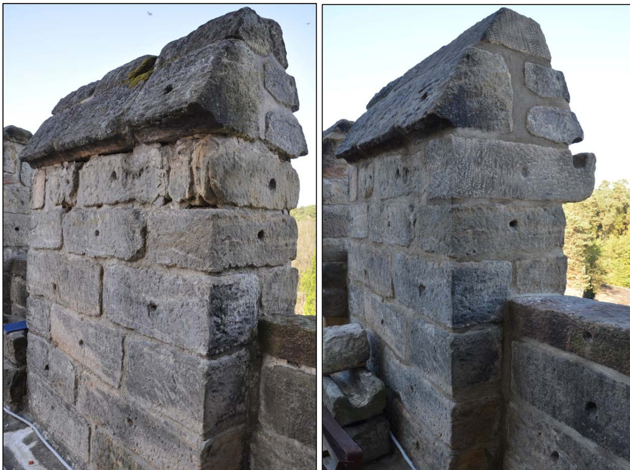
23) Hrad Kost, severovýchodní hradba jádra hradu, 2. stínka od jihu, pohled od jihu. Stav před obnovou a po obnově (foto M. Panáček 2012).
