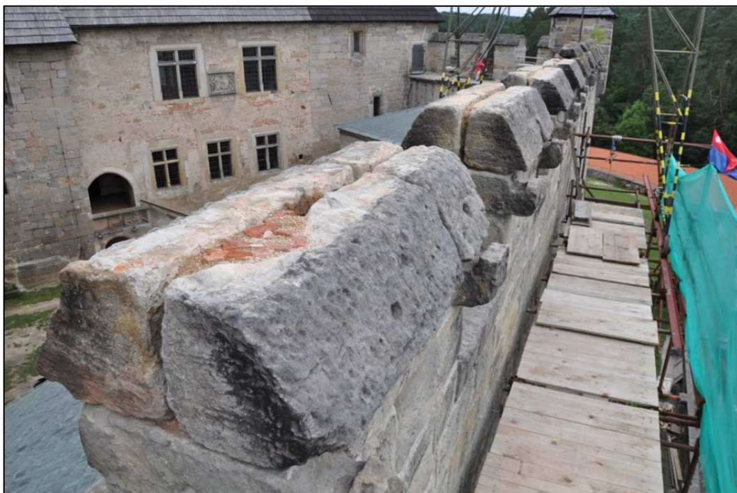
16) Hrad Kost, severovýchodní hradba jádra hradu, snímání „hřebenáčů“ v průběhu obnovy, pohled od jihovýchodu (foto M. Panáček 2012).
