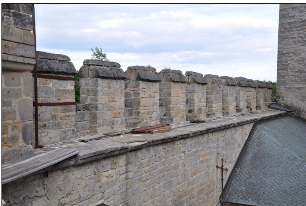
2) Hrad Kost, severovýchodní hradba jádra hradu, vnitřní strana, pohled od severozápadu, stav před obnovou (foto M. Panáček 2012).
