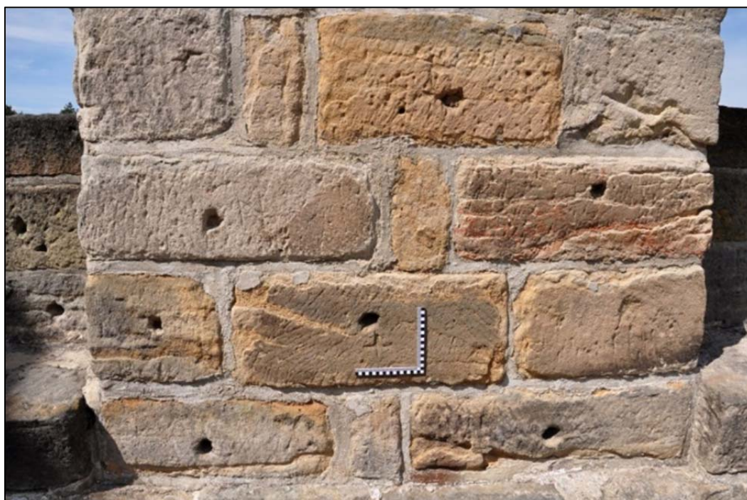
12) Hrad Kost, severovýchodní hradba jádra hradu, stínka cimbuří. Detail skladby zdiva, tvaru kvádrů a jejich opracování včetně kamenických značek, stav před obnovou (foto M. Panáček 2012).
