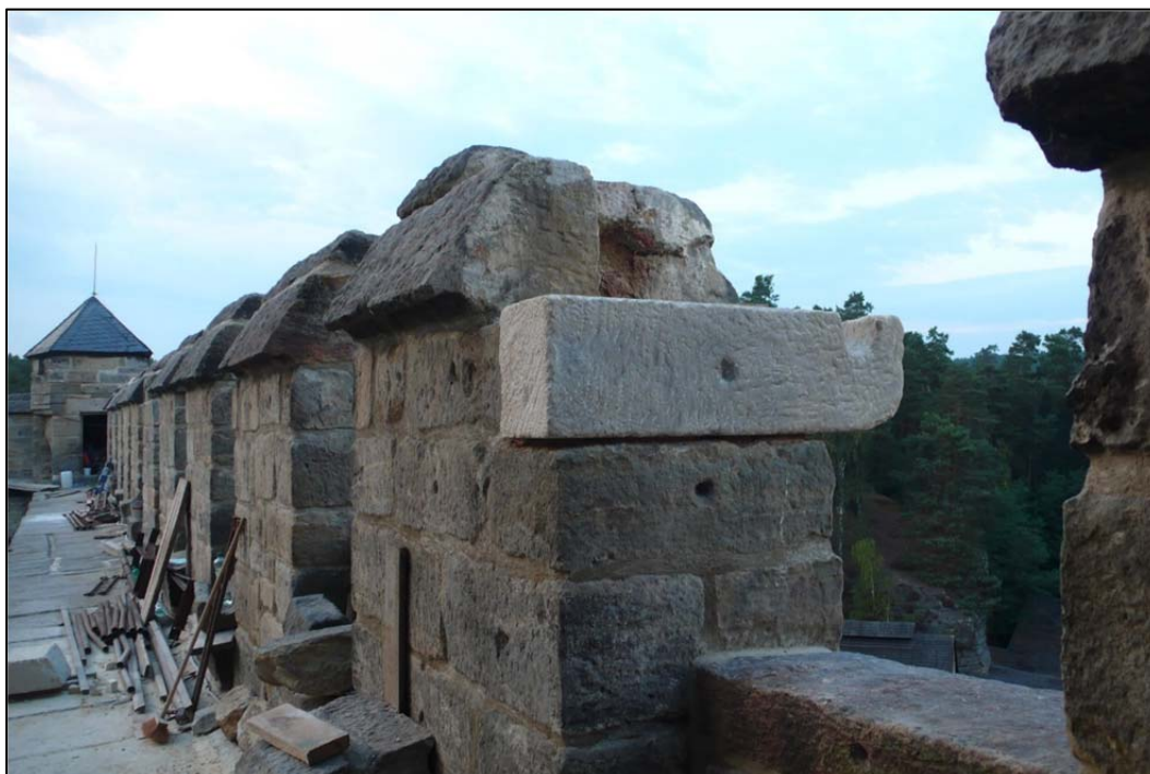
19) Hrad Kost, severovýchodní hradba jádra hradu, detail výměny krakorcového háku (foto T. Rafl 2012).
