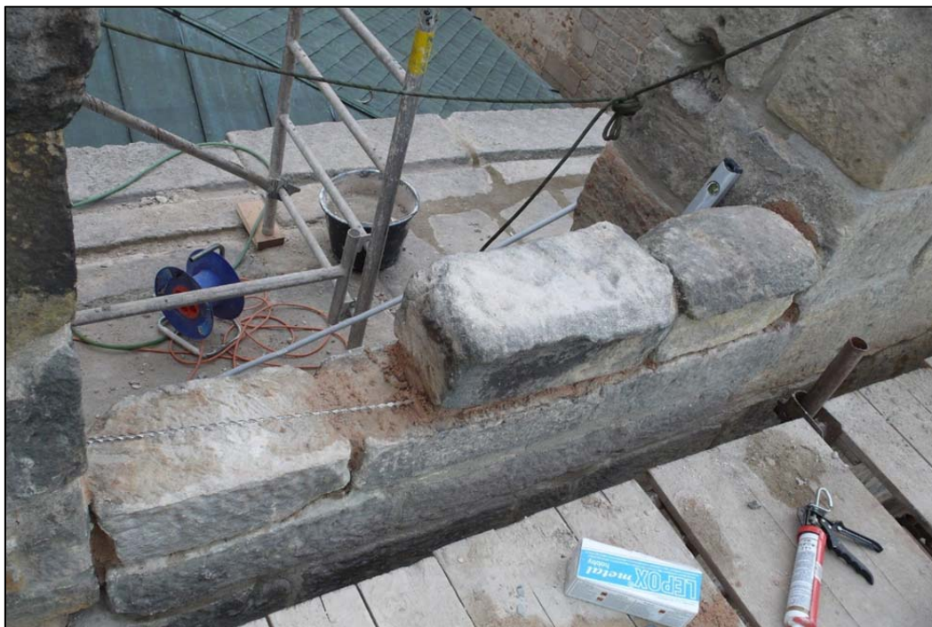
21) Hrad Kost, severní hradba jádra hradu, detail zpevnění části zdiva pomocí Helifixu (foto T. Rafl 2012).
