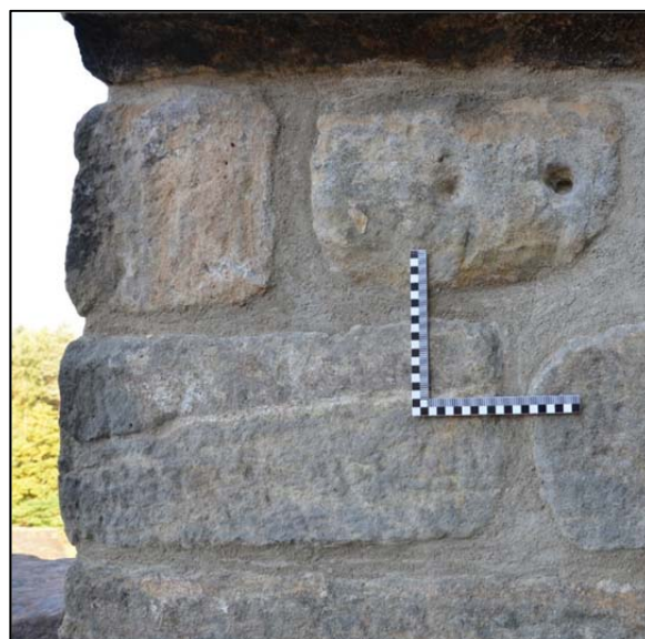
15) Hrad Kost, severovýchodní hradba jádra hradu, detaily stavu po odstranění nepůvodního poškozujícího spárování a doplnění nového (foto M. Panáček 2012).
