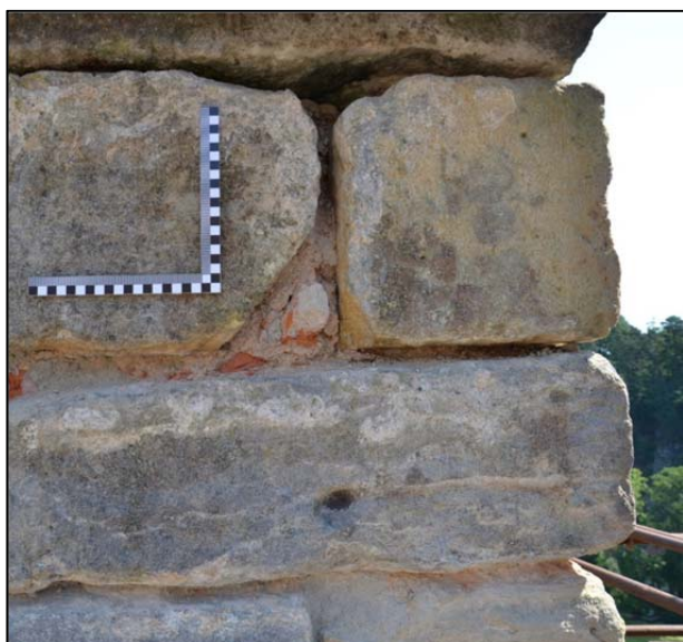
15) Hrad Kost, severovýchodní hradba jádra hradu, detaily stavu po odstranění nepůvodního poškozujícího spárování a doplnění nového (foto M. Panáček 2012).
