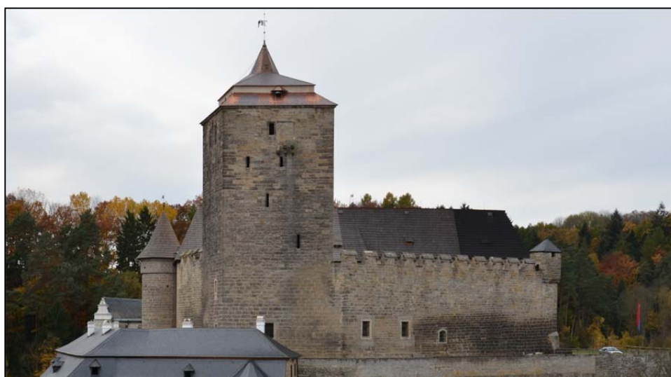
24) Hrad Kost, jádro hradu, pohled od východu. Stav po obnově cimbuří (foto M. Panáček 2013).
