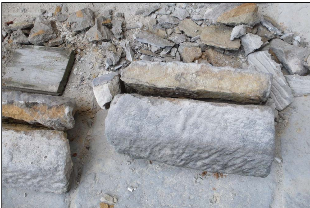
17) Hrad Kost, severovýchodní hradba jádra hradu, detail „hřebenáčů“ po jejich sejmutí a odstranění narušených částí a spojovací malty (foto T. Rafl 2012).
