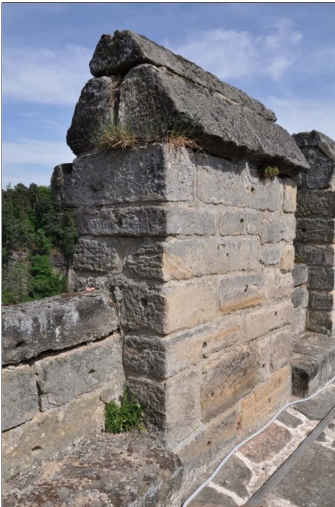
5) Hrad Kost, severovýchodní hradba jádra hradu, 7. stínka od jihu, pohled od severozápadu, stav před obnovou (foto M. Panáček 2012).
